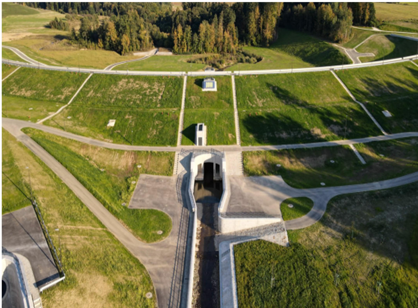
Fot. 4 Widok na upust denný zapory.
