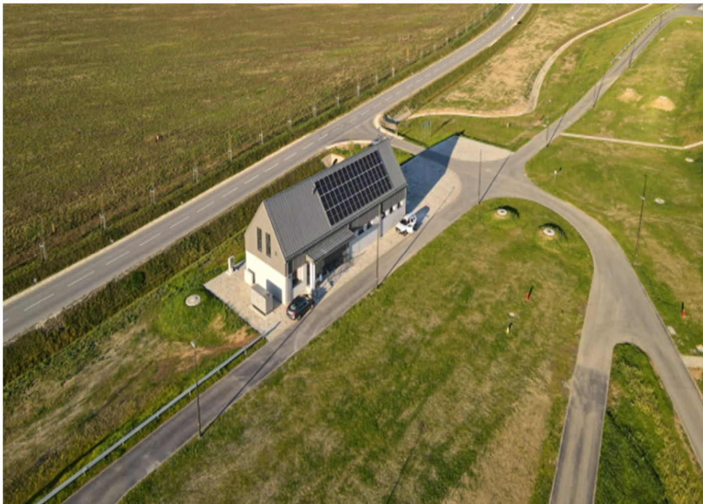
Fot. 5 Widok na budynek obsługi technicznej zapory.
