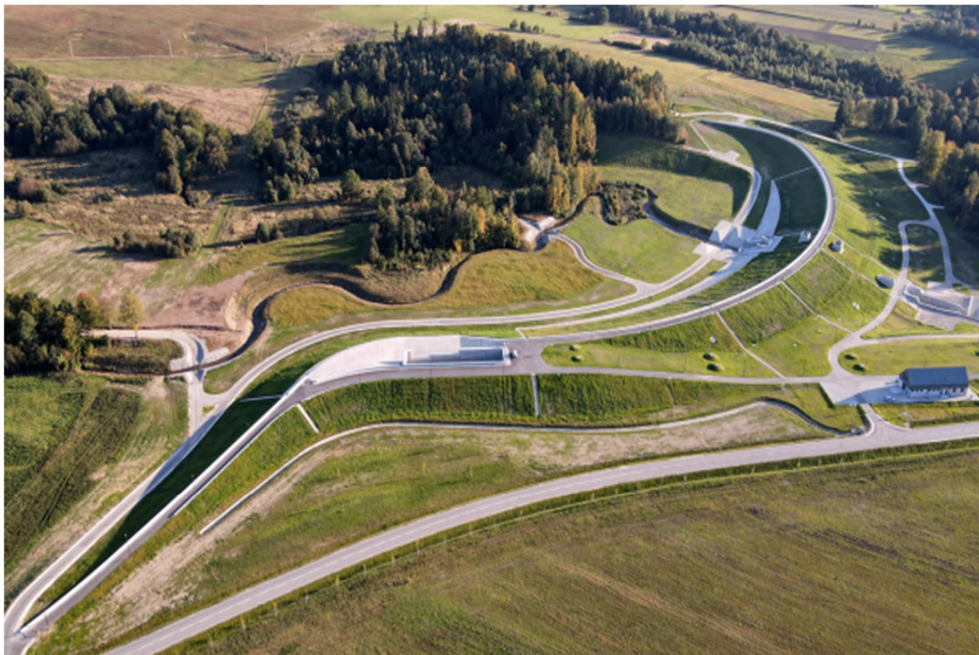
Fot. 6 Widok na zaporę i część zbiornika.
