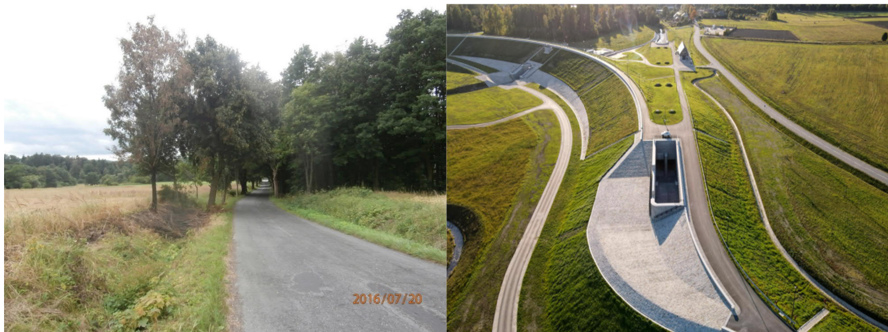
Fot. 3 Odcinek drogi powiatowej nr 3233D przebiegający przez obszar prawobrzeżnego przyczółka zapory.
