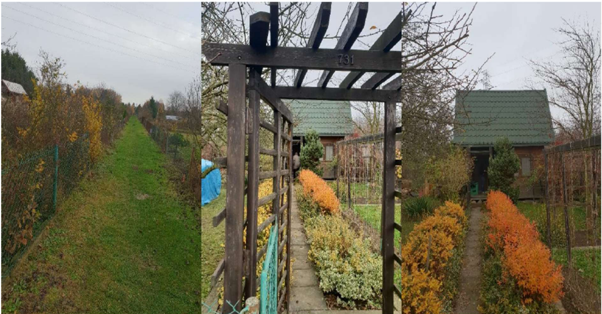
Foto. 1. Stan Terenu Budowy przed rozpoczęciem realizacji robót – ogródki działkowe na ROD SEMAFOR.
