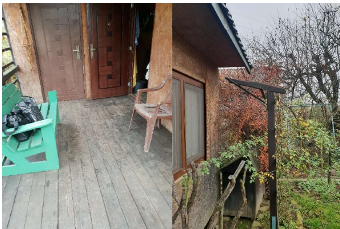
Foto. 4. Stan Terenu Budowy przed rozpoczęciem realizacji robót – ogródki działkowe na ROD SEMAFOR.
