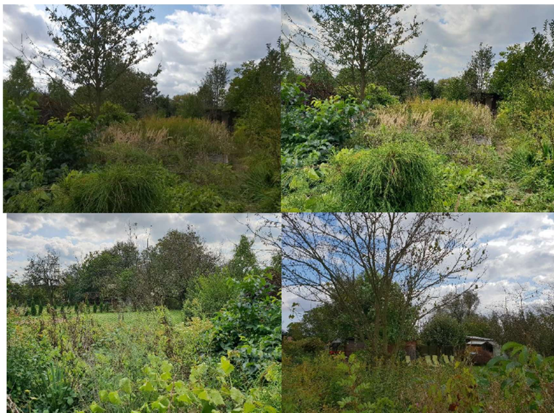
Foto. 8. Stan Terenu Budowy przed rozpoczęciem realizacji robót – ogródki działkowe na ROD SEMAFOR.
