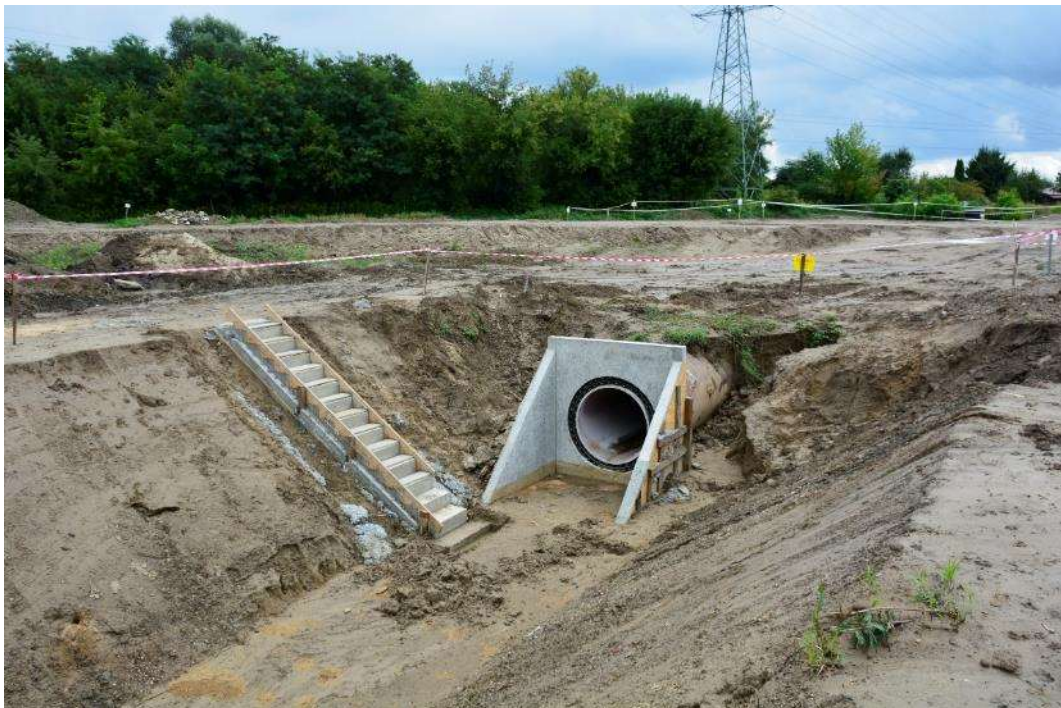
Foto. 19. Obszar realizacji wykopu pod kanał burzowy, 3. dekada sierpnia 2021 r.
