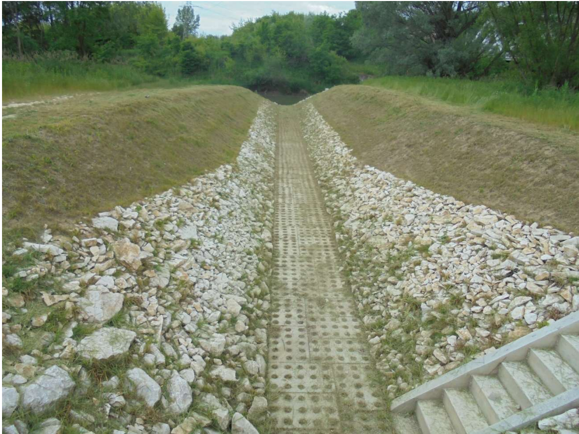
Foto. 25. Nowy wał rz. Białej po zakończeniu budowy.
