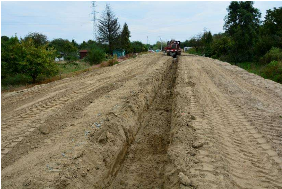
Foto. 20. Wykop pod przesłonę przeciwnfiltracyjną, 2. dekada września 2021 r..
