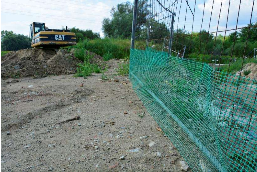
Foto. 16. Widok na wygradzenie wykopu, 3. dekada lipca 2021 r..
