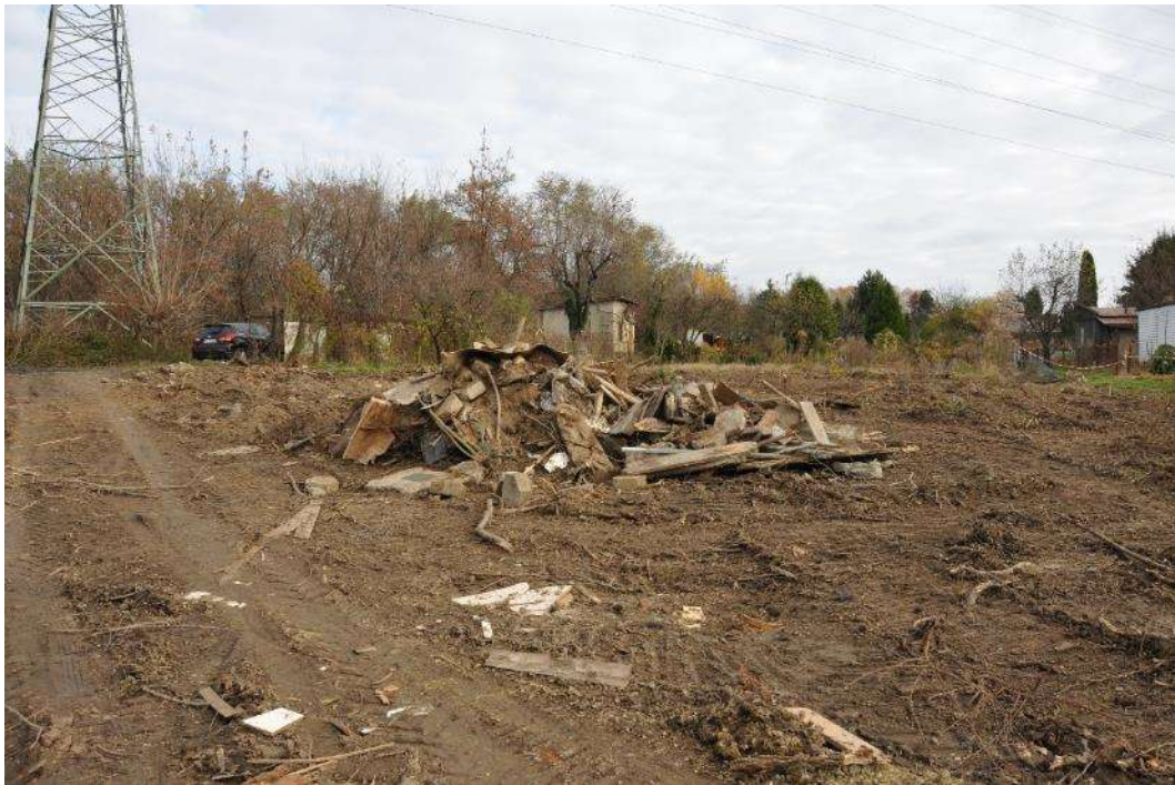
Foto. 13. Strefa prac wyburzeniowych obiektów budowlanych na terenie ogródków działkowych, 2. dekada listopada 2020 r.
