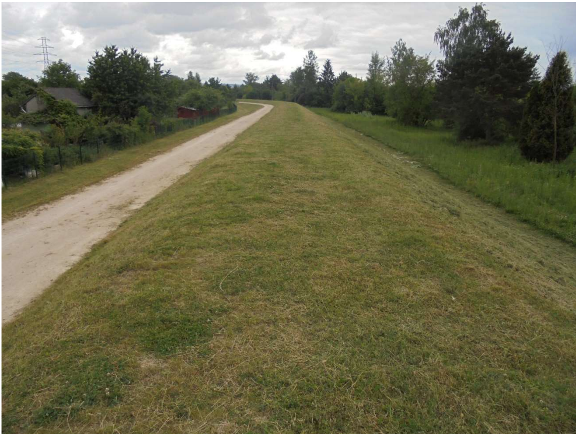
Foto. 24. Nowy wał rz. Białej po zakończeniu budowy.
