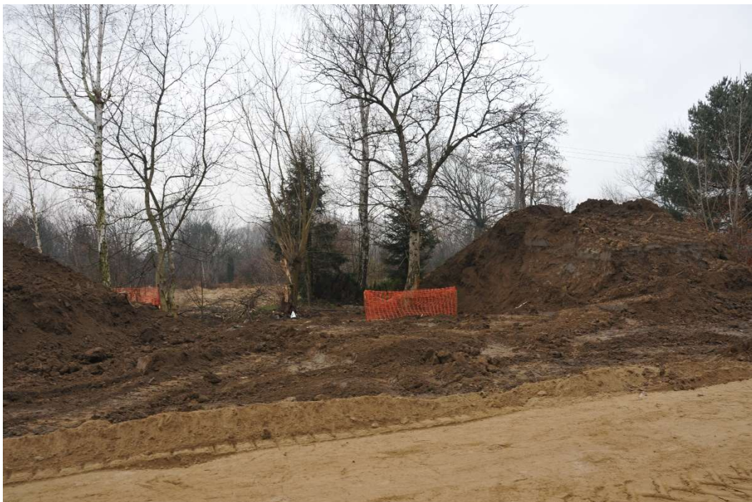
Foto. 14. Budowa wału, 2. dekada grudnia 2020 r.
