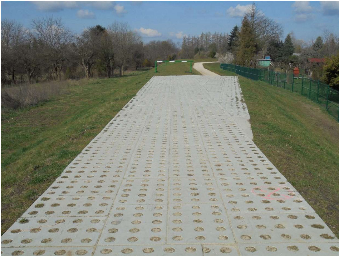
Foto. 22. Nowy wał rz. Białej po zakończeniu budowy. Widoczne ogrodzenie ROD SEMAFOR wykonane w ramach Kontraktu.
