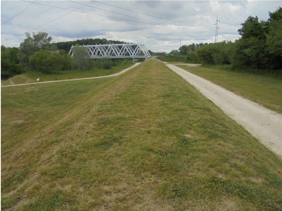
Foto. 23. Nowy wał rz. Białej po zakończeniu budowy.
