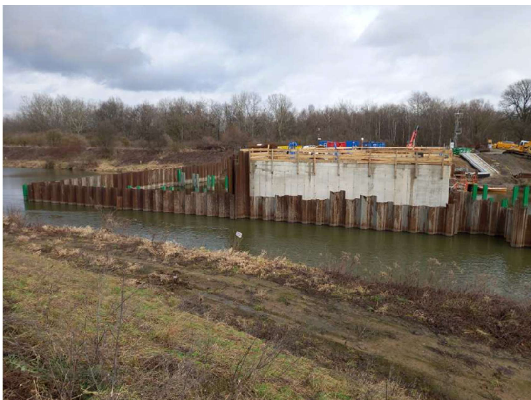
Foto. 22. Teren budowy bramy przeciwpowodziowej na kanale portu Kujawy, – część północna i środkowa, stan w trzeciej dekadzie stycznia 2023 r. (widok z zachodniego brzegu, w górę kanału).
