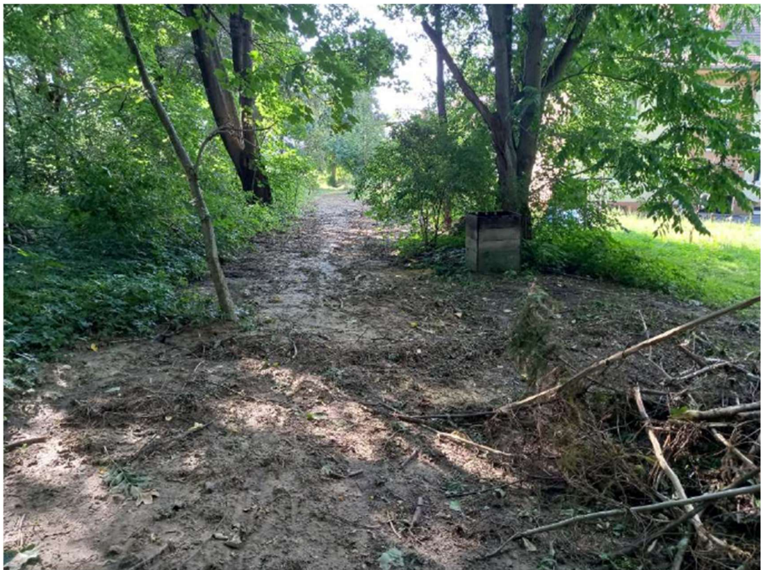
Foto. 16. Teren budowy sieci teletechnicznej na odcinku wzdłuż kanału śluzowego stopnia wodnego Przewóz, stan w trzeciej dekadzie lipca 2022 r. (widok w kierunku zachodnim).
