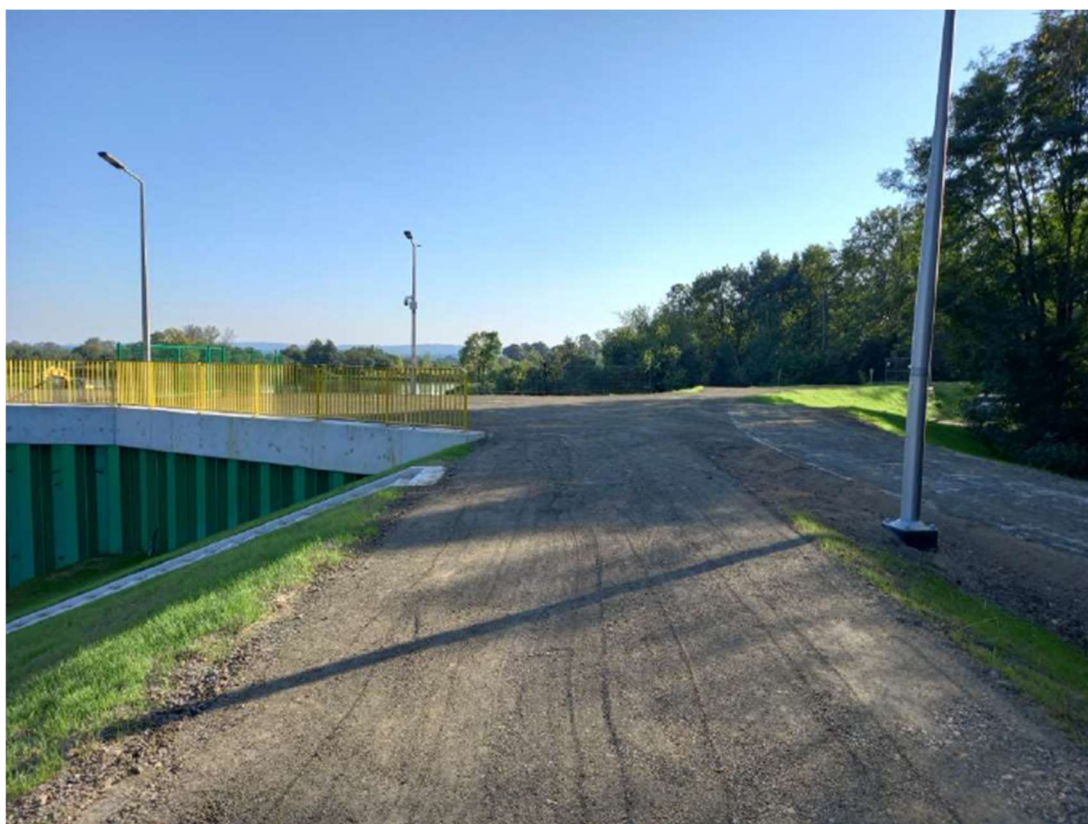
Foto. 32. Przebudowany wał przeciwpowodziowy na zachodnim brzegu kanału portu Kujawy, stan w trzeciej dekadzie września 2023 r. (widok w kierunku południowym).
