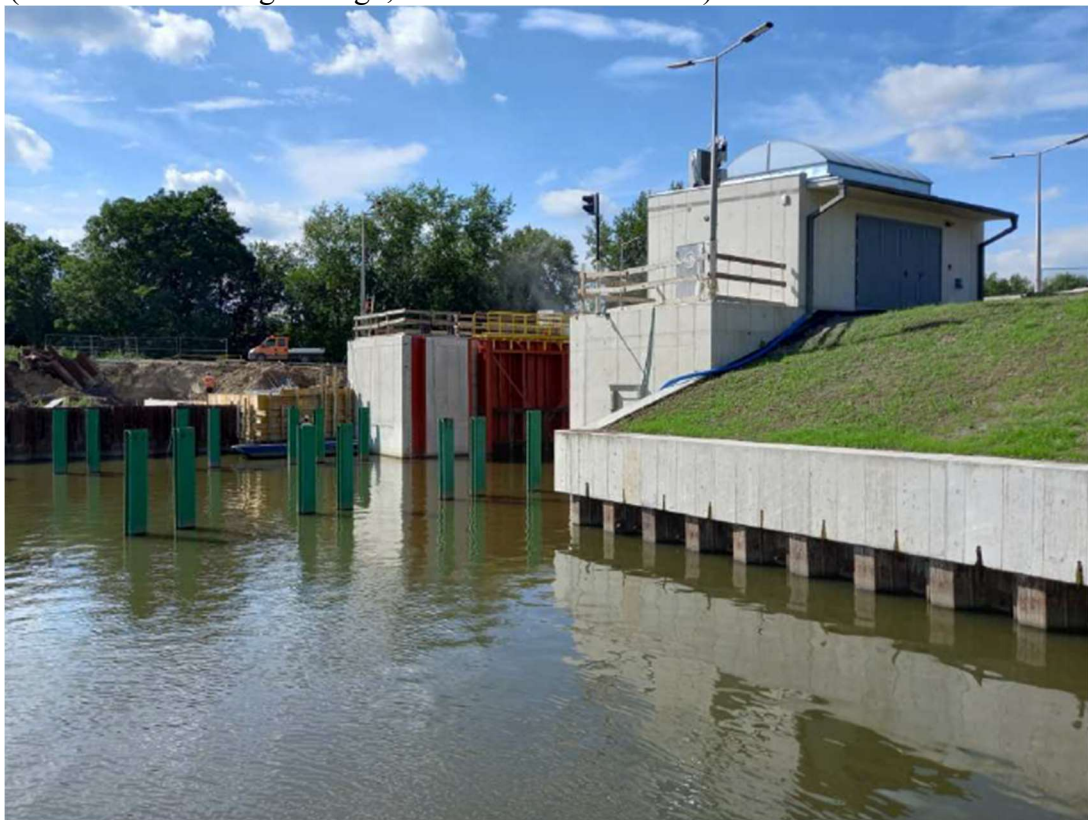
Foto. 26. Teren budowy bramy przeciwpowodziowej na kanale portu Kujawy – część południowa, stan w trzeciej dekadzie lipca 2023 r. (widok ze wschodniego brzegu, w kierunku zachodnim).
