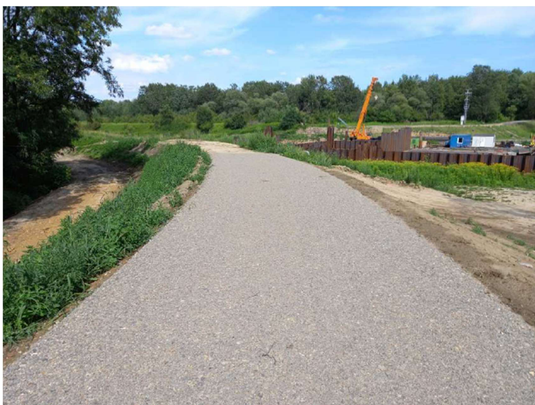
Foto. 14. Przebudowywany wał przeciwpowodziowy na zachodnim brzegu kanału portu Kujawy, stan w trzeciej dekadzie lipca 2022 r. (widok w górę kanału).
