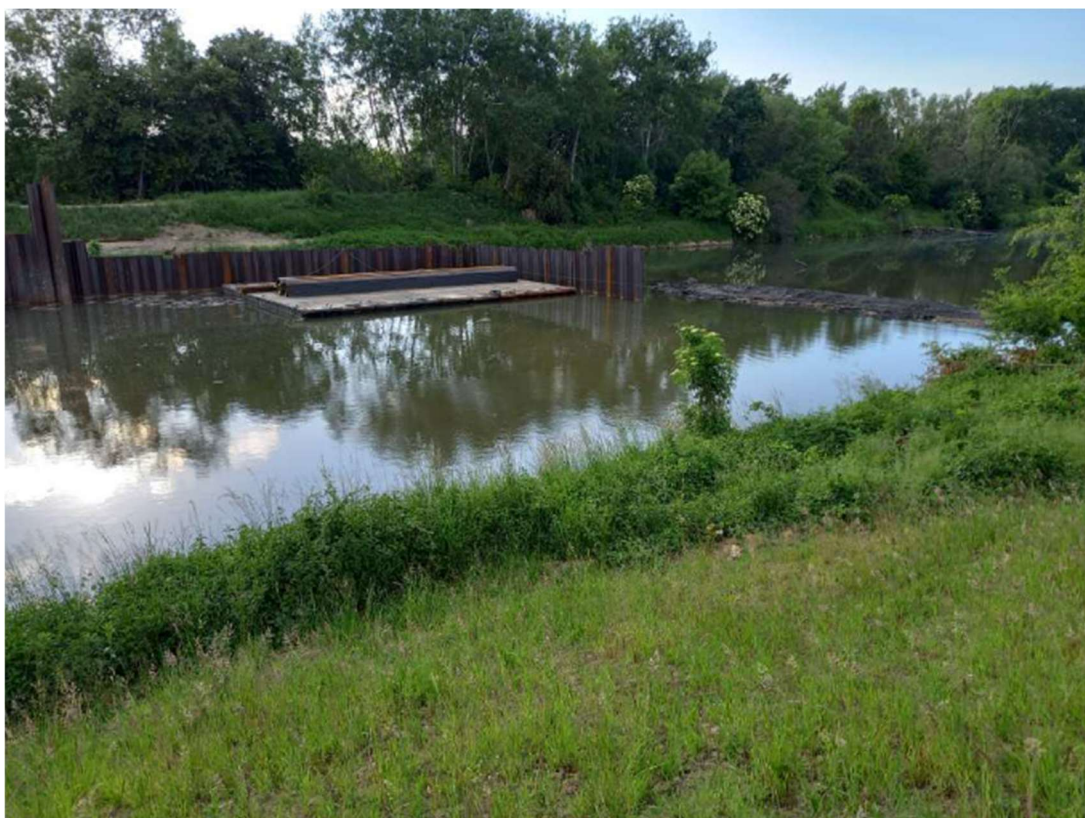
Foto. 13. Teren budowy bramy przeciwpowodziowej na kanale portu Kujawy, stan w trzeciej dekadzie maja 2022 r. (widok ze wschodniego brzegu, w górę kanału).
