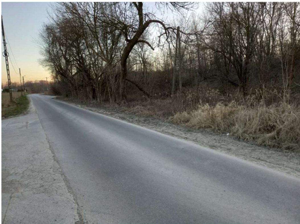
Foto. 7. Stan terenu przed rozpoczęciem budowy - budowa sieci elektroenergetycznej wzdłuż ulicy Dymarek, stan w trzeciej dekadzie marca 2022 r. (widok w kierunku południowym).
