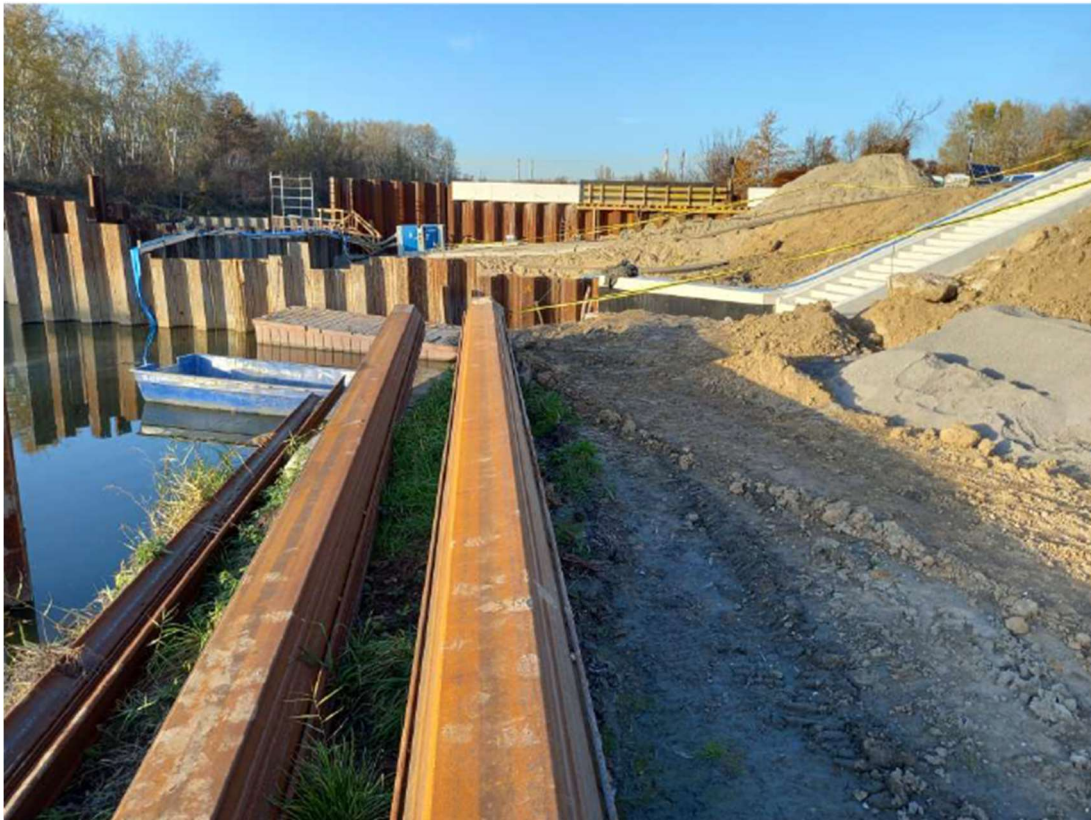
Foto. 19. Międzywale na wschodnim brzegu kanału portu Kujawy na wysokości terenu budowy bramy przeciwpowodziowej, stan w trzeciej dekadzie października 2022 r. (widok w górę kanału).
