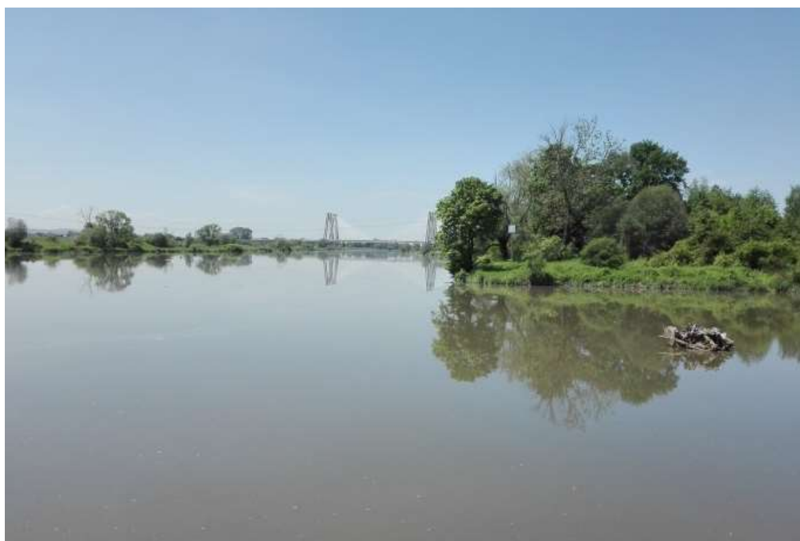
Foto. 2. Stan terenu przed rozpoczęciem budowy – widok na ujście kanału portowego do rzeki Wisły.
