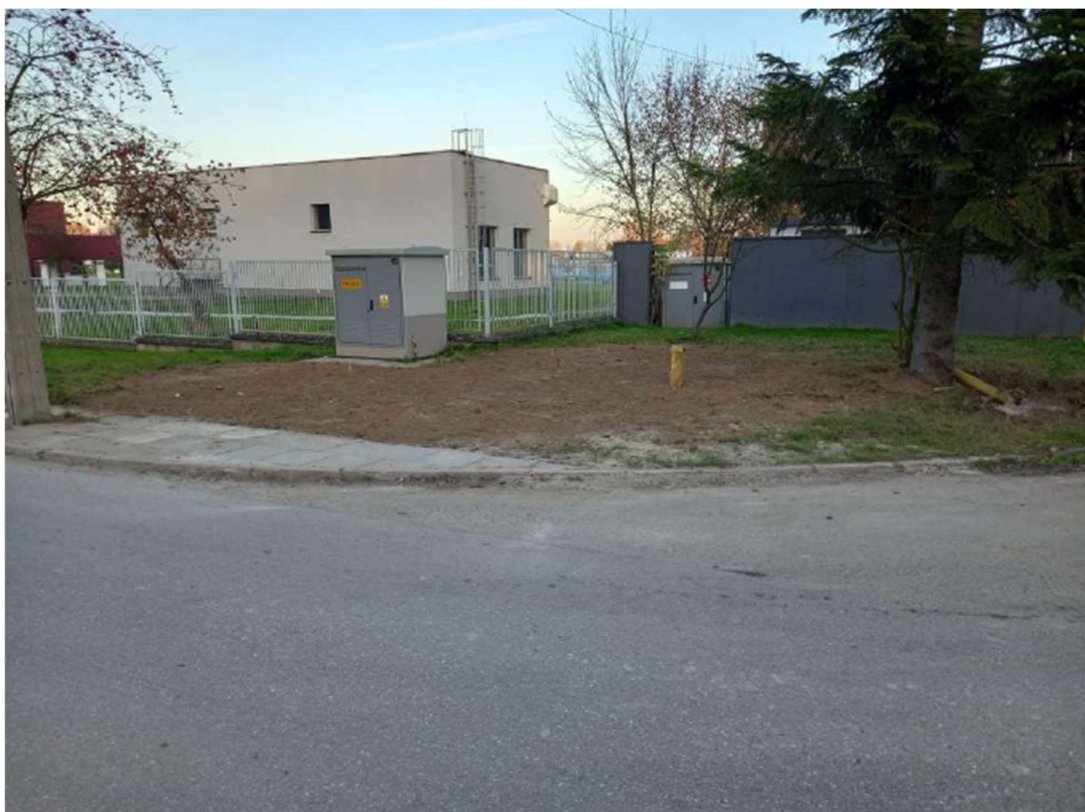
Foto. 21. Teren budowy sieci elektroenergetycznej na odcinku wzdłuż ulicy Dymarek, stan w trzeciej dekadzie października 2022 r. (widok w kierunku północno-wschodnim).
