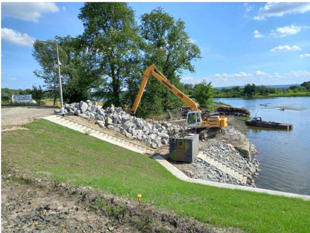
Foto. 28. Teren budowy na wschodnim międzywałie kanału portu Kujawy, – część południowa, stan w trzeciej dekadzie lipca 2023 r. (widok w kierunku południowym).
