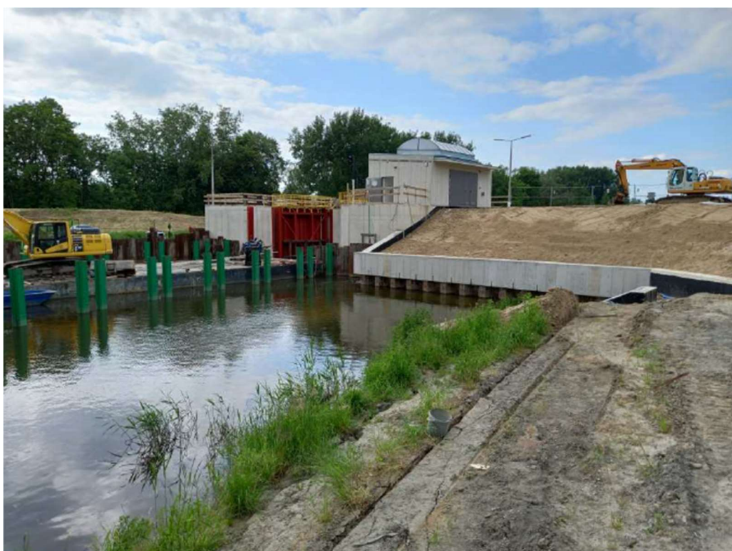
Foto. 24. Teren budowy bramy przeciwpowodziowej na kanale portu Kujawy – część południowa i środkowa, stan w trzeciej dekadzie maja 2023 r. (widok ze wschodniego brzegu, w kierunku północno-zachodnim).
