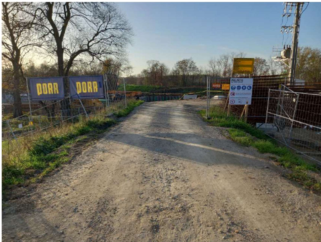
Foto. 20. Oznakowanie wjazdu na teren budowy, stan w trzeciej dekadzie października 2022 r. (widok w kierunku zachodnim).
