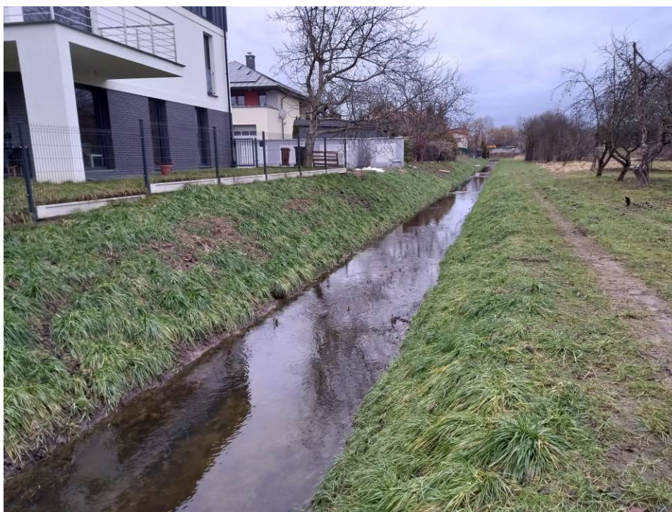
Foto. 48. Stan terenu budowy w ostatnim miesiącu okresu realizacji robót – przebudowywany odcinek Rowu 2a – część górna, stan w trzeciej dekadzie stycznia 2023 r. (widok w kierunku północnym).
