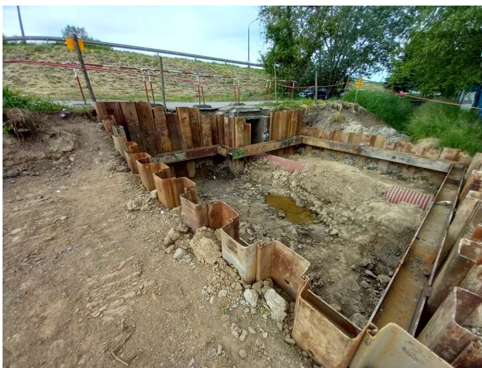
Foto. 24. Zabezpieczenie miejsc niebezpiecznych na terenie budowy śluzy wałowej na Rowie 2a na zawalu Wisły, stan w trzeciej dekadzie lipca 2022 r. (widok w kierunku północnym).
