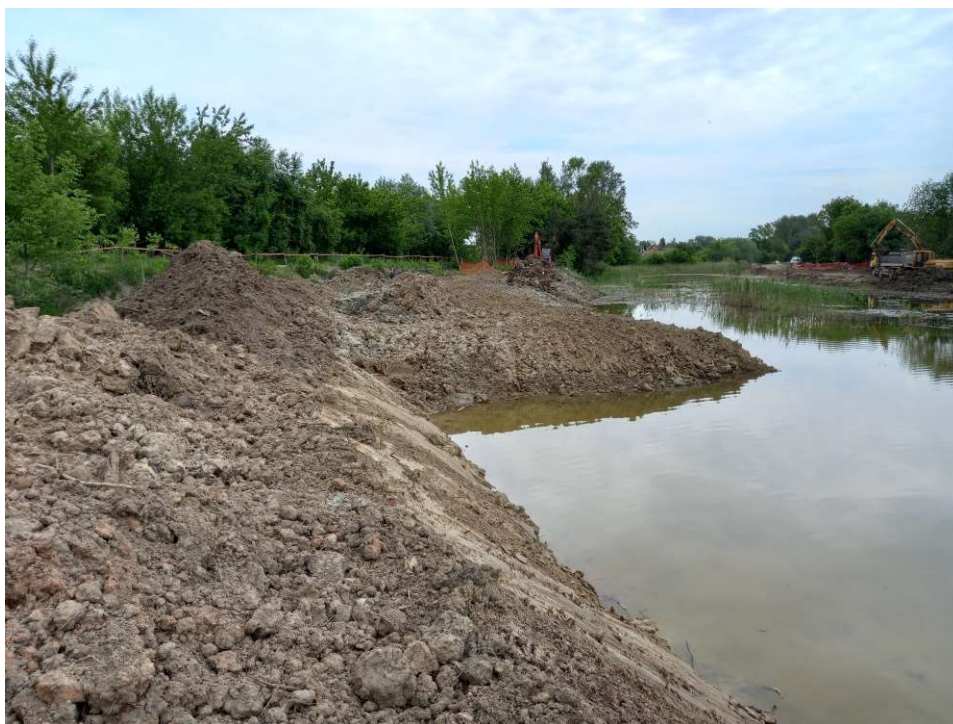
Foto. 39. Roboty ziemne na północnym brzegu powiększanego zbiornika na Rowie 2, stan w trzeciej dekadzie maja 2022 r. (widok w kierunku wschodnim).
