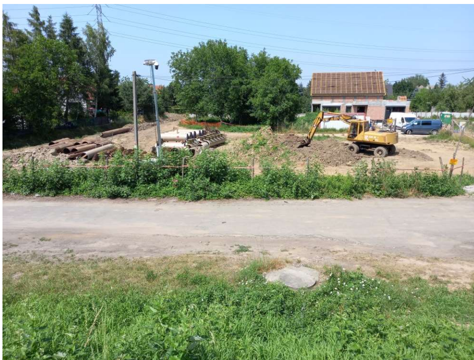
Foto. 21. Wygrodzenie teren budowy wzdłuż ul. Zagłoby, stan w trzeciej dekadzie czerwca 2022 r. (widok w kierunku północnym).
