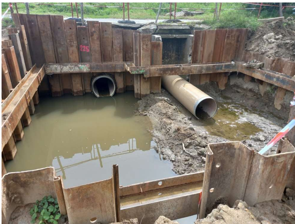
Foto. 27. Przebudowywany rurociąg grawitacyjny (po prawej) i nowy rurociąg ciśnieniowy (po lewej) na terenie budowy śluzy wałowej na Rowie 2a, stan w trzeciej dekadzie lipca 2022 r. (widok w kierunku południowym).
