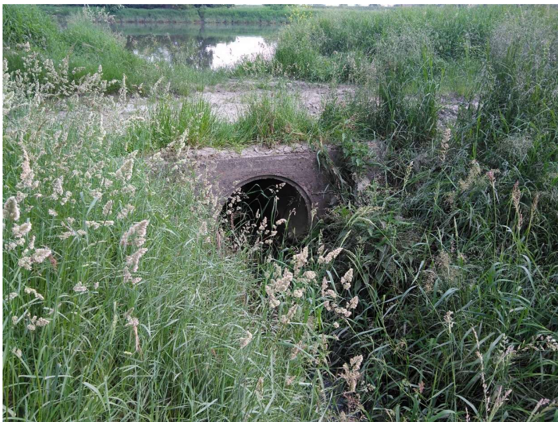
Foto. 1. Stan terenu przed rozpoczęciem budowy – przepust wałowy, którym kanał Lesisko odprowadza wody do rz. Wisły.
