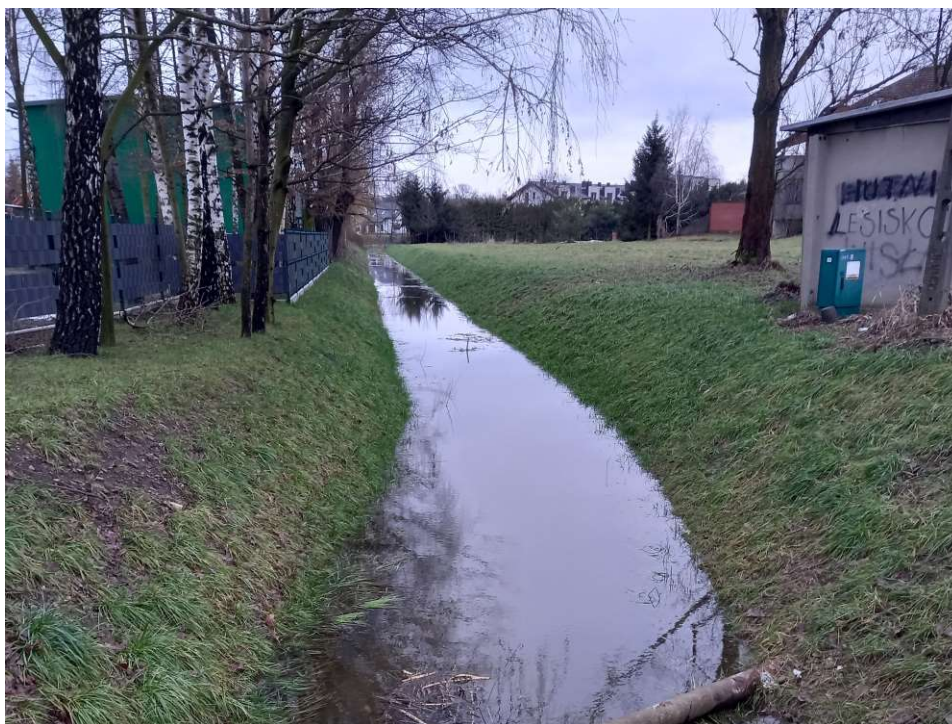
Foto. 49. Stan terenu budowy w ostatnim miesiącu okresu realizacji robót – przebudowywany odcinek Rowu 2 – część dolna, stan w trzeciej dekadzie stycznia 2023 r. (widok w kierunku wschodnim).
