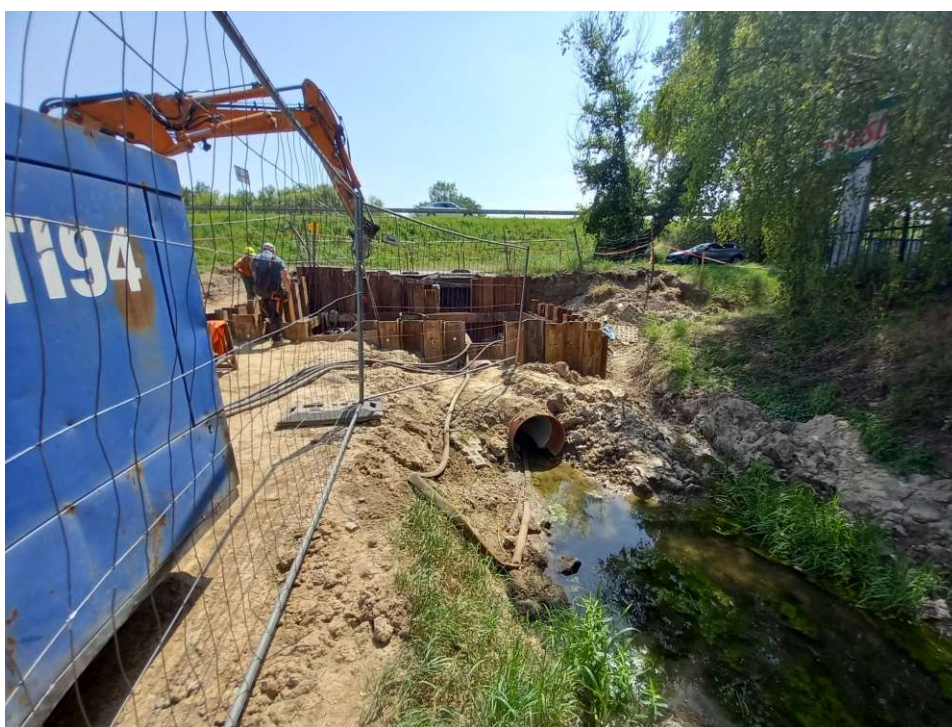
Foto. 28. Zapewnienie drożności Rowu 2a w okresie robót na śluzie wałowej, stan w trzeciej dekadzie czerwca 2022 r. (widok w kierunku południowym).
