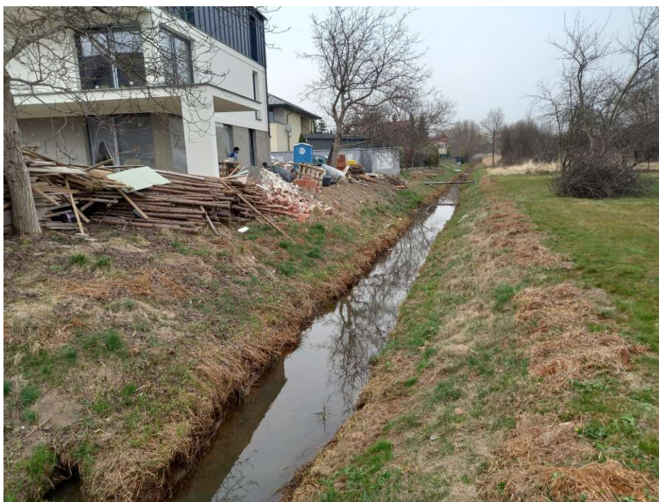
Foto. 14. Stan terenu budowy w pierwszym miesiącu okresu realizacji robót – przebudowywany odcinek Rowu 2a – część górna, stan w trzeciej dekadzie marca 2022 r. (widok w kierunku północnym).
