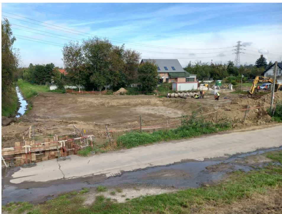
Foto. 30. Formowanie skarp zbiornika retencyjnego na Rowie 2a, stan w trzeciej dekadzie września 2022 r. (widok w kierunku północnym).
