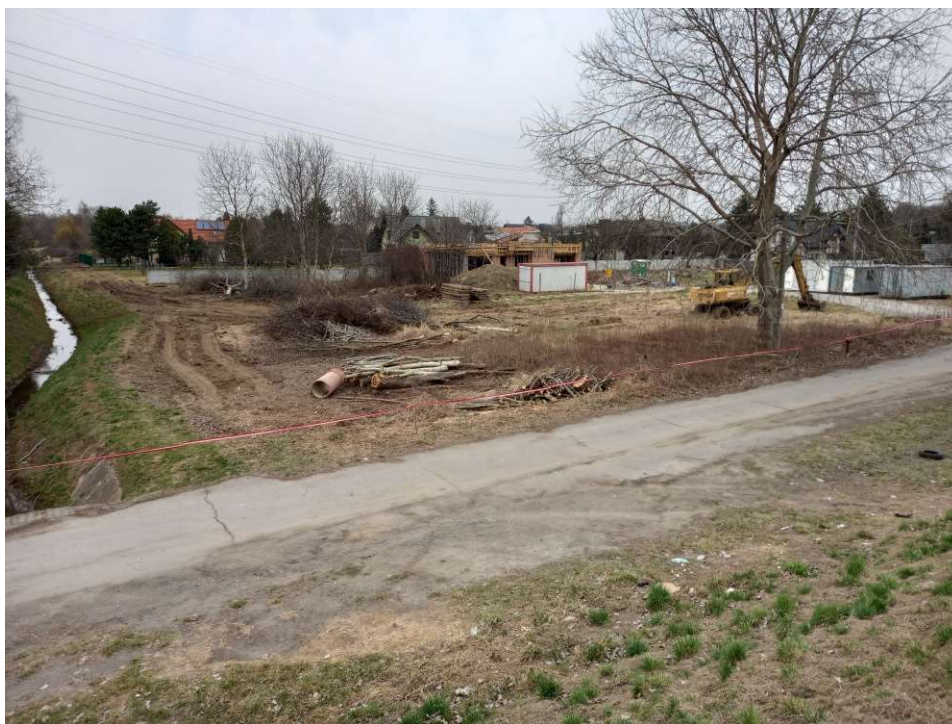
Foto. 11. Stan terenu budowy w pierwszym miesiącu okresu realizacji robót – teren budowy stanowiska pompowego dla pomp mobilnych oraz zbiornika retencyjnego powyżej śluzy wałowej, stan w trzeciej dekadzie marca 2022 r. (widok w kierunku północnym).
