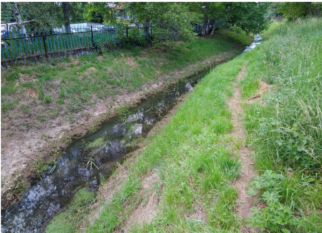
Foto. 3. Stan terenu przed rozpoczęciem budowy – koryto kanału Lesisko.
