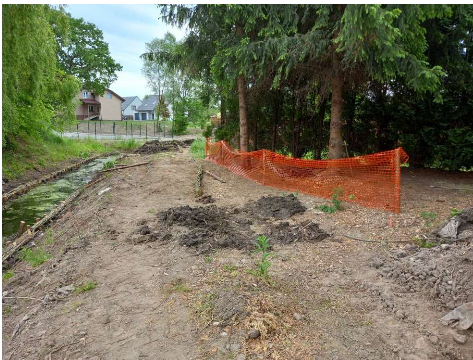
Foto. 25. Zabezpieczenie drzew nie planowanych do wycinki w sąsiedztwie terenu budowy na Rowie 2, stan w trzeciej dekadzie maja 2022 r. (widok w kierunku wschodnim).
