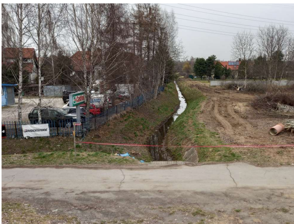
Foto. 10. Stan terenu budowy w pierwszym miesiącu okresu realizacji robót – teren budowy śluzy wałowej na Rowie 2a od strony zawala Wisły, stan w trzeciej dekadzie marca 2022 r. (widok w kierunku północnym).
