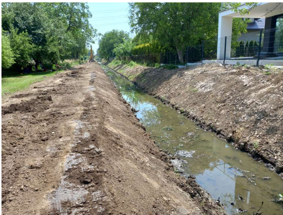
Foto. 35. Formowanie skarp brzegowych na Rowie 2a, stan w trzeciej dekadzie czerwca 2022 r. (widok w kierunku południowym).
