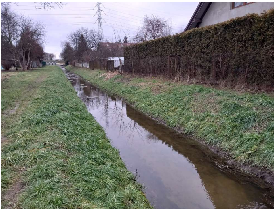
Foto. 47. Stan terenu budowy w ostatnim miesiącu okresu realizacji robót – przebudowywany odcinek Rowu 2a – część dolna, stan w trzeciej dekadzie stycznia 2023 r. (widok w kierunku południowym).
