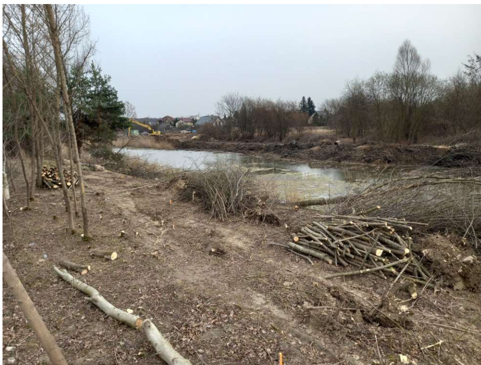
Foto. 17. Stan terenu budowy w pierwszym miesiącu okresu realizacji robót – przebudowywany zbiornik na Rowie 2, część wschodnia, stan w trzeciej dekadzie marca 2022 r. (widok w kierunku wschodnim).
