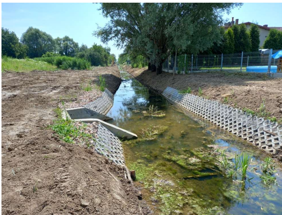
Foto. 36. Ubezpieczenie skarp brzegowych na Rowie 2a, stan w trzeciej dekadzie września 2022 r. (widok w kierunku południowym).
