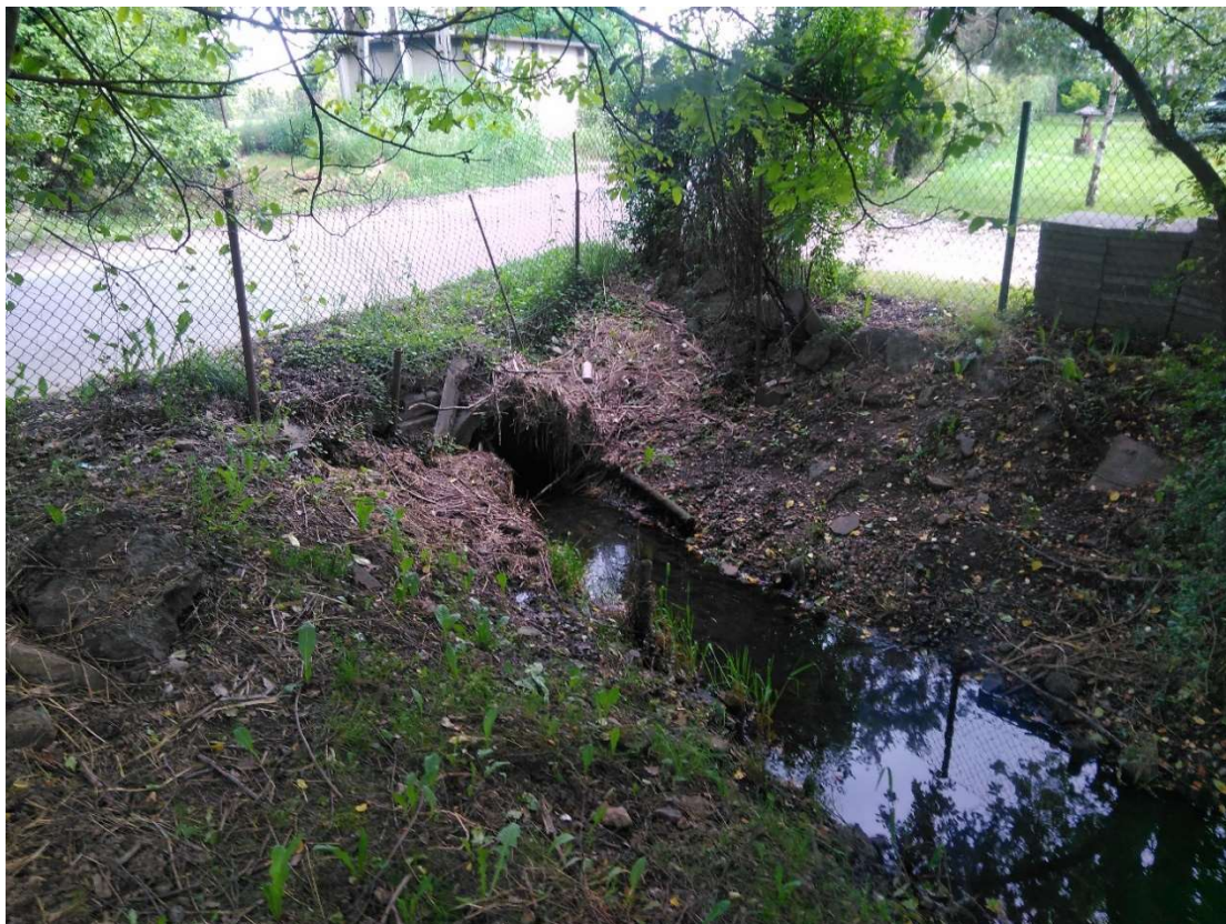
Foto. 7. Stan terenu przed rozpoczęciem budowy – koryto kanału Lesisko.
