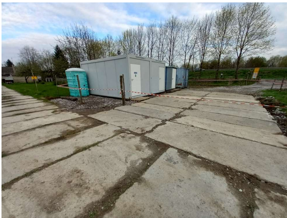
Foto. 19. Zaplecze budowy na lewobrzeżnym zawalu Wisły, stan w trzeciej dekadzie kwietnia 2022 r. (widok w kierunku południowym).
