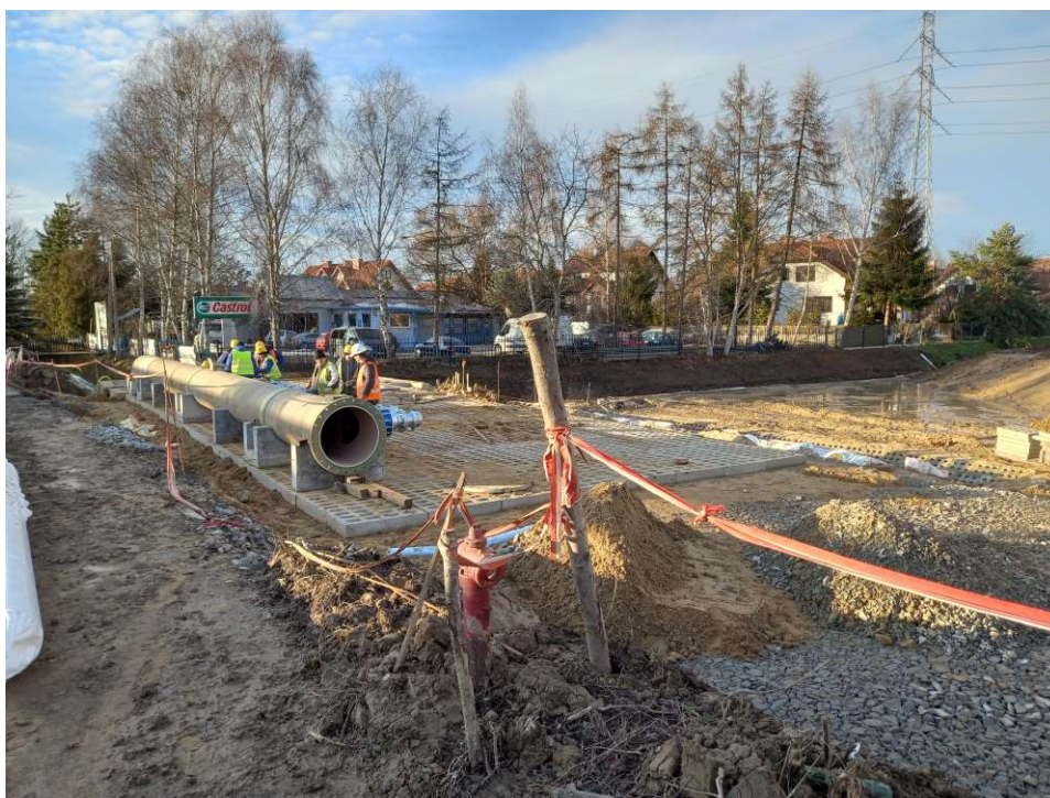
Foto. 32. Budowa stanowiska pomp mobilnych na Rowie 2a, stan w trzeciej dekadzie grudnia 2022 r. (widok w kierunku zachodnim).
