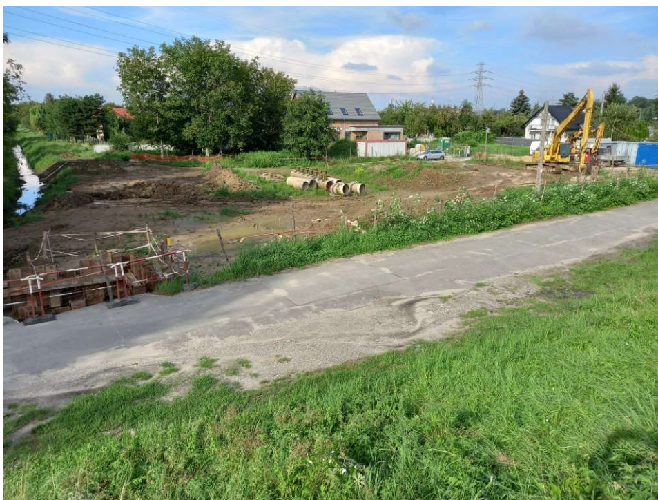
Foto. 29. Roboty ziemne przy budowie zbiornika retencyjnego na Rowie 2a, stan w trzeciej dekadzie sierpnia 2022 r. (widok w kierunku północnym).
