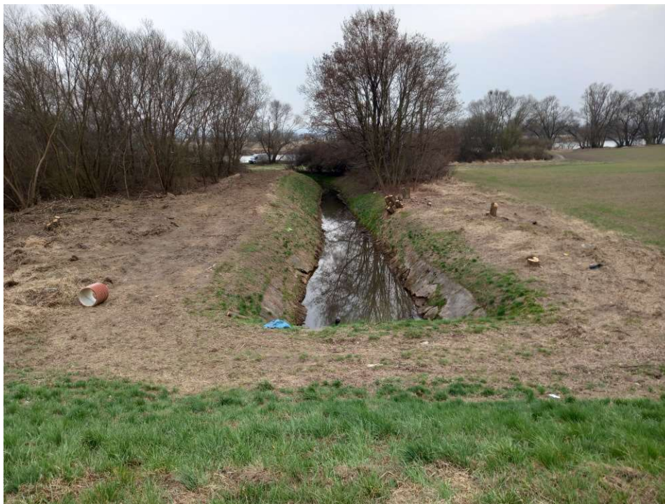
Foto. 9. Stan terenu budowy w pierwszym miesiącu okresu realizacji robót – teren budowy śluzy wałowej na Rowie 2a od strony międzywała Wisły, stan w trzeciej dekadzie marca 2022 r. (widok w kierunku południowym).
