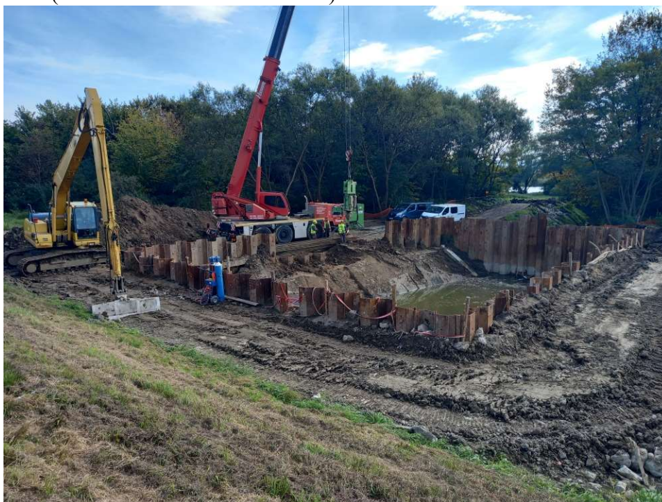
Foto. 26. Roboty larsenowe na dolnym stanowisku śluzy wałowej na Rowie 2a, stan w trzeciej dekadzie września 2022 r. (widok w kierunku południowym).
