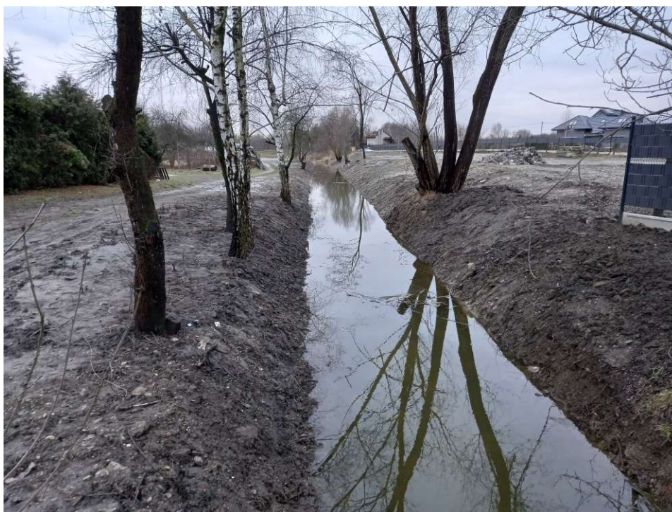
Foto. 50. Stan terenu budowy w ostatnim miesiącu okresu realizacji robót – przebudowywany odcinek Rowu 2 – część górna, stan w trzeciej dekadzie stycznia 2023 r. (widok w kierunku zachodnim).
