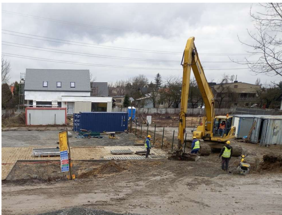
Foto. 34. Rekultywacja terenu w otoczeniu placu manewrowego i stanowiska pomp mobilnych na Rowie 2a, stan w trzeciej dekadzie stycznia 2023 r. (widok w kierunku północnym).
