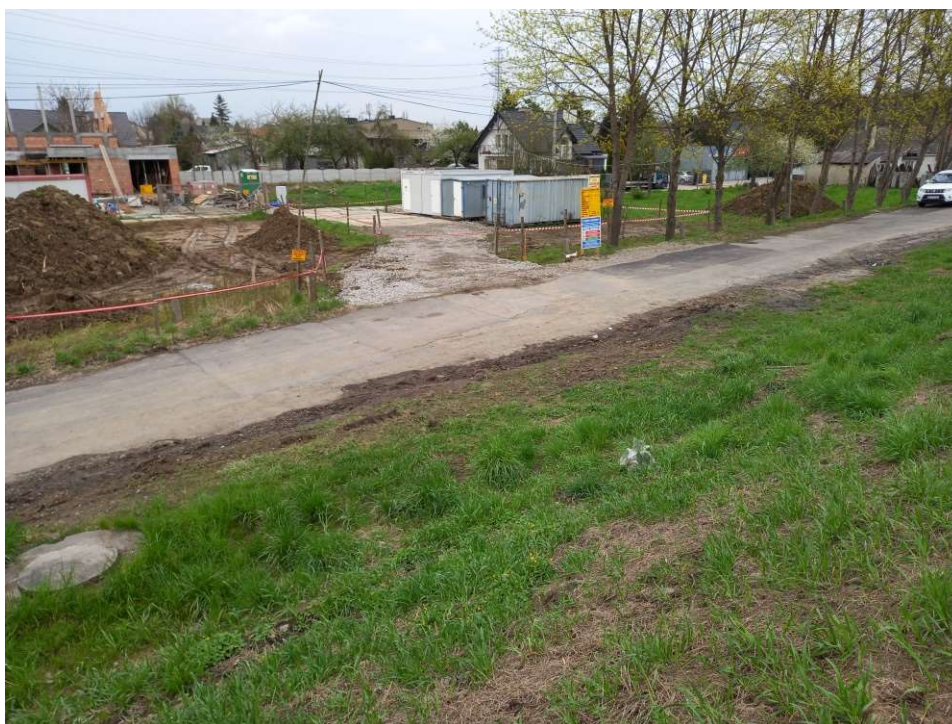
Foto. 20. Oznakowanie wjazdu na teren budowy od strony ul. Zagłoby, stan w trzeciej dekadzie kwietnia 2022 r. (widok w kierunku północno-wschodnim).
