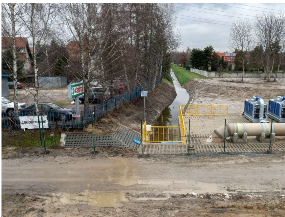
Foto. 44. Stan terenu budowy w ostatnim miesiącu okresu realizacji robót – teren budowy śluzy wałowej na Rowie 2a od strony zawala Wisły, stan w trzeciej dekadzie stycznia 2023 r. (widok w kierunku północnym).
