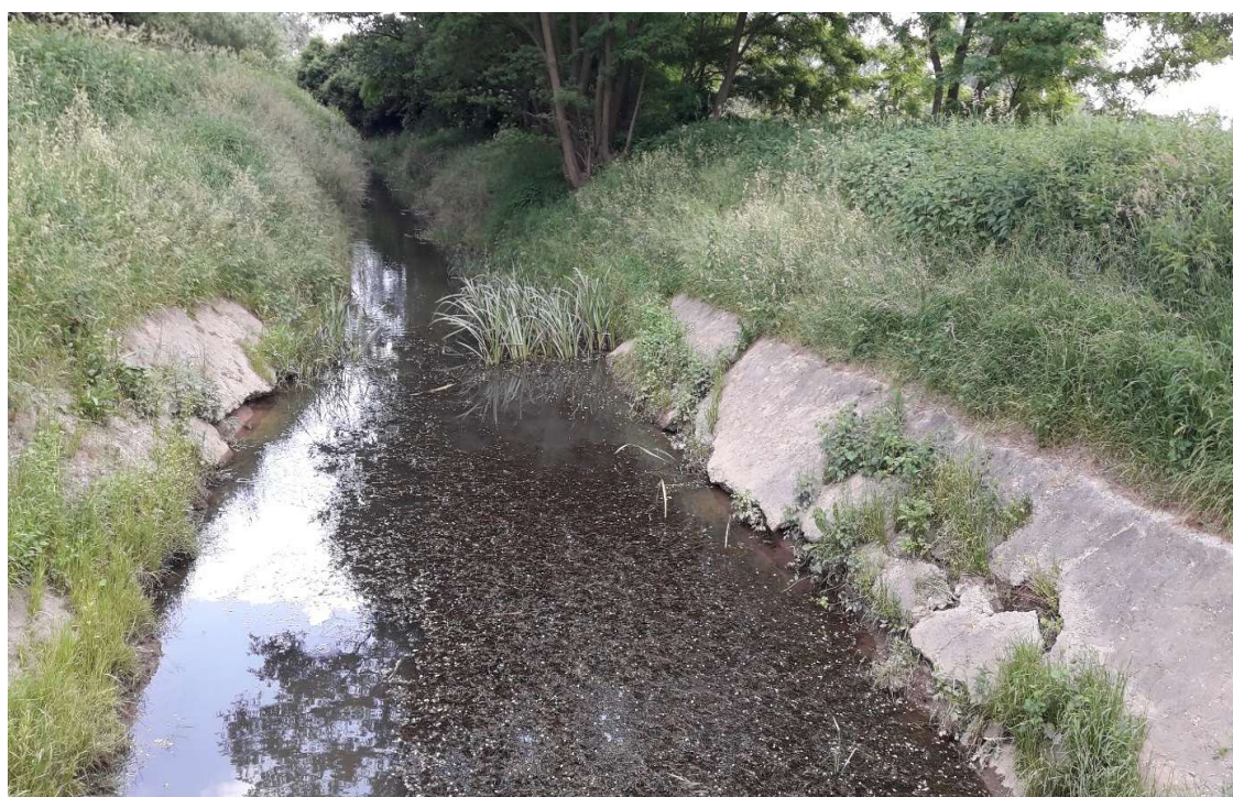
Foto. 2. Stan terenu przed rozpoczęciem budowy – koryto kanału Lesisko.
