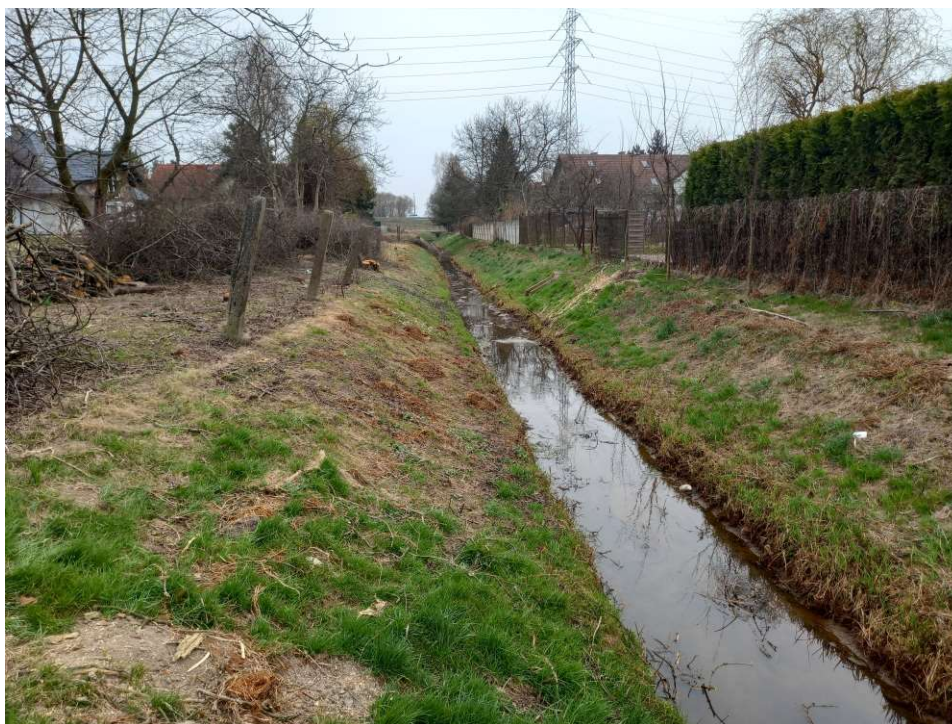
Foto. 13. Stan terenu budowy w pierwszym miesiącu okresu realizacji robót – przebudowywany odcinek Rowu 2a – część dolna, stan w trzeciej dekadzie marca 2022 r. (widok w kierunku południowym).
