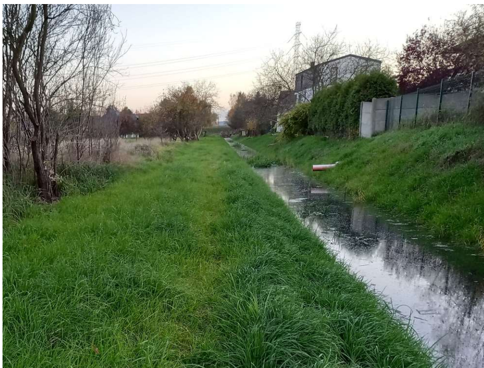
Foto. 37. Porost traw na skarpach brzegowych na Rowie 2a po zakończeniu robót na tym odcinku, (widok w kierunku południowym).
