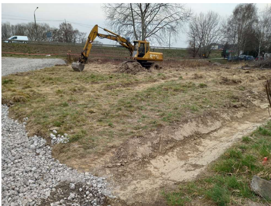
Foto. 12. Stan terenu budowy w pierwszym miesiącu okresu realizacji robót – teren budowy zbiornika retencyjnego powyżej śluzy wałowej oraz stanowiska pompowego dla pomp mobilnych, stan w trzeciej dekadzie marca 2022 r. (widok w kierunku południowym).
