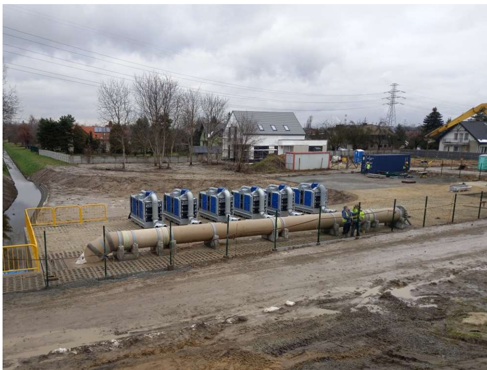
Foto. 45. Stan terenu budowy w ostatnim miesiącu okresu realizacji robót – teren budowy stanowiska pompowego dla pomp mobilnych oraz zbiornika retencyjnego powyżej śluzy wałowej, stan w trzeciej dekadzie stycznia 2023 r. (widok w kierunku północnym).
