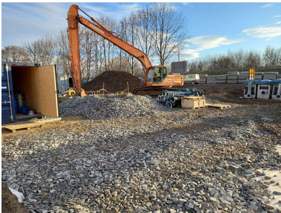
Foto. 33. Budowa placu manewrowego przy stanowisku pomp mobilnych na Rowie 2a, stan w trzeciej dekadzie grudnia 2022 r. (widok w kierunku południowo-wschodnim).
