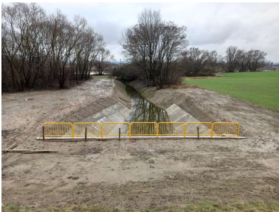
Foto. 43. Stan terenu budowy w ostatnim miesiącu okresu realizacji robót – teren budowy śluzy wałowej na Rowie 2a od strony międzywala Wisły, stan w trzeciej dekadzie stycznia 2023 r. (widok w kierunku południowym).
