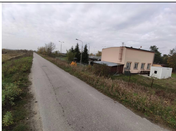
Zdjęcie nr 5: Wjazd na wał przy oczyszczalni (nawierzchnia asfaltowa).
