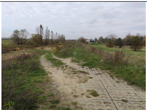
Zdjęcie nr 4: Wzmocnienie przejścia w poprzek przez wał.
