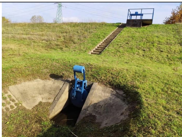
Zdjęcie nr 11: Przepust przez wał, zaszuwa.
