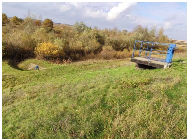
Zdjęcie nr 11: Przepust przez wał, zaszuwa.
