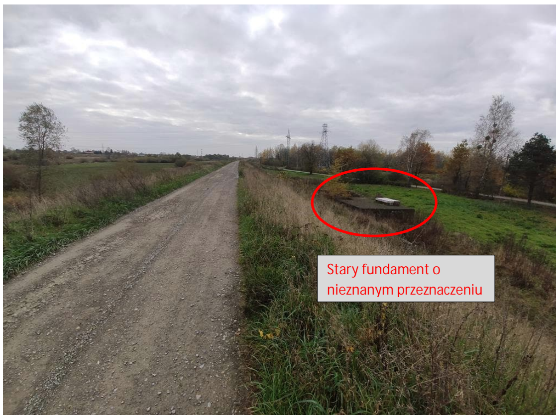
Fot. 1. Fundament, który został rozebrany (dz. 24/4 obręb 7 Zalesie Gorzyckie) (stary, niewielki fundament o niezidentyfikowanym przeznaczeniu, zlokalizowany na niezabudowanym terenie).
