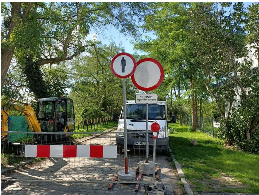
Foto. 1. Służowjskie Street , second decade of August 2022 (entering the Construction Site).
