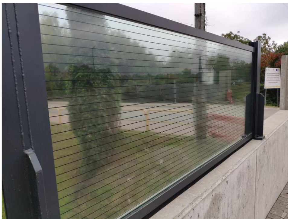
Foto. 29. Zabezpieczenia przeciwko rozbijaniu się ptaków o szyby – wał opaskowy w ciągu ul. Mostowej, stan w trzeciej dekadzie września 2022 r. (widok w kierunku SW).
