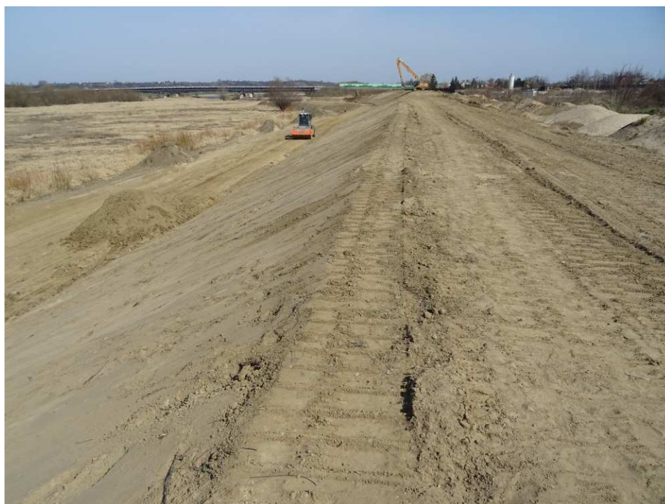
Foto. 32. Formowanie skarp wału przeciwpowodziowego – prawobrzeżny wał rzeki Wisły wzdłuż brzegu basenu portowego, stan w trzeciej dekadzie marca 2020 r. (widok w kierunku NE).
