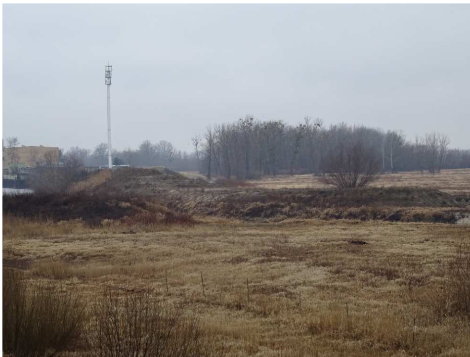
Foto. 1. Stan terenu budowy w pierwszym kwartale okresu realizacji robót na Zadaniu 3 – planowana brama przeciwpowodziowa na kanale portowym w Sandomierzu, stan w trzeciej dekadzie lutego 2020 r. (widok w kierunku W).
