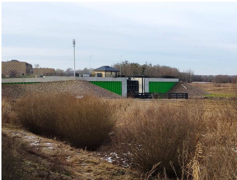
Foto. 49. Stan terenu budowy w ostatnim kwartale okresu realizacji robót na Zadaniu 3 – brama przeciwpowodziowa na kanale portowym w Sandomierzu, stan w trzeciej dekadzie grudnia 2022 r. (widok w kierunku W).
