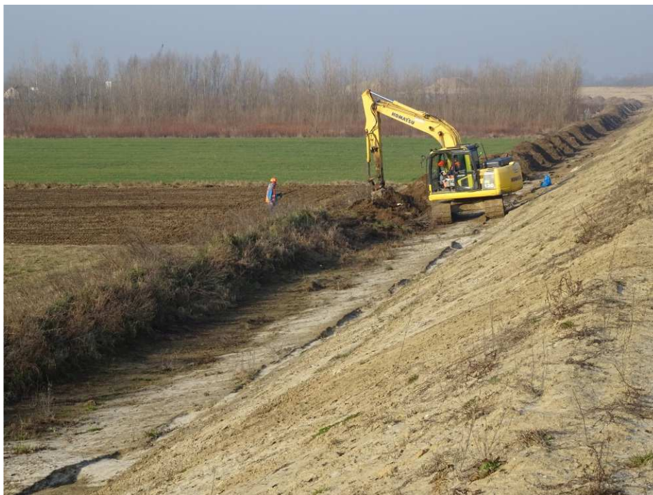
Foto. 21. Zabezpieczenie hałd humusu – wał opaskowy pomiędzy ul. Zarzekowice a prawobrzeżnym wałem Wisły, stan w drugiej dekadzie marca 2020 r. (widok w kierunku SW).
