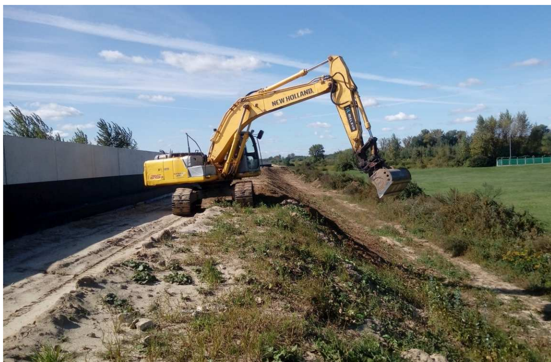
Foto. 31. Formowanie skarp wału przeciwpowodziowego – wał opaskowy pomiędzy ul. Zarzekowice a prawobrzeżnym wałem Wisły, stan w drugiej dekadzie września 2020 r. (widok w kierunku SW).
