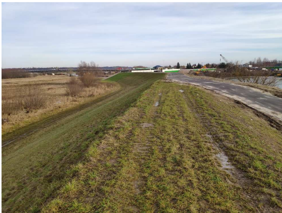
Foto. 56. Stan terenu budowy w ostatnim kwartale okresu realizacji robót na Zadaniu 3 – prawobrzeżny wał rzeki Wisły wzdłuż brzegu basenu portowego, stan w trzeciej dekadzie grudnia 2022 r. (widok w kierunku NE).
