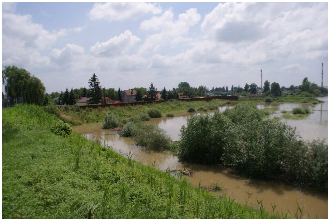
Foto. 41. Wezbranie powodziowe na terenie robót – wał opaskowy w ciągu ul. Mostowej, stan w trzeciej dekadzie czerwca 2020 r. (widok w kierunku SW).
