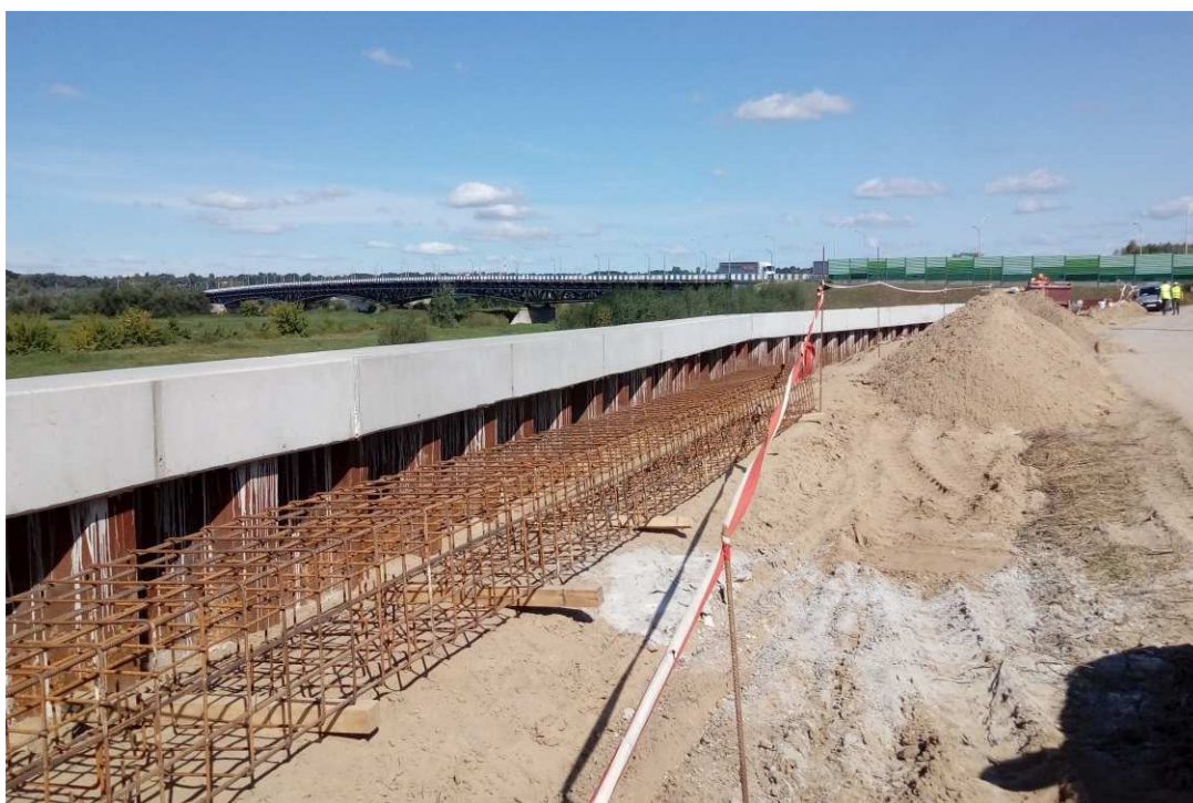
Foto. 25. Budowa muru oporowego z grodzie stalowych – wał opaskowy w ciągu ul. Mostowej, stan w drugiej dekadzie września 2020 r. (widok w kierunku NE).
