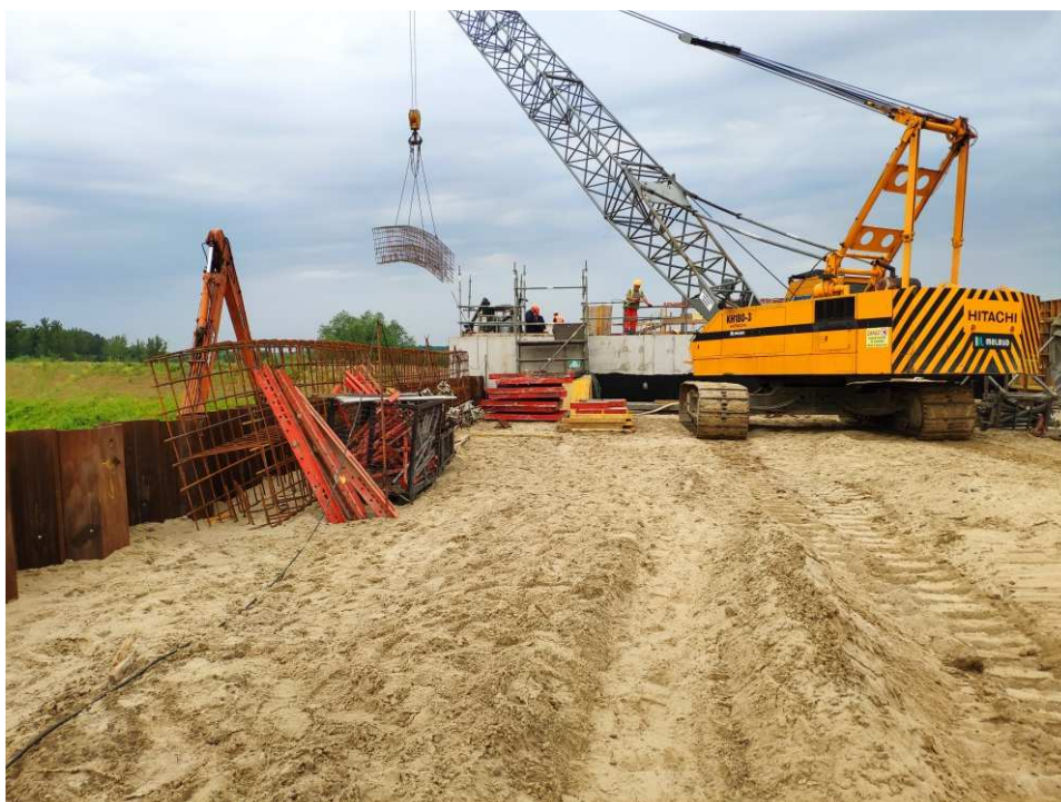
Foto. 44. Budowa bramy przeciwpowodziowej na kanale portowym w Sandomierzu, stan w pierwszej dekadzie lipca 2022 r. (widok w kierunku NW).
