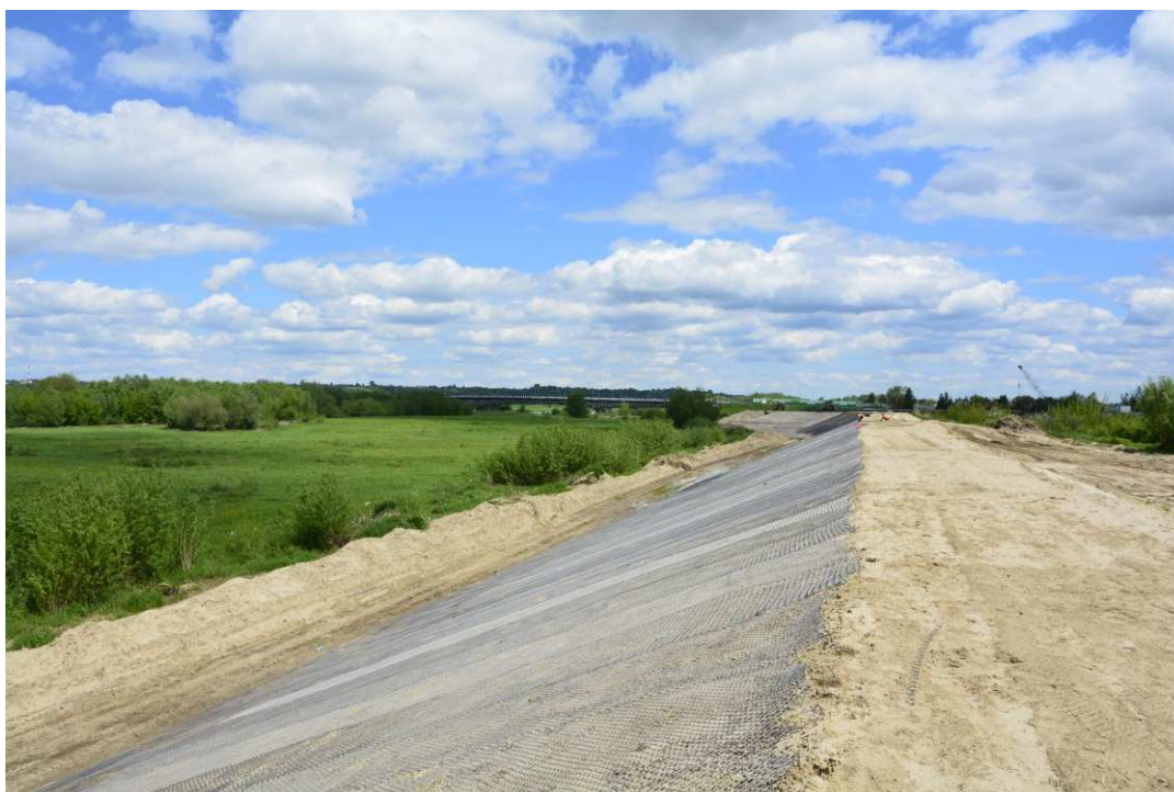
Foto. 34. Zabezpieczanie skarpy wału przeciwpowodziowego siatką przeciwko bobrom – prawobrzeżny wał rzeki Wisły wzdłuż brzegu basenu portowego, stan w drugiej dekadzie maja 2021 r. (widok w kierunku NE).
