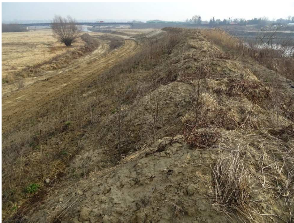
Foto. 8. Stan terenu budowy w pierwszym kwartale okresu realizacji robót na Zadaniu 3 – prawobrzeżny wał rzeki Wisły wzdłuż brzegu basenu portowego, stan w drugiej dekadzie marca 2020 r. (widok w kierunku NE).
