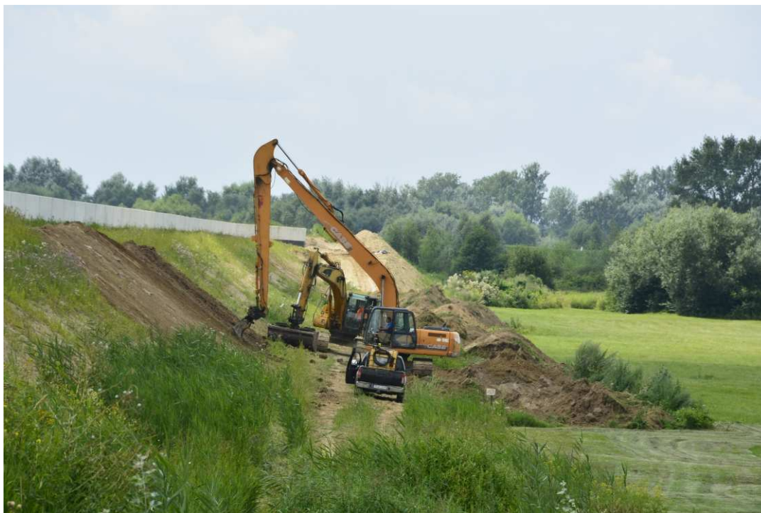
Foto. 35. Humusowanie skarp wału przeciwpowodziowego – wał opaskowy pomiędzy ul. Zarzekowice a prawobrzeżnym wałem Wisły, stan w drugiej dekadzie lipca 2021 r. (widok w kierunku SW).
