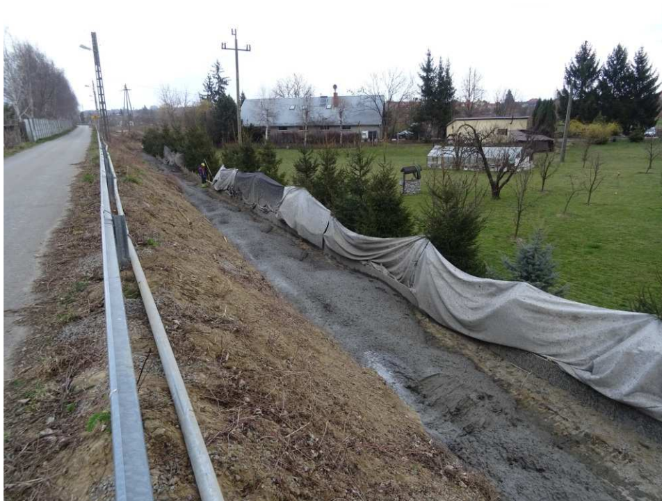
Foto. 19. Zabezpieczenie drzew i krzewów nie planowanych do wycinki – wał opaskowy w ciągu ul. Mostowej, stan w trzeciej dekadzie marca 2020 r. (widok w kierunku NE).
