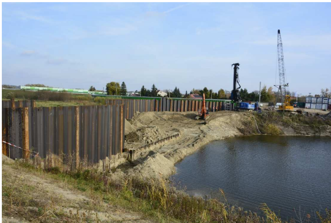
Foto. 45. Roboty w korycie kanału pod osłoną ścianek szczelnych – brama przeciwpowodziowa na kanale portowym w Sandomierzu, stan w trzeciej dekadzie października 2021 r. (widok w kierunku SE).
