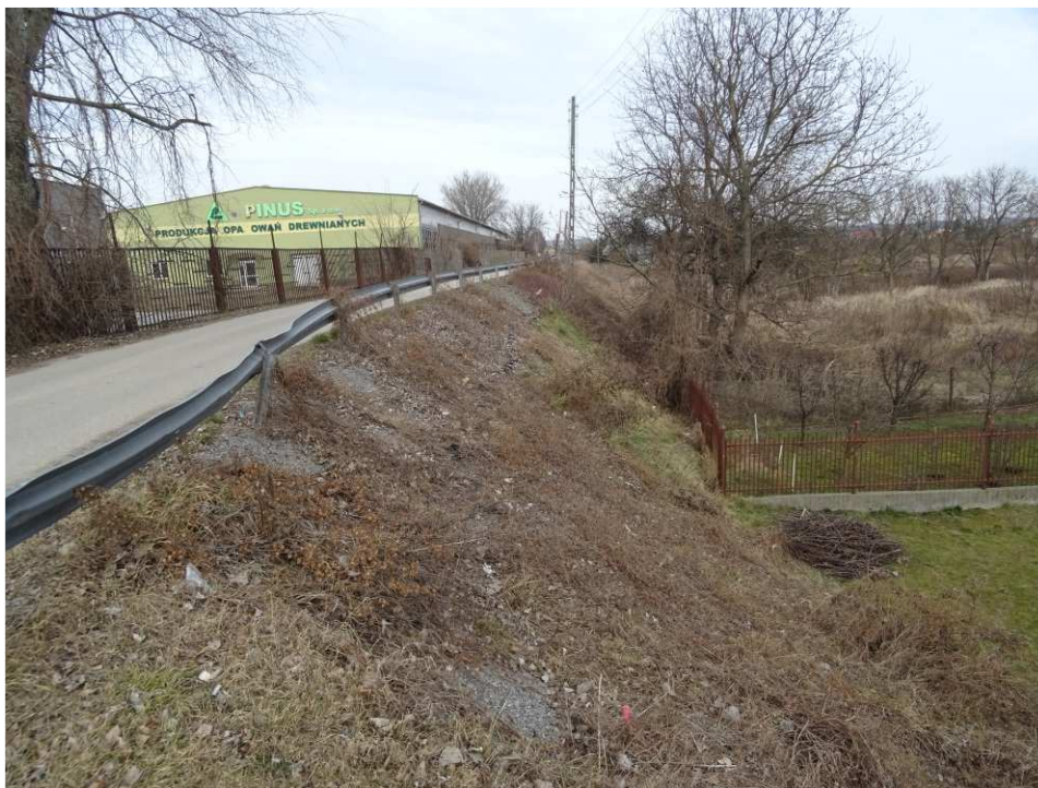
Foto. 3. Stan terenu budowy w pierwszym kwartale okresu realizacji robót na Zadaniu 3 – wał opaskowy w ciągu ul. Mostowej, stan w drugiej dekadzie lutego 2020 r. (widok w kierunku NE).
