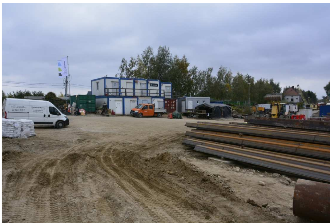
Foto. 9. Zaplecze budowy przy bramie przeciwpowodziowej, stan w trzeciej dekadzie lipca 2020 r. (widok w kierunku SE).
