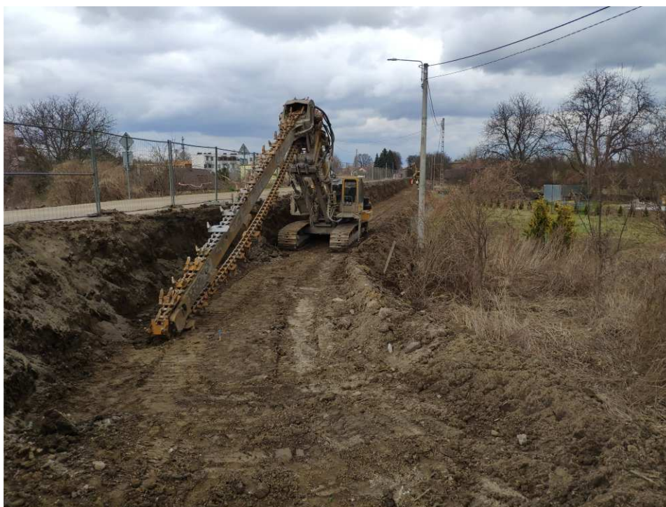
Foto. 24. Budowa przesłony cementowo-bentonitowej – wał opaskowy w ciągu ul. Zarzekowice, stan w pierwszej dekadzie kwietnia 2022 r. (widok w kierunku NE).
