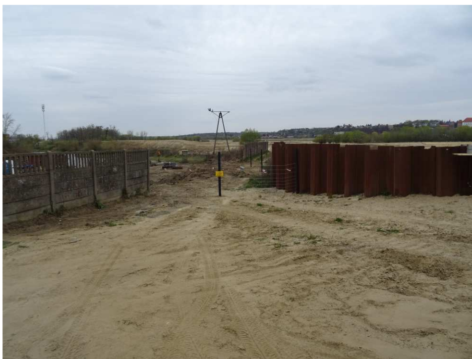
Foto. 11. Oznakowanie terenu budowy – brama przeciwpowodziowa na kanale portowym w Sandomierzu, stan w drugiej dekadzie kwietnia 2020 r. (widok w kierunku W).
