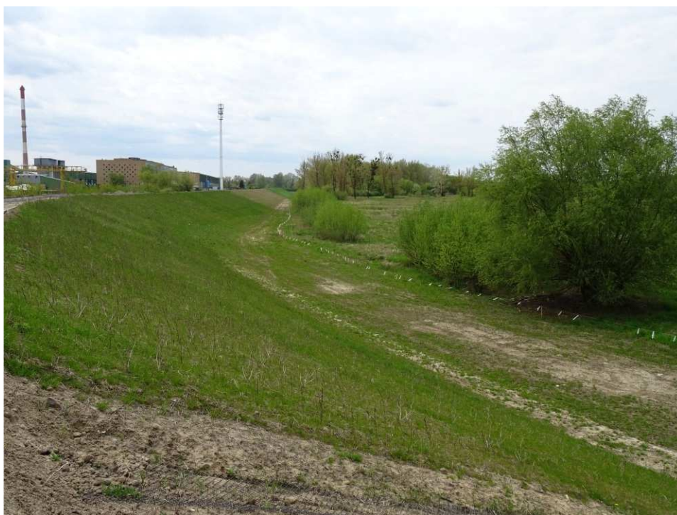
Foto. 40. Porost traw wysianych na skarpie wału przeciwpowodziowego – prawobrzeżny wał rzeki Wisły wzdłuż brzegu basenu portowego, stan w pierwszej dekadzie maja 2022 r. (widok w kierunku SW).
