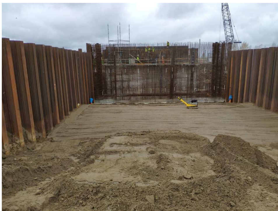
Foto. 43. Budowa bramy przeciwpowodziowej na kanale portowym w Sandomierzu, stan w trzeciej dekadzie kwietnia 2022 r. (widok w kierunku SE).
