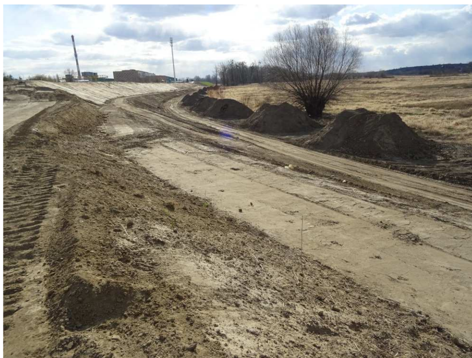
Foto. 22. Zabezpieczenie hałd humusu – prawobrzeżny wał rzeki Wisły wzdłuż brzegu basenu portowego, stan w trzeciej dekadzie marca 2020 r. (widok w kierunku SW).
