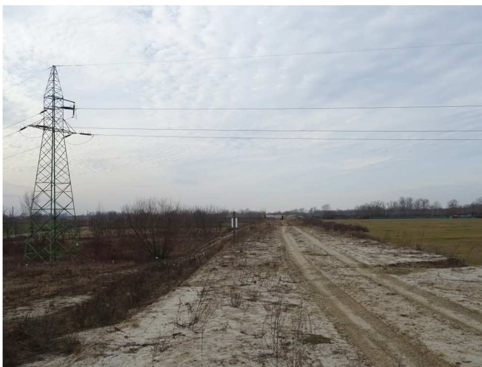
Foto. 6. Stan terenu budowy w pierwszym kwartale okresu realizacji robót na Zadaniu 3 – wał opaskowy pomiędzy ul. Zarzekowice a prawobrzeżnym wałem Wisły, stan w drugiej dekadzie lutego 2020 r. (widok w kierunku SW).
