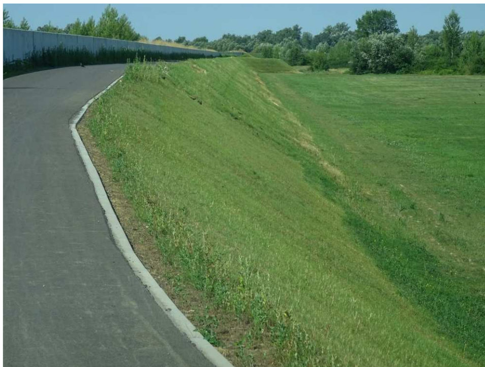
Foto. 39. Porost traw wysianych na skarpie wału przeciwpowodziowego – wał opaskowy pomiędzy ul. Zarzekowice a prawobrzeżnym wałem Wisły, stan w trzeciej dekadzie lipca 2022 r. (widok w kierunku SW).
