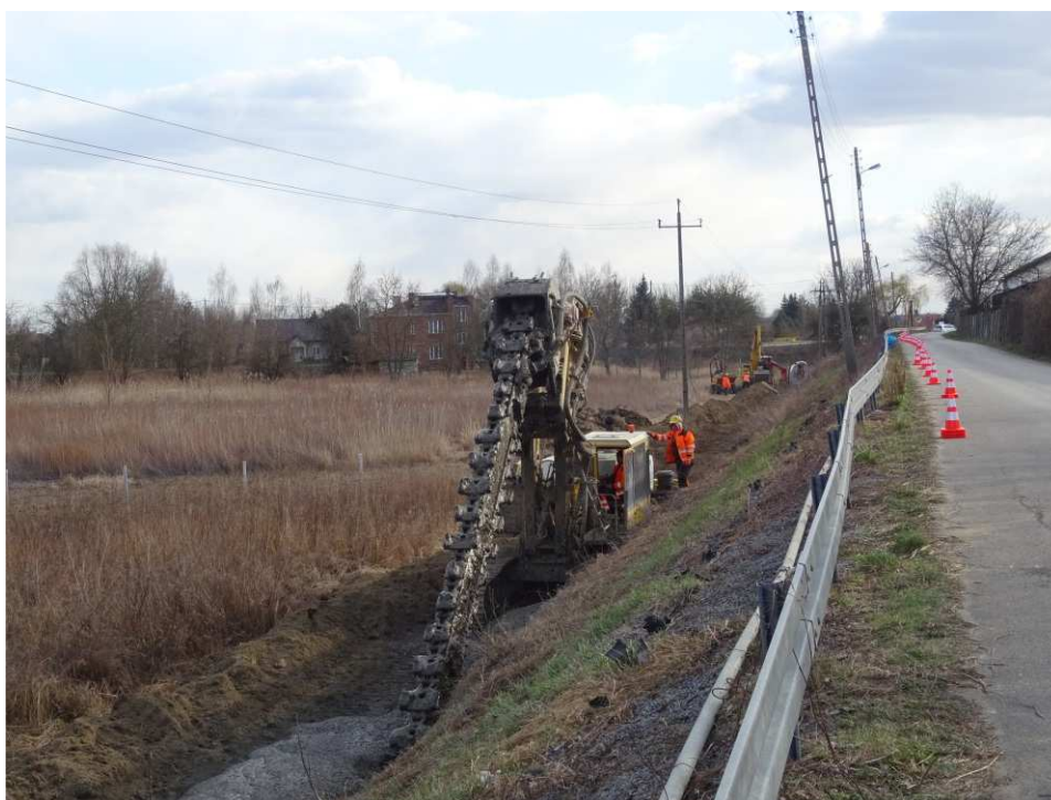
Foto. 23. Budowa przesłony cementowo-bentonitowej – wał opaskowy w ciągu ul. Mostowej, stan w trzeciej dekadzie marca 2020 r. (widok w kierunku SW).
