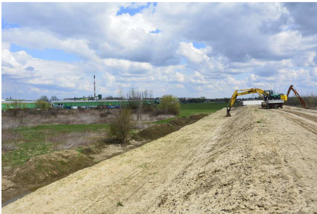
Foto. 33. Zagęszczanie korpusu wału przeciwpowodziowego – wał opaskowy pomiędzy ul. Zarzekowice a prawobrzeżnym wałem Wisły, stan w trzeciej dekadzie kwietnia 2021 r. (widok w kierunku NE).
