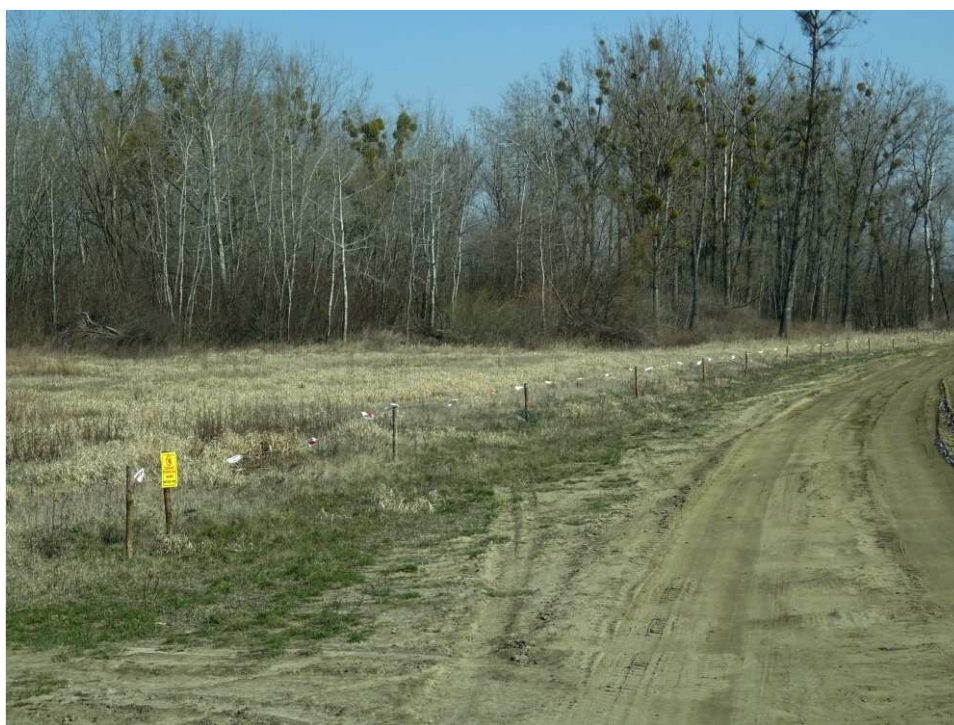
Foto. 17. Oznakowanie obszaru Natura 2000 – droga dojazdowa do terenu robót na prawobrzeżnym wale rzeki Wisły, stan w trzeciej dekadzie marca 2020 r. (widok w kierunku NE).
