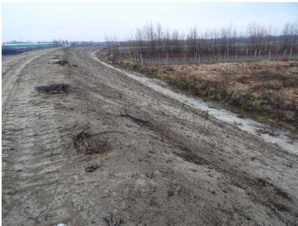
Foto. 7. Stan terenu budowy w pierwszym kwartale okresu realizacji robót na Zadaniu 3 – wał opaskowy pomiędzy ul. Zarzekowice a prawobrzeżnym wałem Wisły, stan w drugiej dekadzie lutego 2020 r. (widok w kierunku NE).
