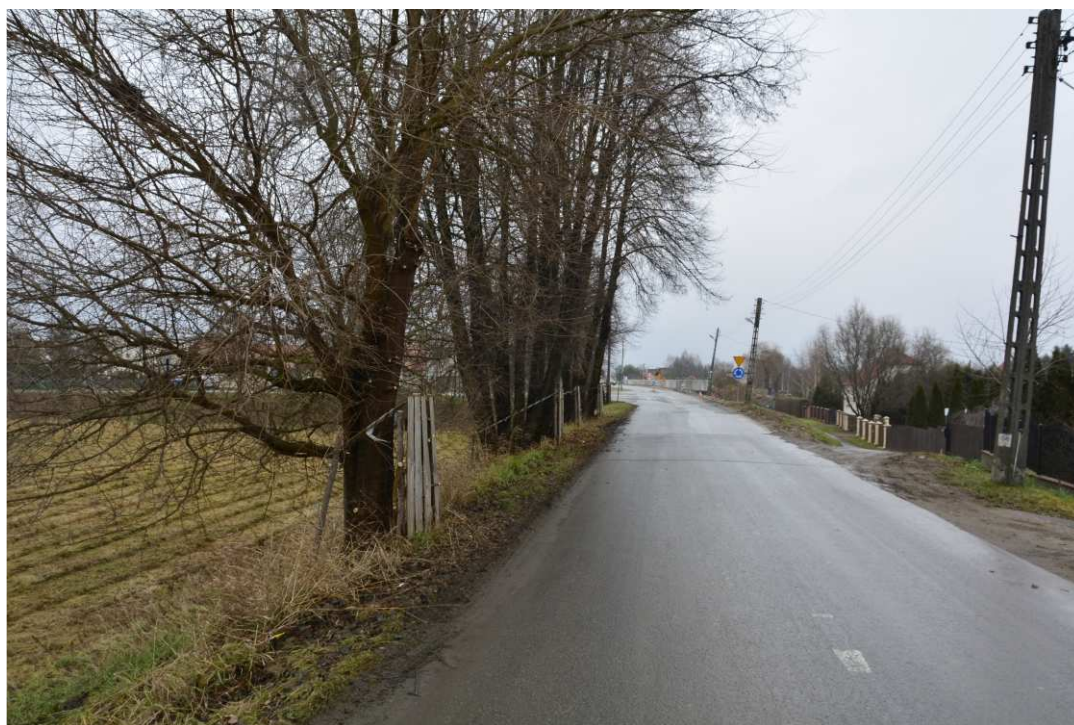
Foto. 20. Zabezpieczenie drzew i krzewów nie planowanych do wycinki – wał opaskowy w ciągu ul. Zarzekowice, stan w drugiej dekadzie grudnia 2021 r. (widok w kierunku NE).
