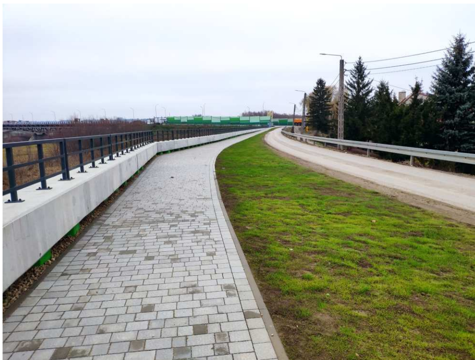
Foto. 50. Stan terenu budowy w ostatnim kwartale okresu realizacji robót na Zadaniu 3 – wał opaskowy w ciągu ul. Mostowej, stan w trzeciej dekadzie listopada 2022 r. (widok w kierunku NE).
