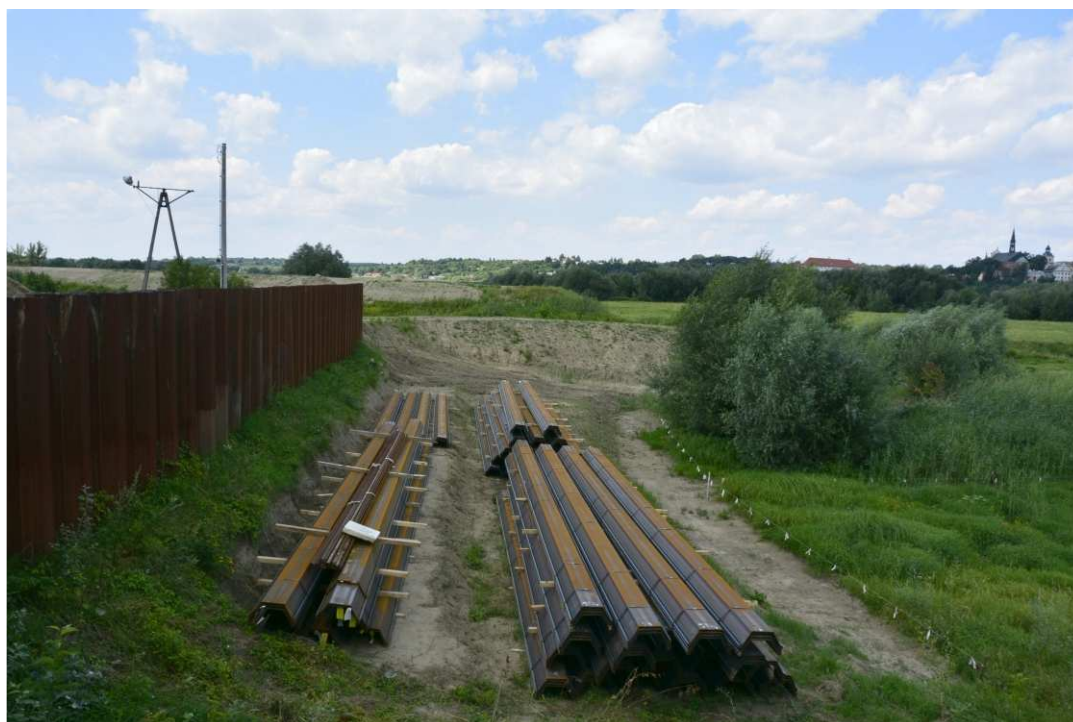
Foto. 18. Oznakowanie obszaru Natura 2000 – brama przeciwpowodziowa na kanale portowym w Sandomierzu, stan w trzeciej dekadzie lipca 2021 r. (widok w kierunku NW).
