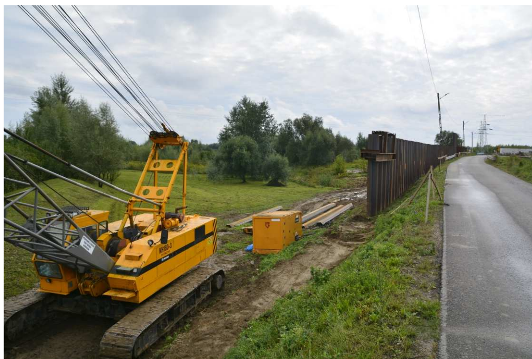
Foto. 26. Budowa muru oporowego z grodzie stalowych – wał opaskowy w ciągu ul. Zarzekowice, stan w pierwszej dekadzie września 2020 r. (widok w kierunku SW).
