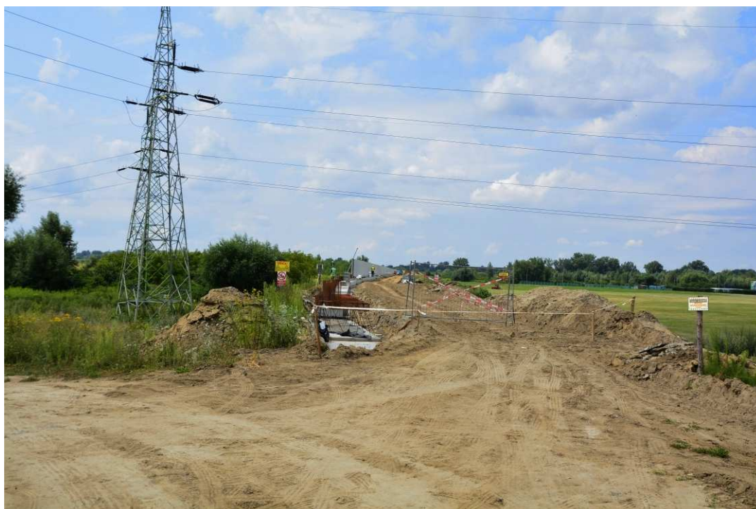
Foto. 12. Oznakowanie terenu budowy – wał opaskowy pomiędzy ul. Zarzekowice a prawobrzeżnym wałem Wisły, stan w trzeciej dekadzie lipca 2020 r. (widok w kierunku SW).
