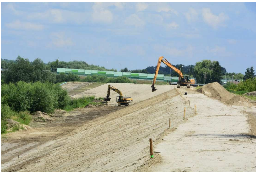
Foto. 36. Humusowanie skarp wału przeciwpowodziowego – prawobrzeżny wał rzeki Wisły wzdłuż brzegu basenu portowego, stan w pierwszej dekadzie lipca 2021 r. (widok w kierunku NE).
