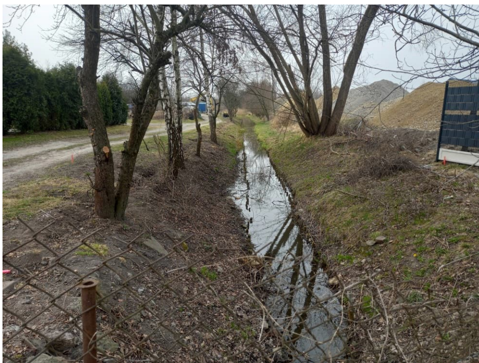
Foto. 8. Stan terenu budowy w pierwszym miesiącu okresu realizacji robót – przebudowywany odcinek Rowu 2 – część górna, stan w trzeciej dekadzie marca 2022 r. (widok w kierunku zachodnim).
