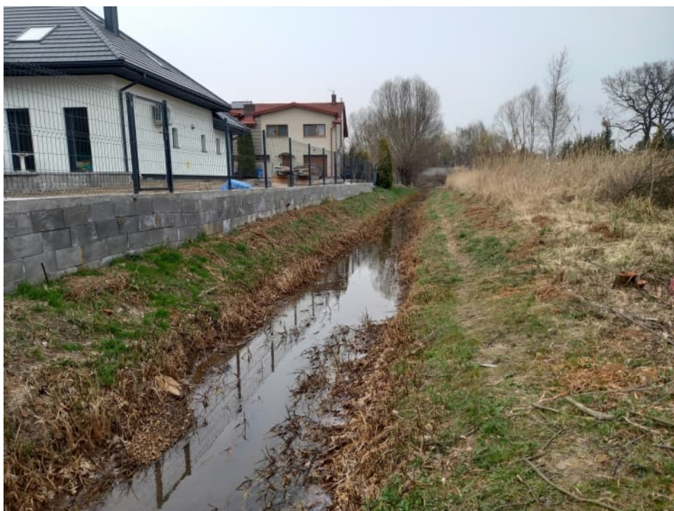
Foto. 6. Stan terenu budowy w pierwszym miesiącu okresu realizacji robót – przebudowywany odcinek Rowu 2a – część górna, stan w trzeciej dekadzie marca 2022 r. (widok w kierunku północnym).
