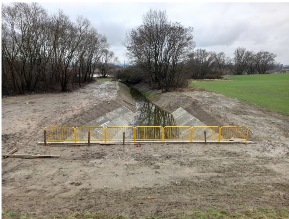
Foto. 49. Stan terenu budowy w ostatnim miesiącu okresu realizacji robót – teren budowy śluzy wałowej na Rowie 2a od strony międzywala Wisły, stan w trzeciej dekadzie stycznia 2023 r. (widok w kierunku południowym).
