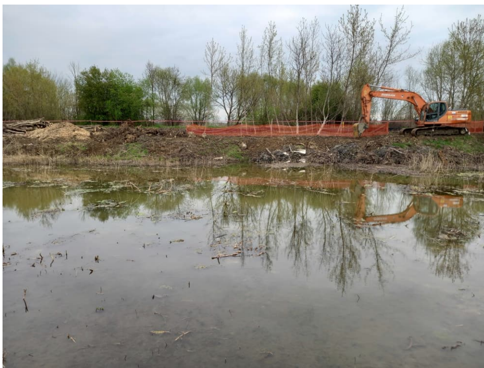
Foto. 24. Zabezpieczenie drzew nie planowanych do wycinki na północnym brzegu powiększanego zbiornika na Rowie 2, stan w trzeciej dekadzie kwietnia 2022 r. (widok w kierunku północnym).
