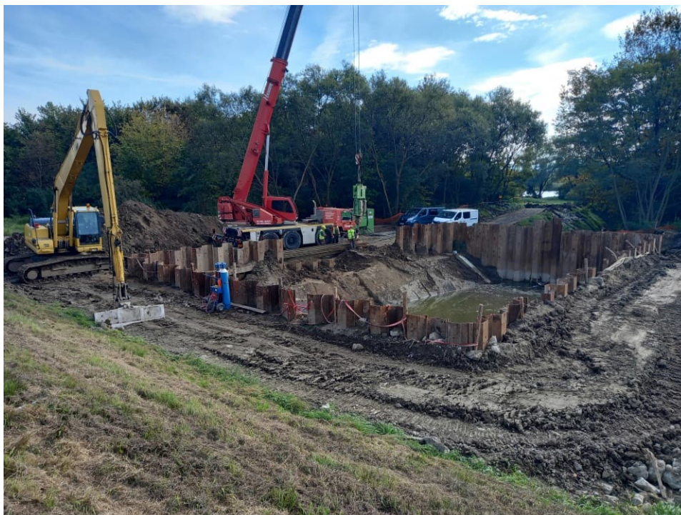
Foto. 32. Roboty larsenowe na dolnym stanowisku śluzy wałowej na Rowie 2a, stan w trzeciej dekadzie września 2022 r. (widok w kierunku południowym).
