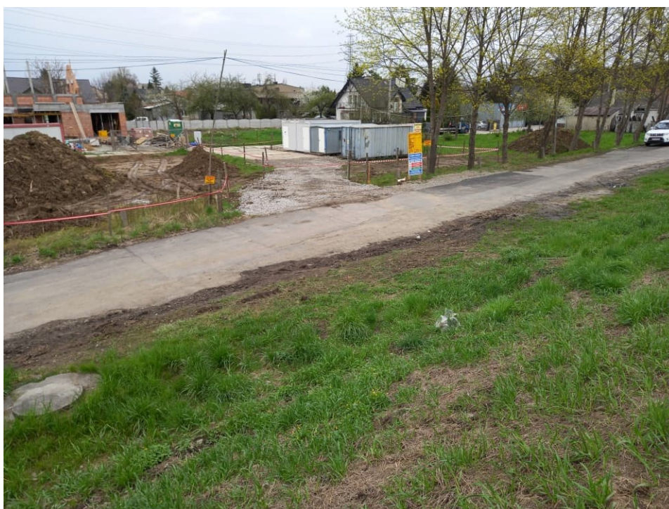
Foto. 16. Oznakowanie wjazdu na teren budowy od strony ul. Zagłoby, stan w trzeciej dekadzie kwietnia 2022 r. (widok w kierunku północno-wschodnim).
