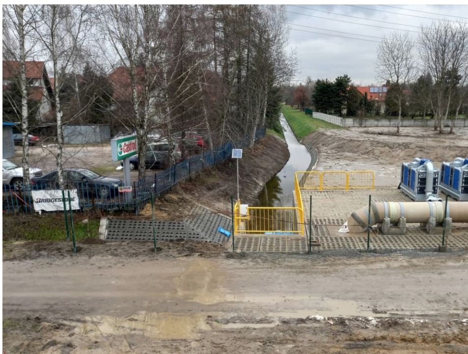
Foto. 50. Stan terenu budowy w ostatnim miesiącu okresu realizacji robót – teren budowy śluzy wałowej na Rowie 2a od strony zawala Wisły, stan w trzeciej dekadzie stycznia 2023 r. (widok w kierunku północnym).
