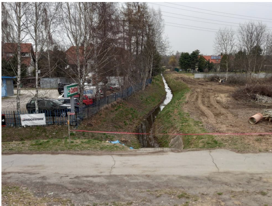
Foto. 2. Stan terenu budowy w pierwszym miesiącu okresu realizacji robót – teren budowy śluzy wałowej na Rowie 2a od strony zawala Wisły, stan w trzeciej dekadzie marca 2022 r. (widok w kierunku północnym).
