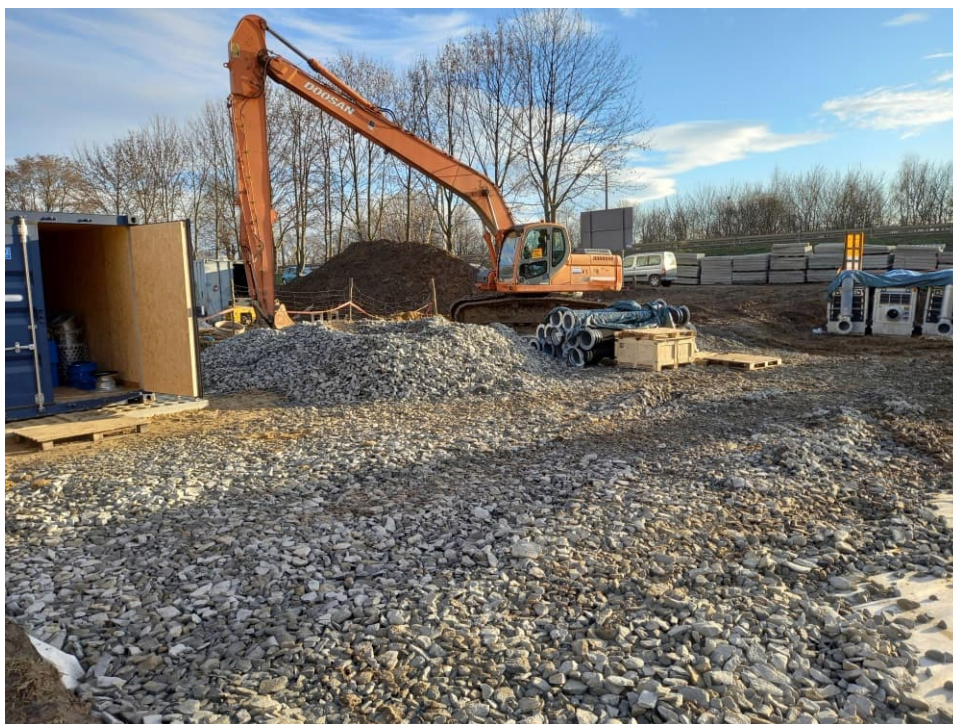
Foto. 39. Budowa placu manewrowego przy stanowisku pomp mobilnych na Rowie 2a, stan w trzeciej dekadzie grudnia 2022 r. (widok w kierunku południowo-wschodnim).
