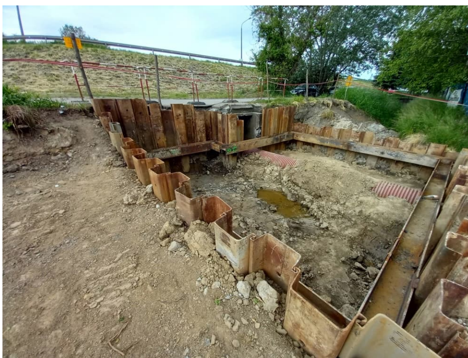
Foto. 22. Zabezpieczenie miejsc niebezpiecznych na terenie budowy śluzy wałowej na Rowie 2a na zawału Wisły, stan w trzeciej dekadzie lipca 2022 r. (widok w kierunku północnym).
