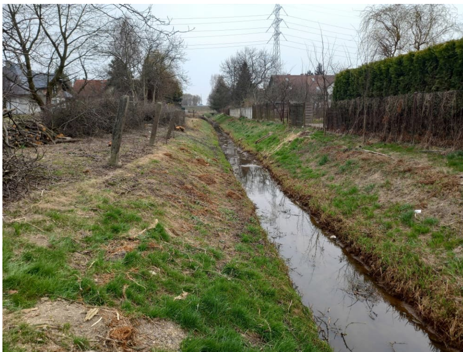
Foto. 5. Stan terenu budowy w pierwszym miesiącu okresu realizacji robót – przebudowywany odcinek Rowu 2a – część dolna, stan w trzeciej dekadzie marca 2022 r. (widok w kierunku południowym).
