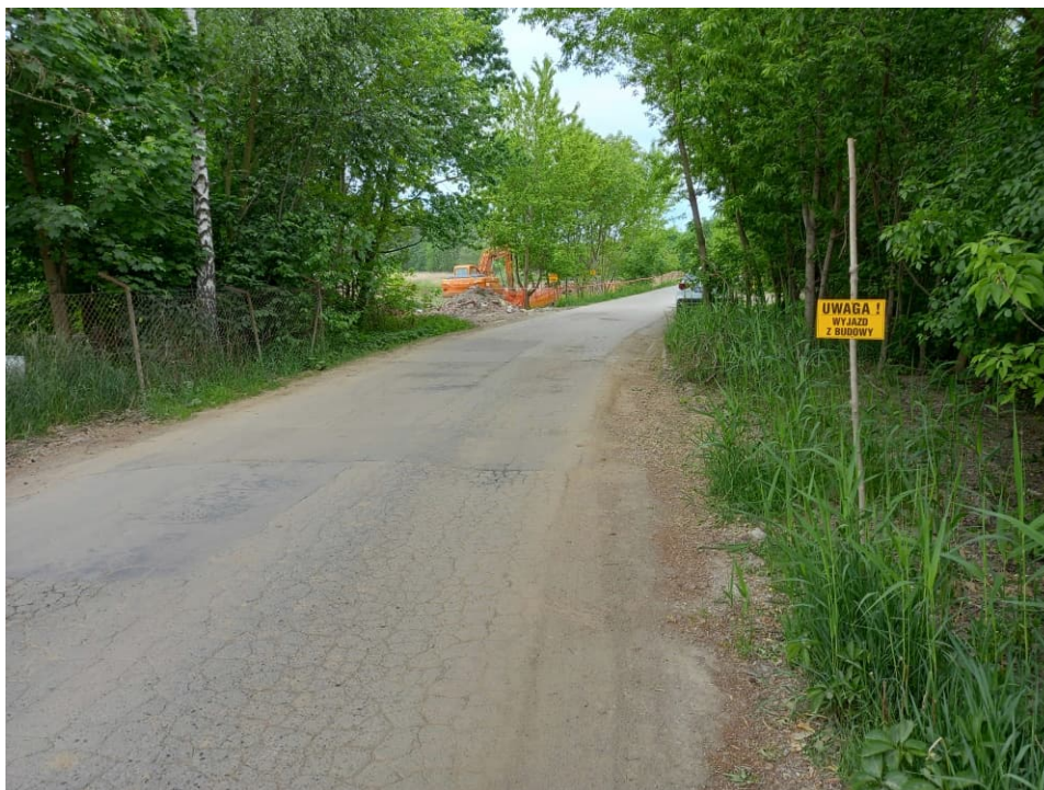
Foto. 18. Oznakowanie wjazdu na teren budowy od strony ul. Odmętowej, stan w trzeciej dekadzie kwietnia 2022 r. (widok w kierunku zachodnim).
