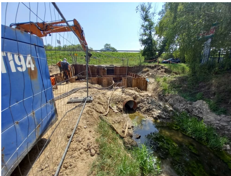
Foto. 34. Zapewnienie drożności Rowu 2a w okresie robót na śluzy wałowej, stan w trzeciej dekadzie czerwca 2022 r. (widok w kierunku południowym).
