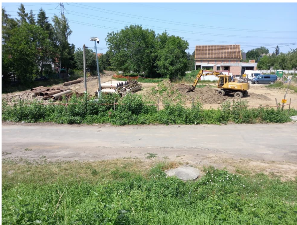
Foto. 19. Wygradzenie terenu budowy wzdłuż ul. Zagłoby, stan w trzeciej dekadzie czerwca 2022 r. (widok w kierunku północnym).
