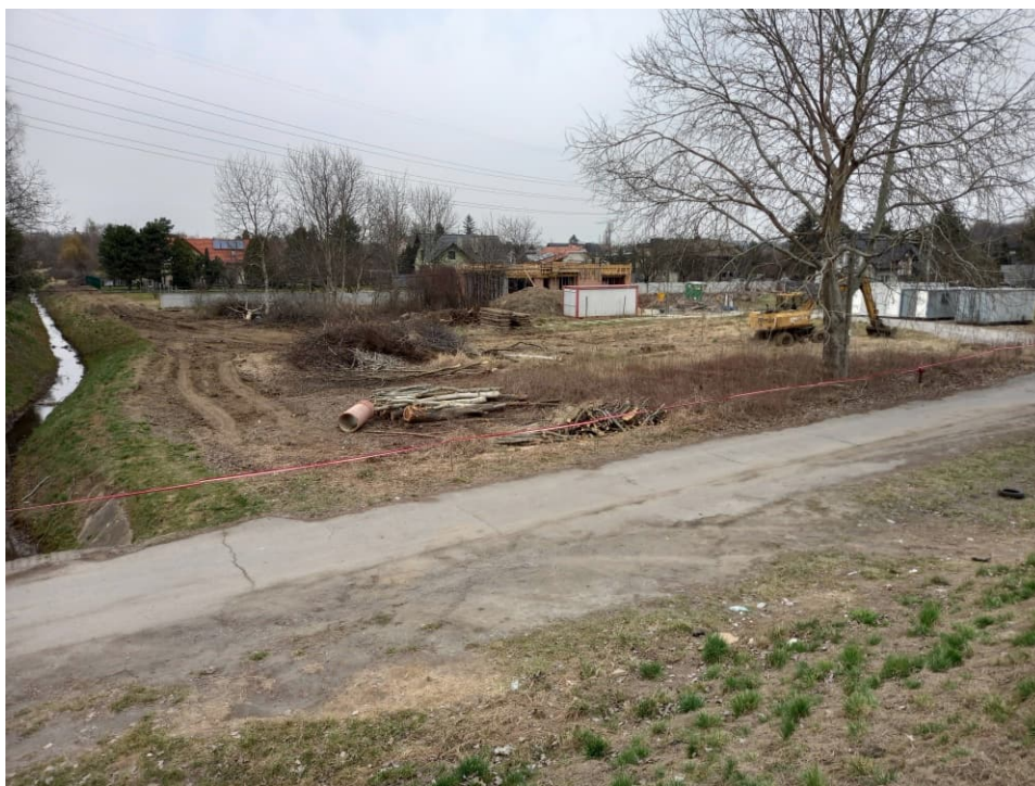
Foto. 3. Stan terenu budowy w pierwszym miesiącu okresu realizacji robót – teren budowy stanowiska pompowego dla pomp mobilnych oraz zbiornika retencyjnego powyżej śluzy wałowej, stan w trzeciej dekadzie marca 2022 r. (widok w kierunku północnym).
