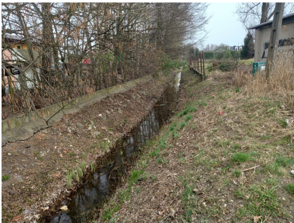
Foto. 7. Stan terenu budowy w pierwszym miesiącu okresu realizacji robót – przebudowywany odcinek Rowu 2 – część dolna, stan w trzeciej dekadzie marca 2022 r. (widok w kierunku wschodnim).
