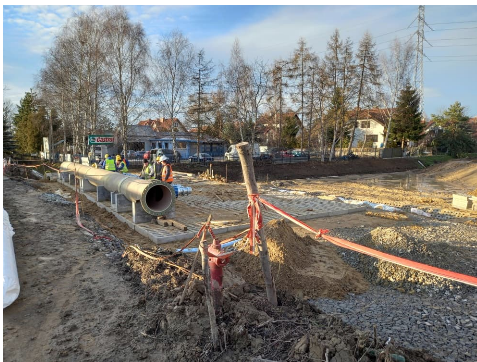
Foto. 38. Budowa stanowiska pomp mobilnych na Rowie 2a, stan w trzeciej dekadzie grudnia 2022 r. (widok w kierunku zachodnim).
