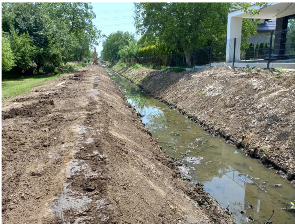
Foto. 41. Formowanie skarp brzegowych na Rowie 2a, stan w trzeciej dekadzie czerwca 2022 r. (widok w kierunku południowym).
