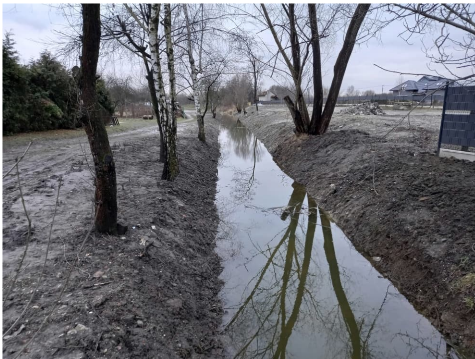
Foto. 56. Stan terenu budowy w ostatnim miesiącu okresu realizacji robót – przebudowywany odcinek Rowu 2 – część górna, stan w trzeciej dekadzie stycznia 2023 r. (widok w kierunku zachodnim).
