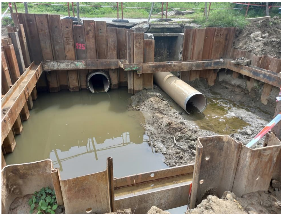
Foto. 33. Przebudowywany rurociąg grawitacyjny (po prawej) i nowy rurociąg ciśnieniowy (po lewej) na terenie budowy śluzy wałowej na Rowie 2a, stan w trzeciej dekadzie lipca 2022 r. (widok w kierunku południowym).
