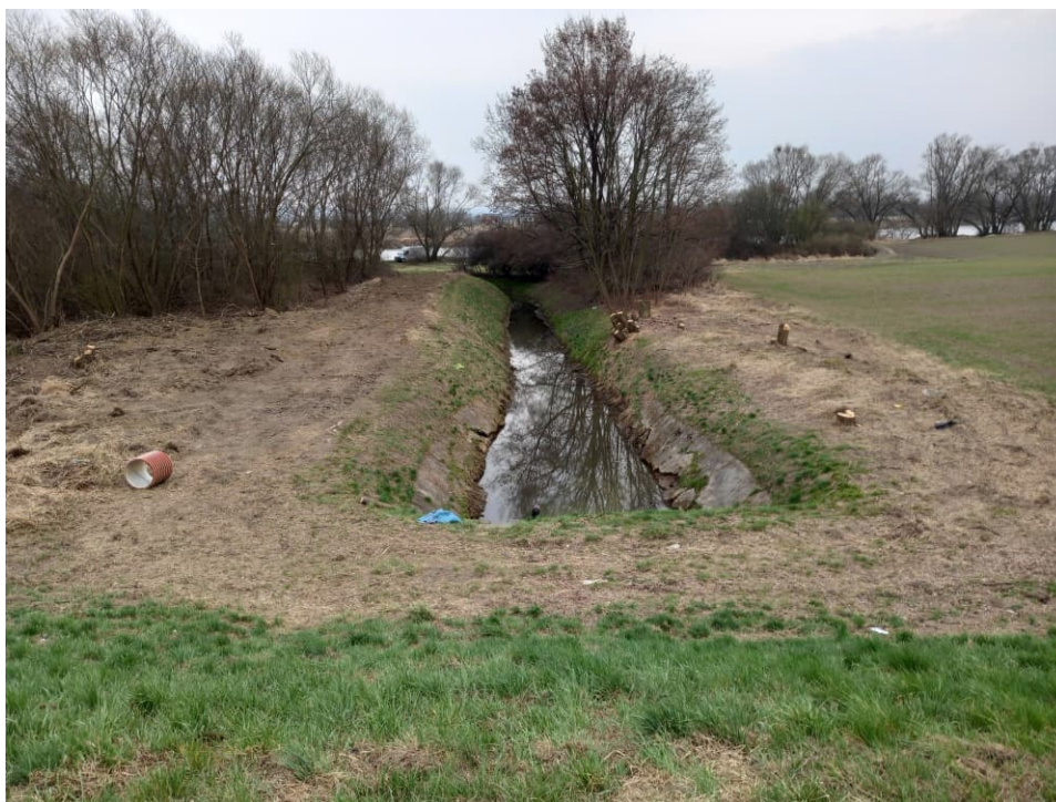
Foto. 1. Stan terenu budowy w pierwszym miesiącu okresu realizacji robót – teren budowy śluzy wałowej na Rowie 2a od strony międzywala Wisły, stan w trzeciej dekadzie marca 2022 r. (widok w kierunku południowym).
