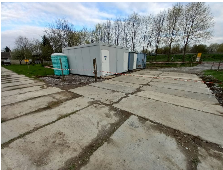
Foto. 15. Zaplecze budowy na lewobrzeżnym zawalu Wisły, stan w trzeciej dekadzie kwietnia 2022 r. (widok w kierunku południowym).
