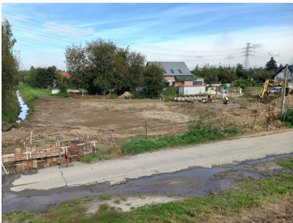
Foto. 36. Formowanie skarp zbiornika retencyjnego na Rowie 2a, stan w trzeciej dekadzie września 2022 r. (widok w kierunku północnym).
