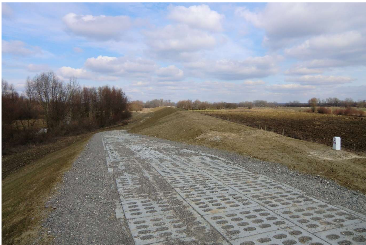
Fot. 2. Zrealizowana przebudowa wału (Sekcja I km 1+310, przejazd wałowy) (źródło: zasoby własne AECOM Polska Sp. z o.o.).
