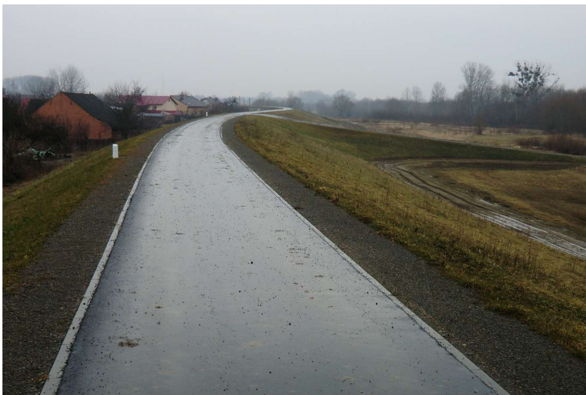
Fot. 13. Rozbudowany wał i przejazd wałowy (Sekcja III 0+887) (źródło: zasoby własne AECOM Polska Sp. z o.o.).
