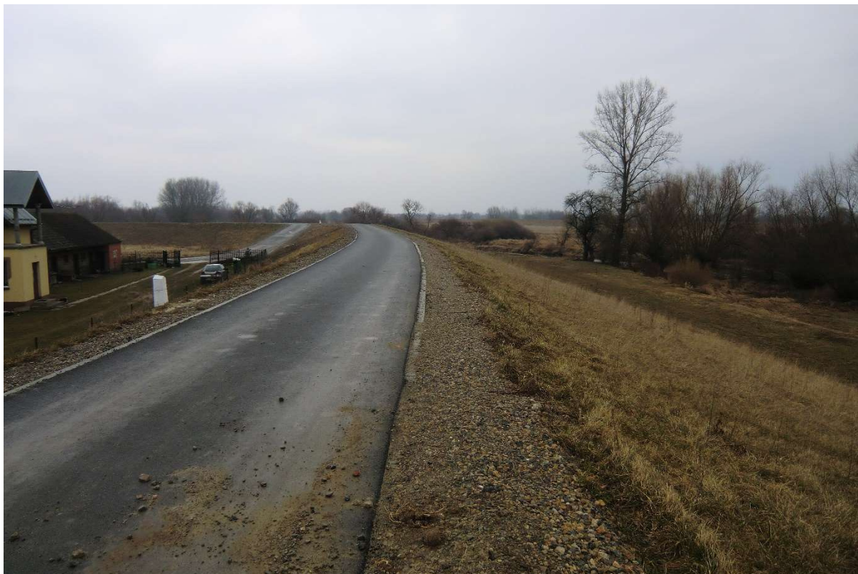
Fot. 10. Rozbudowany wał (Sekcja III km 0+112) (źródło: zasoby własne AECOM Polska Sp. z o.o.).
