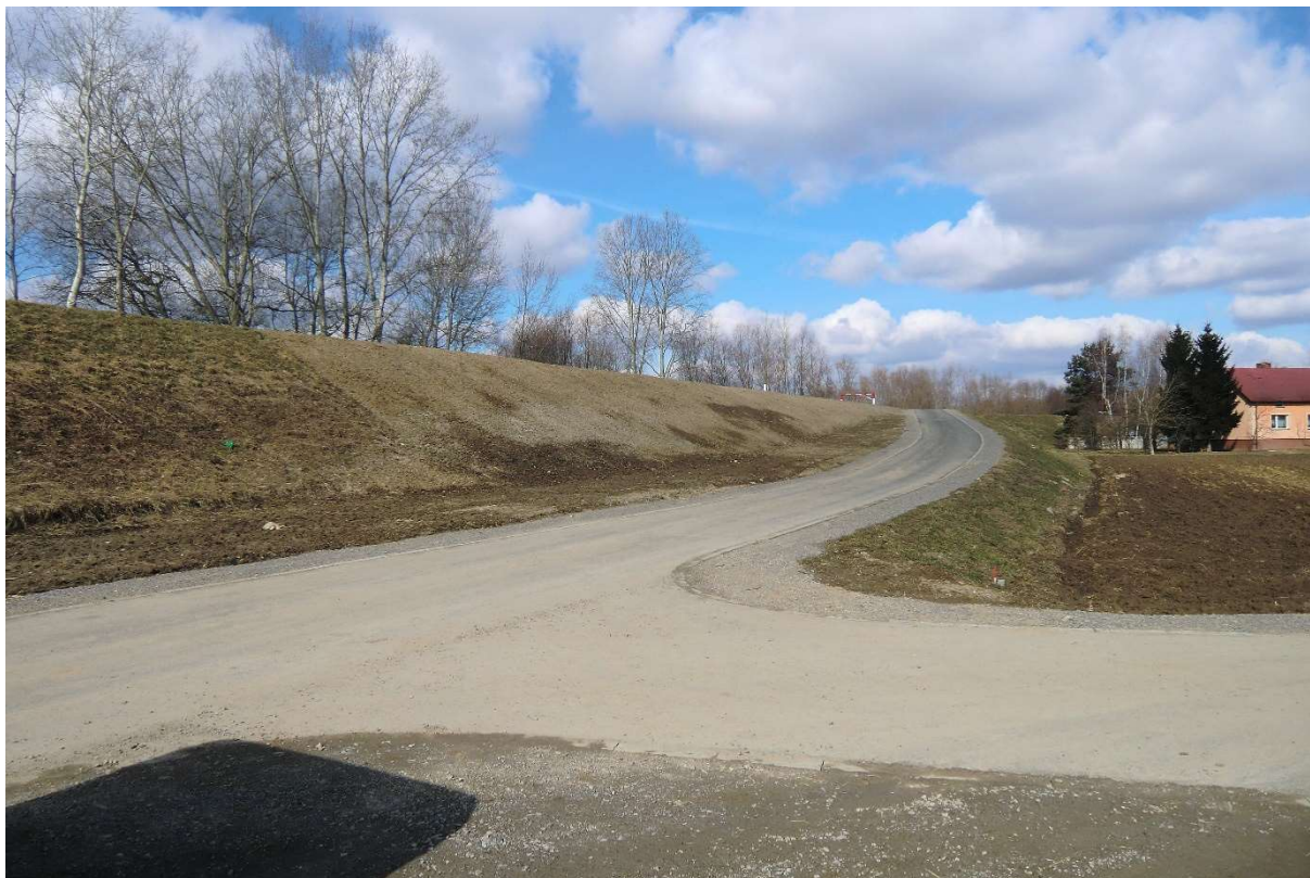
Fot. 8. Rozbudowany wał (Sekcja II km 2+425) (źródło: zasoby własne AECOM Polska Sp. z o.o.).
