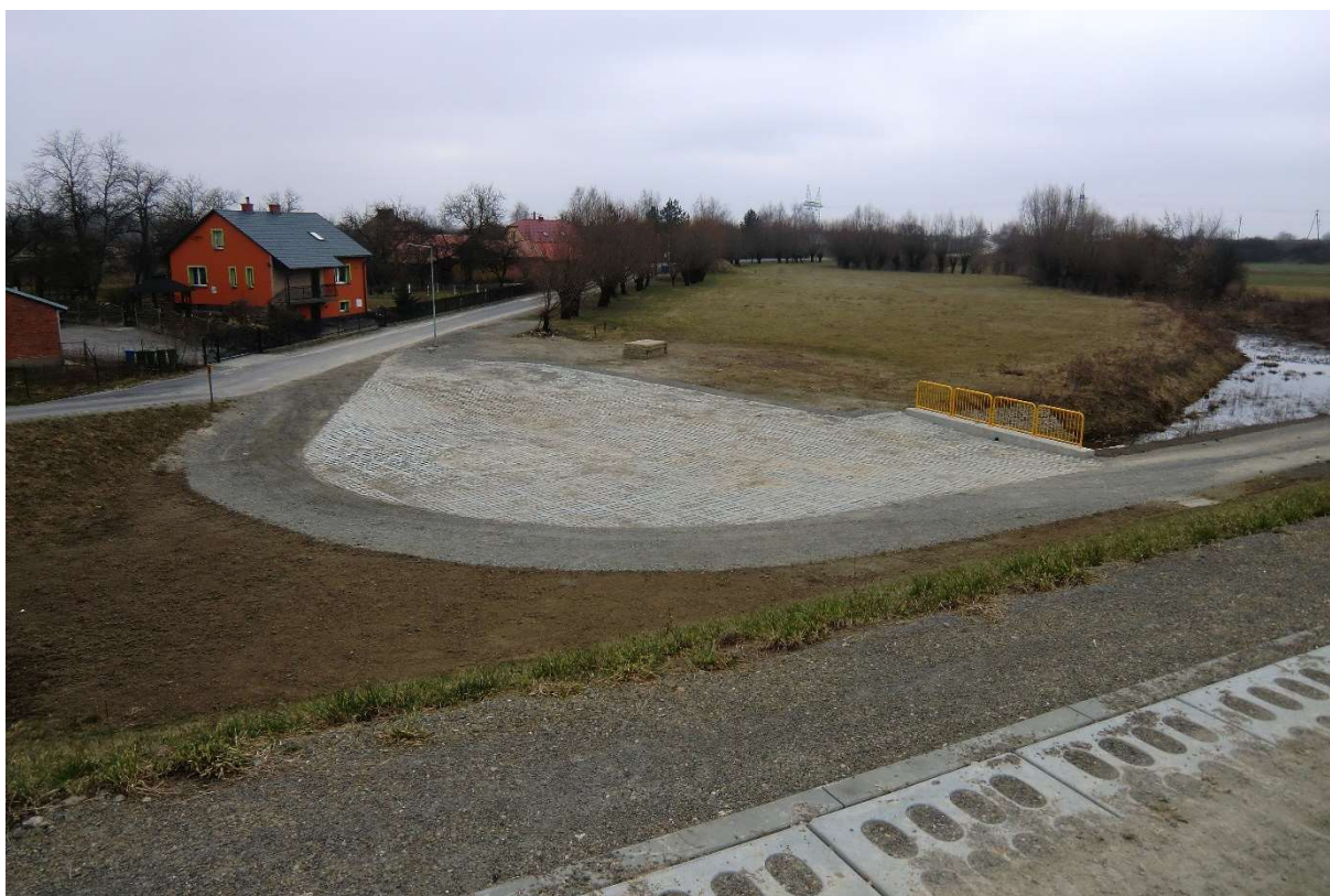
Fot. 11. Plac manewrowy (Sekcja III km 0+300) (źródło: zasoby własne AECOM Polska Sp. z o.o.).
