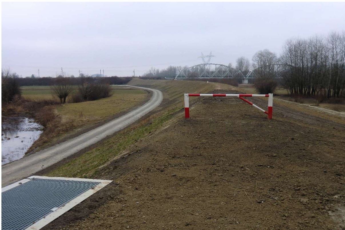
Fot. 12. Rozbudowany wał (Sekcja III widok ogólny) (źródło: zasoby własne AECOM Polska Sp. z o.o.).
