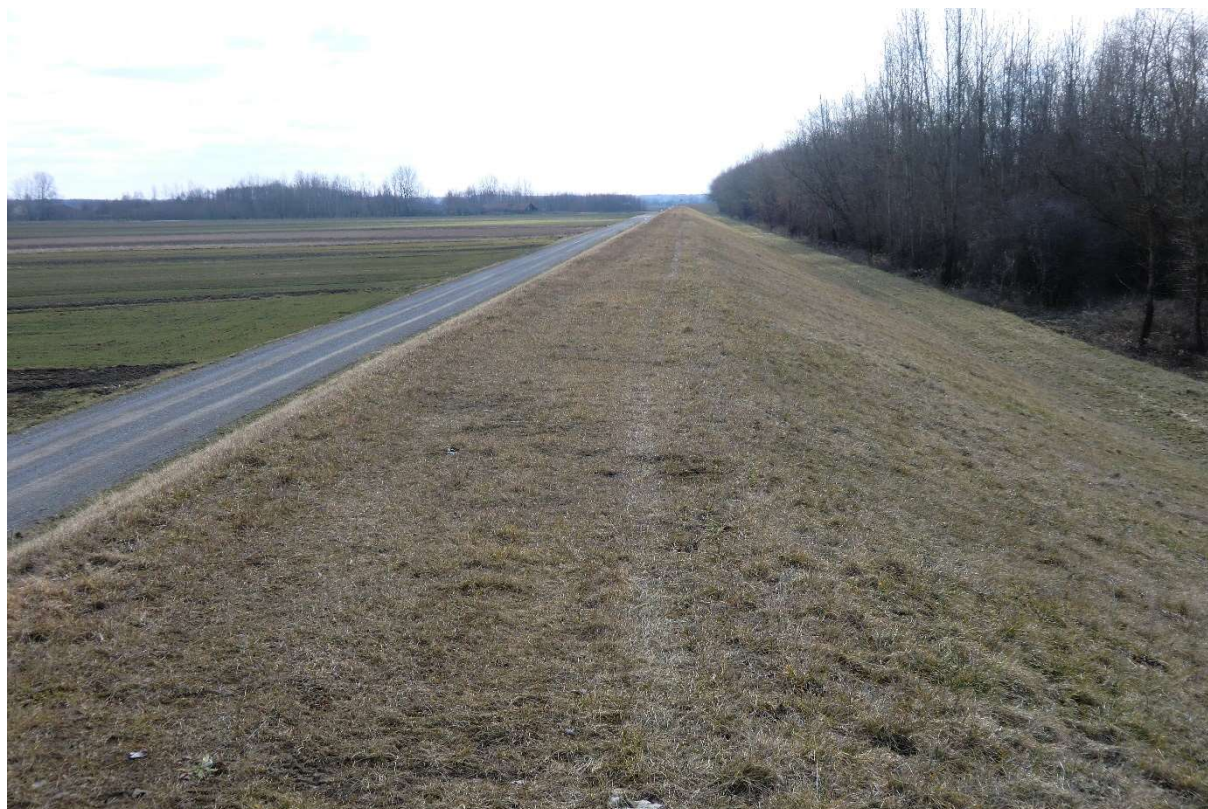
Fot. 14. Rozbudowany wał rz. San (Sekcja San 1+000) (źródło: zasoby własne AECOM Polska Sp. z o.o.).
