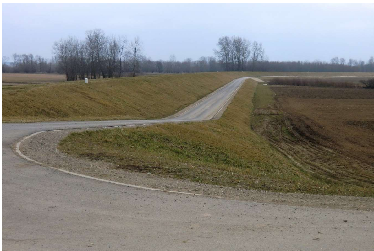
Fot. 2. Zrealizowana przebudowa wału (San III km 0.05 – widok ogólny w górę obiektu) (źródło: zasoby własne Aecom Polska Sp. z o.o.).
