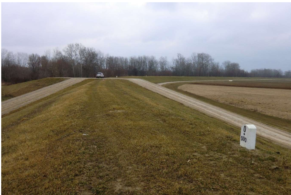
Fot. 1. Zrealizowana przebudowa wału (San III km 0.4 – widok ogólny) (źródło: zasoby własne Aecom Polska Sp. z o.o.).
