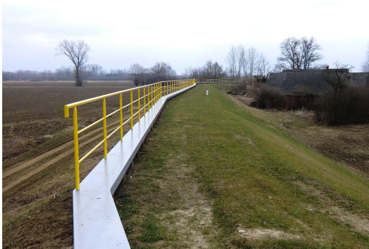
Fot. 3. Zrealizowana przebudowa wału (San III km 2.955– podwyższenie rzędnych korony wału poprzez mur oporowy z oczepem i barierą zabezpieczającą) (źródło: zasoby własne Aecom Polska Sp. z o.o.).
