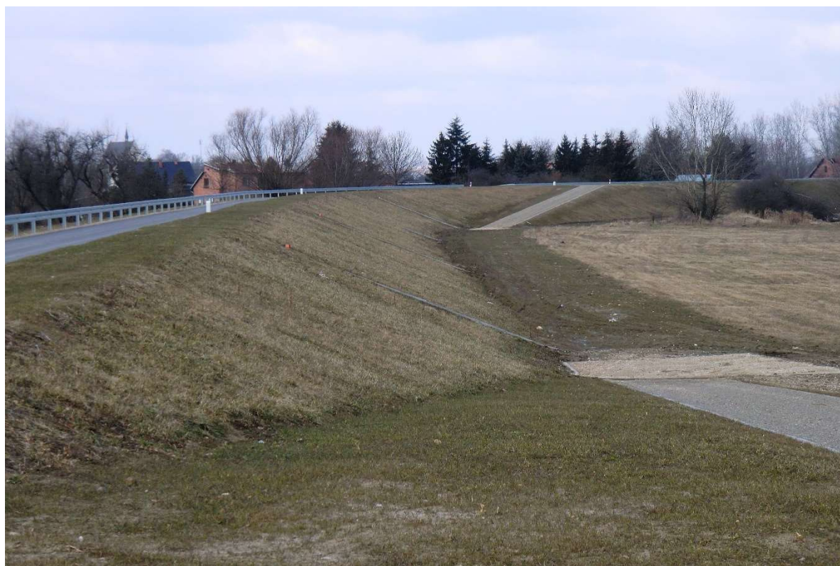
Fot. 7. Zrealizowana przebudowa wału (San III km 3.895 – zjazd w międzywale) (źródło: zasoby własne Aecom Polska Sp. z o.o.).
