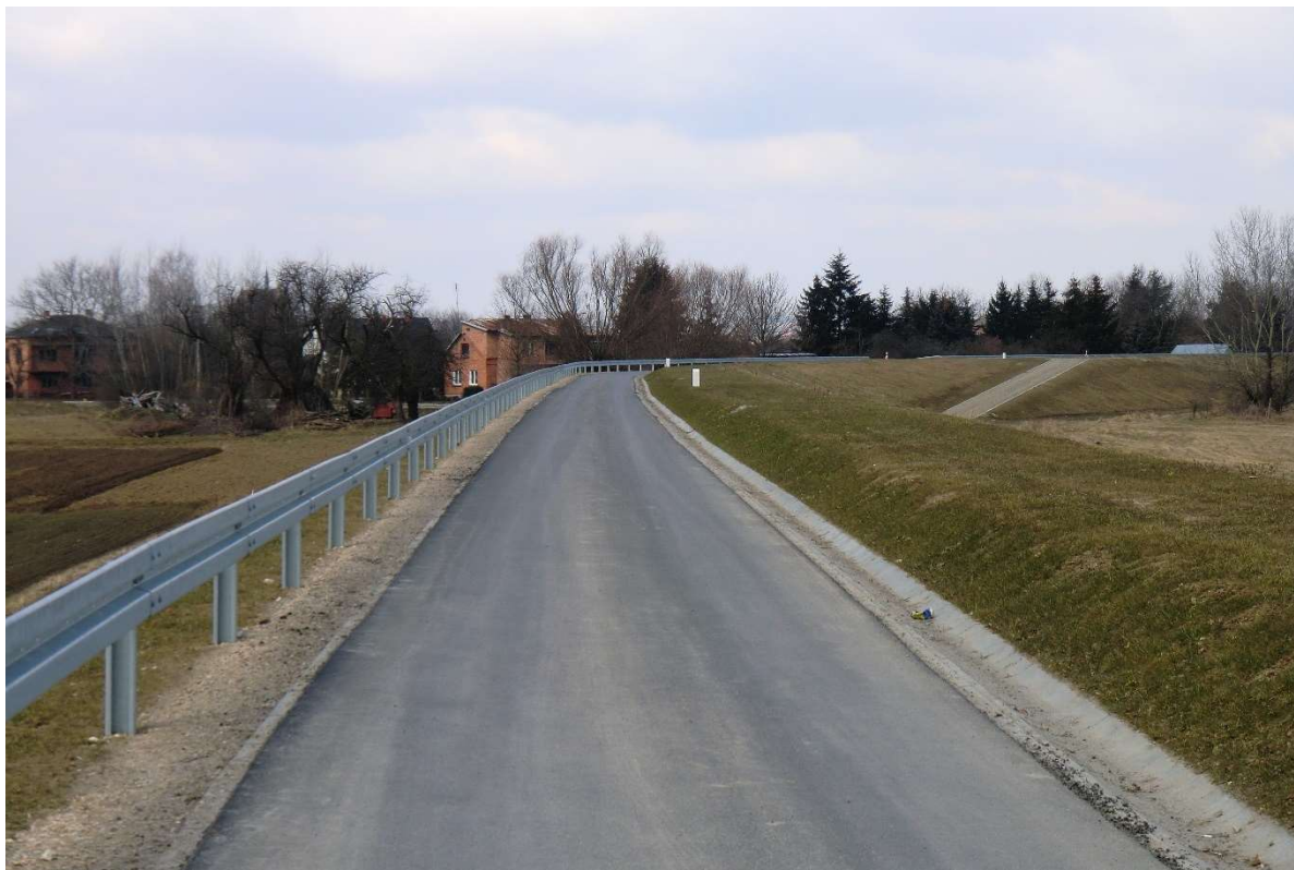
Fot. 6. Zrealizowana przebudowa wału (San III km 3.895 – droga publiczna na koronie wału) (źródło: zasoby własne Aecom Polska Sp. z o.o.).
