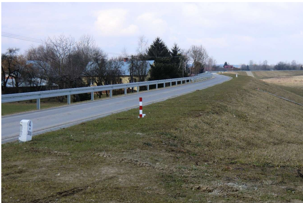
Fot. 8. Zrealizowana przebudowa wału (San III km 4.315 – droga publiczna na koronie wału) (źródło: zasoby własne Aecom Polska Sp. z o.o.).
