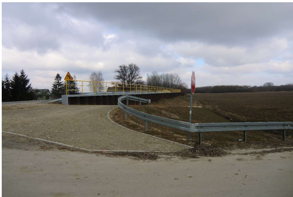
Fot. 5. Zrealizowana przebudowa wału (San III km 3.180 – widok ogólny) (źródło: zasoby własne Aecom Polska Sp. z o.o.).
