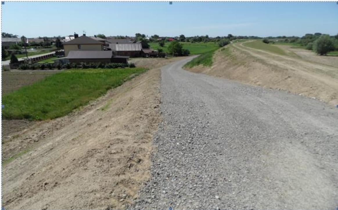
Fot. 5. Roboty zrealizowane w miejscu zbliżenia do zabudowy mieszkaniowej (km 7+500 – 7+700 wg projektu budowlanego) (źródło: Raport Miesięczny Wykonawcy).
