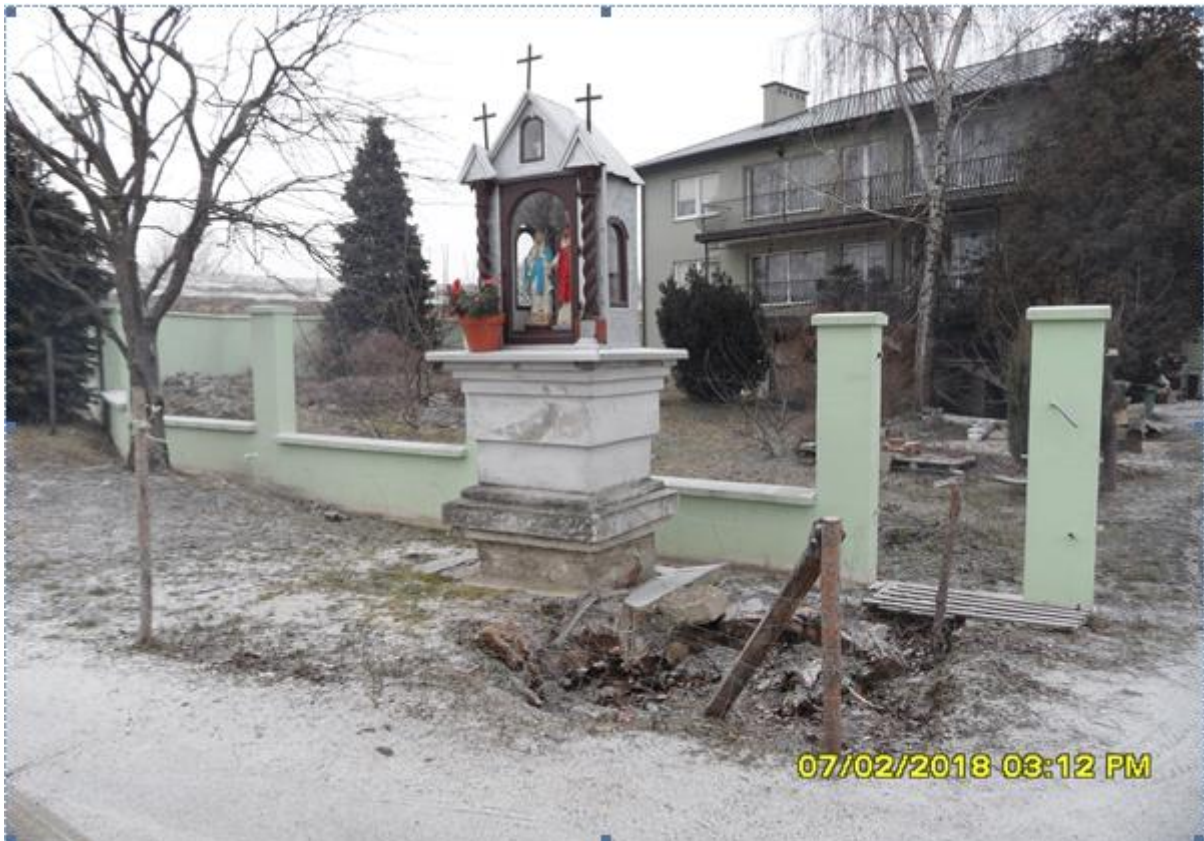
Fot. 9. Zabezpieczenie kapliczki w trakcie realizacji robót (źródło: zasoby własne Aecom Polska Sp. z o.o.).
