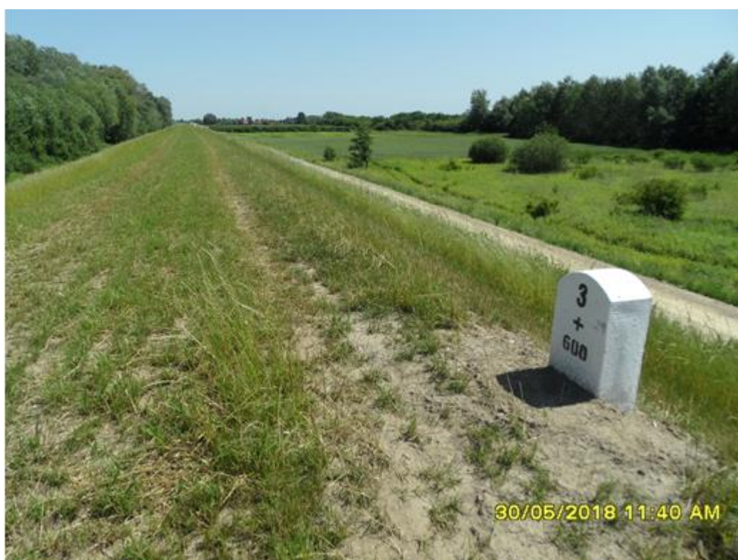
Fot. 1. Zrealizowana przebudowa wału (km 3+600 zgodnie z uzgodnieniem z Zarządem Zlewni w Sandomierzu, wg projektu budowlanego km 9+550) (źródło: zasoby własne Aecom Polska Sp. z o.o.).
