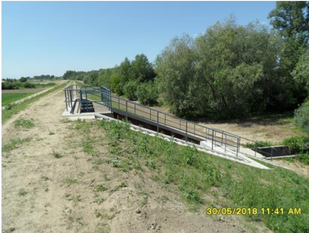
Fot. 2. Zrealizowana przebudowa przepustu wałowego (wylot z oczyszczalni ścieków w km 9+589 – kilometraż wg projektu budowlanego) (źródło: zasoby własne Aecom Polska Sp. z o.o.).
