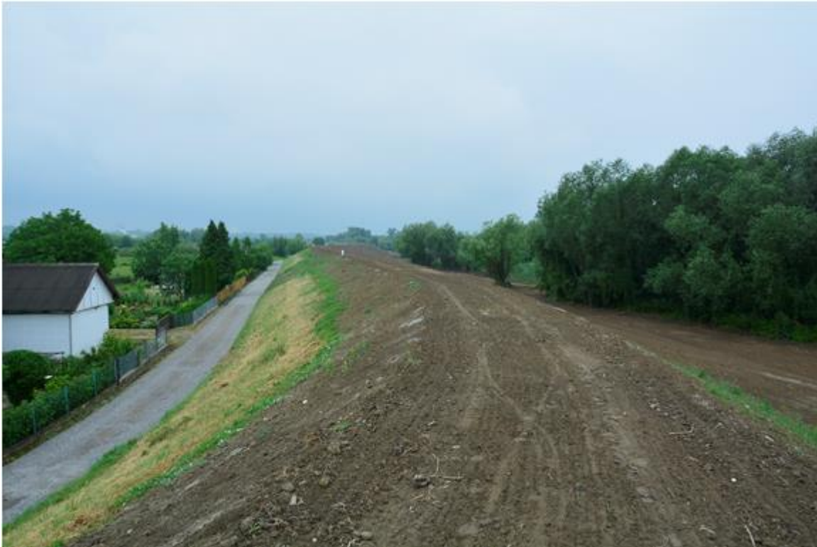
Fot. 4. Roboty realizowane w miejscu zbliżenia do zabudowy mieszkaniowej (km 12+800 – 13+400 wg projektu budowlanego) (źródło: Raport Miesięczny Wykonawcy).
