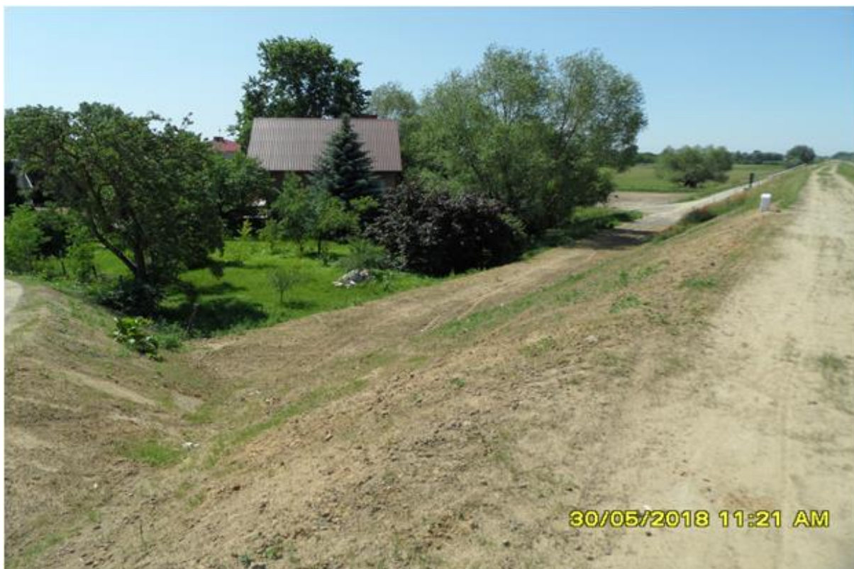
Fot. 6. Roboty zrealizowane w miejscu zbliżenia do zabudowy mieszkaniowej (km 8+200 – 8+300 wg projektu budowlanego) (źródło: zasoby własne Aecom Polska Sp. z o.o.).
