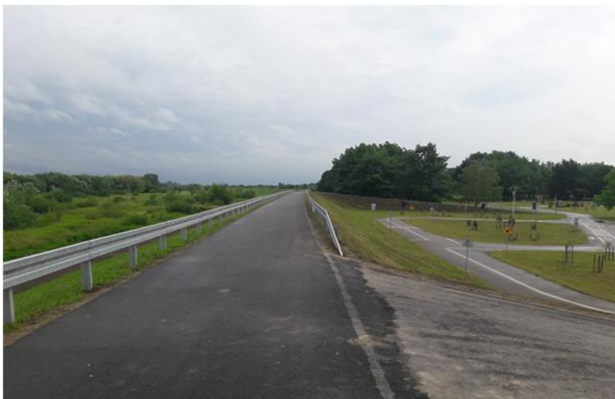
Fot. 7. Rozbudowany wał (km 9+535 zgodnie z uzgodnieniem z Zarządem Zlewni w Sandomierzu, wg projektu budowlanego km 15+485) (źródło: Raport Miesięczny Wykonawcy).
