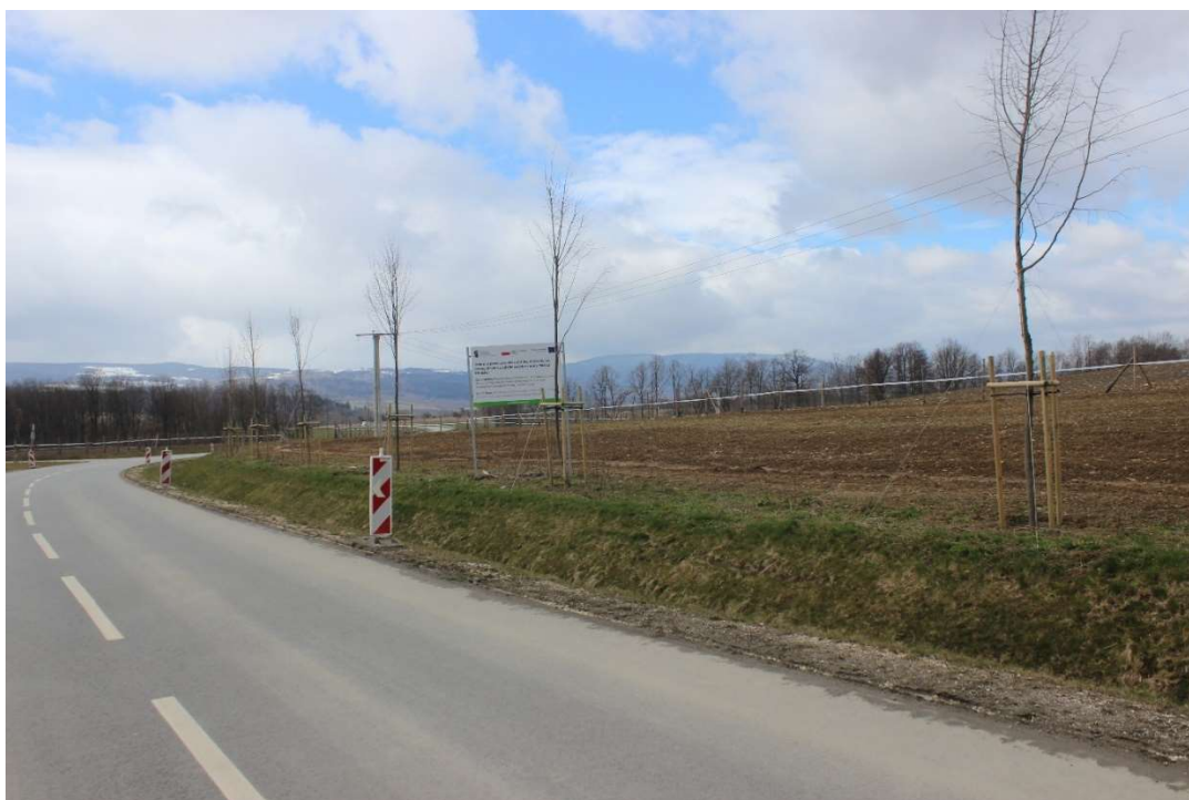
Fot.3. Wybudowany nowy odcinek drogi powiatowej 3233D. Wzdłuż drogi widoczne są nasadzenia drzew – etap realizacji Kontraktu.
