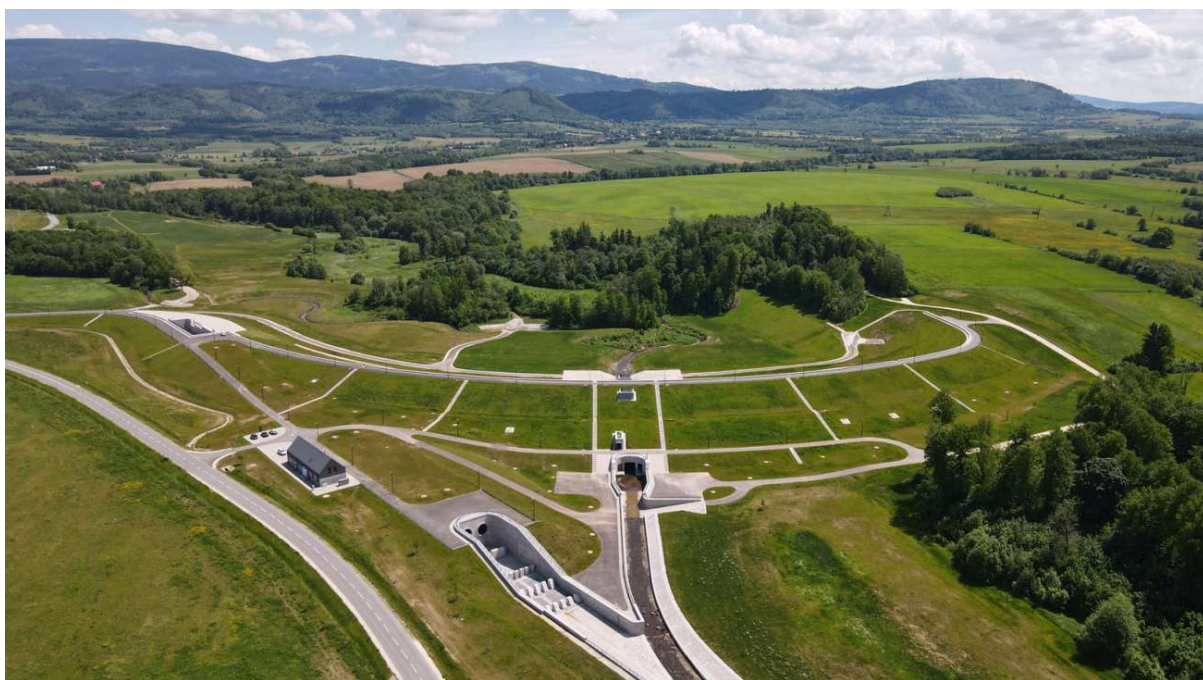
Fot.11. Zbiornik przeciwpowodziowy od strony zachodniej, etap eksploatacji (Okres Zgłaszania Wad) – maj 2022 r.
