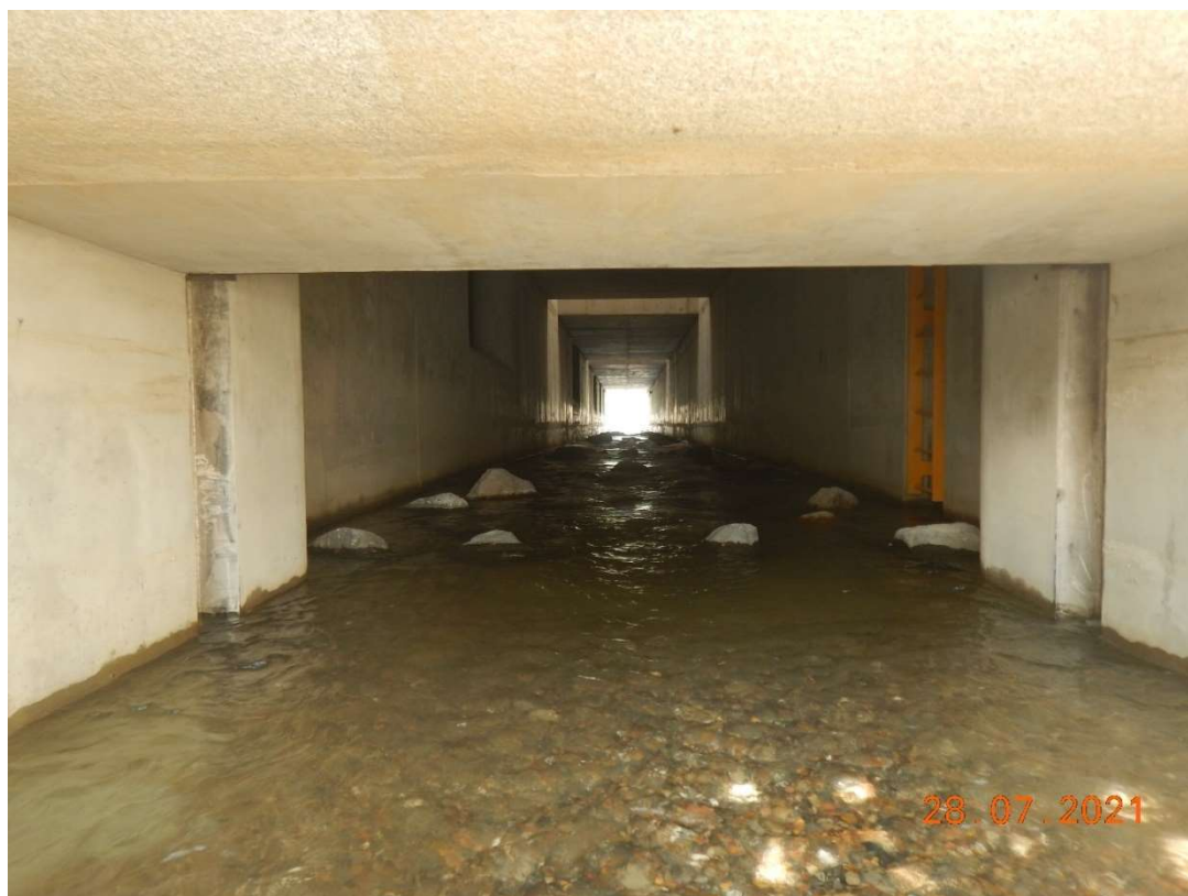
Fot.5. Układ dna potoku Goworówka w sztolni pod zaporą zbiornika – etap realizacji Kontraktu.
