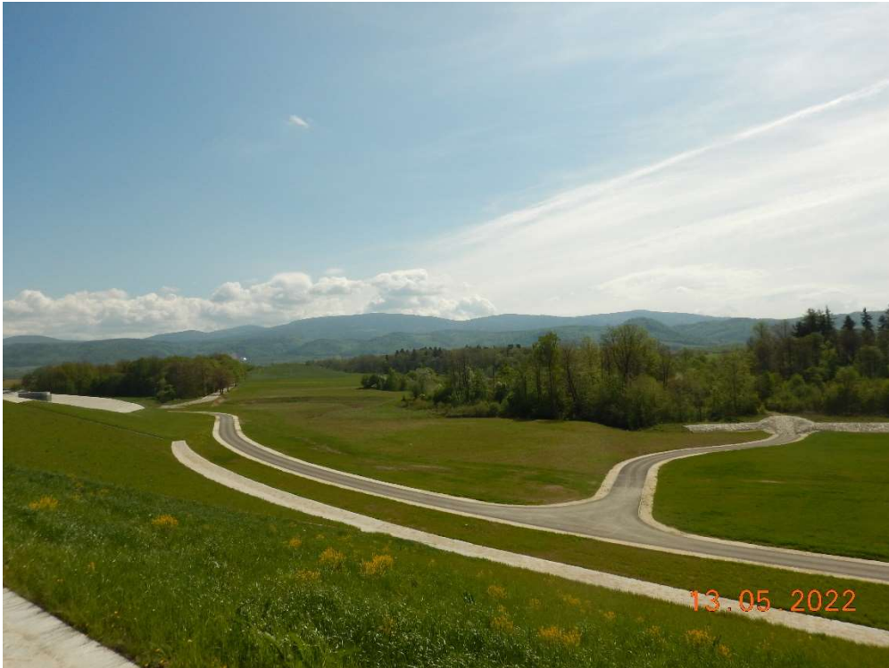
Fot.7. Czasza zbiornika przeciwpowodziowego – widoczny wzrost mieszanki traw (Okres Zgłaszania Wad).
