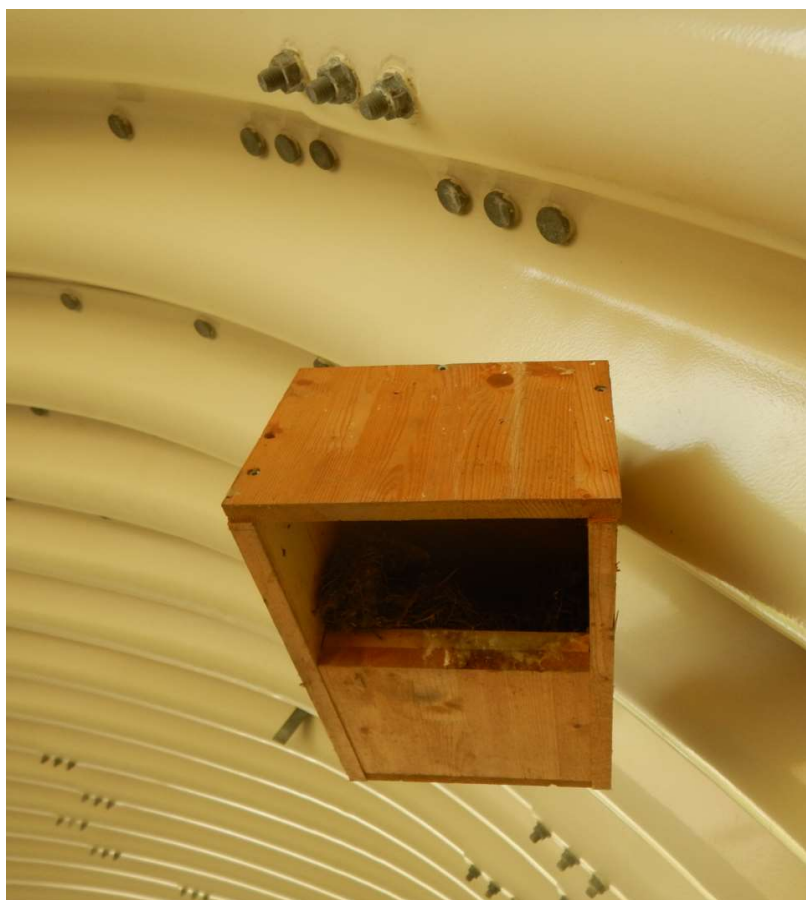
Fot.9. Budka dla pluszcza zamontowana na terenie inwestycji pod nowym mostem na potoku Nowinka – etap realizacji Kontraktu.
