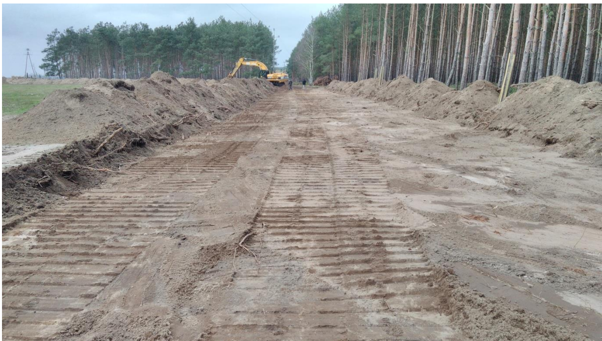
Listopad 2017, Chlewice, zdjęcie humusu przed rozpoczęciem robót
