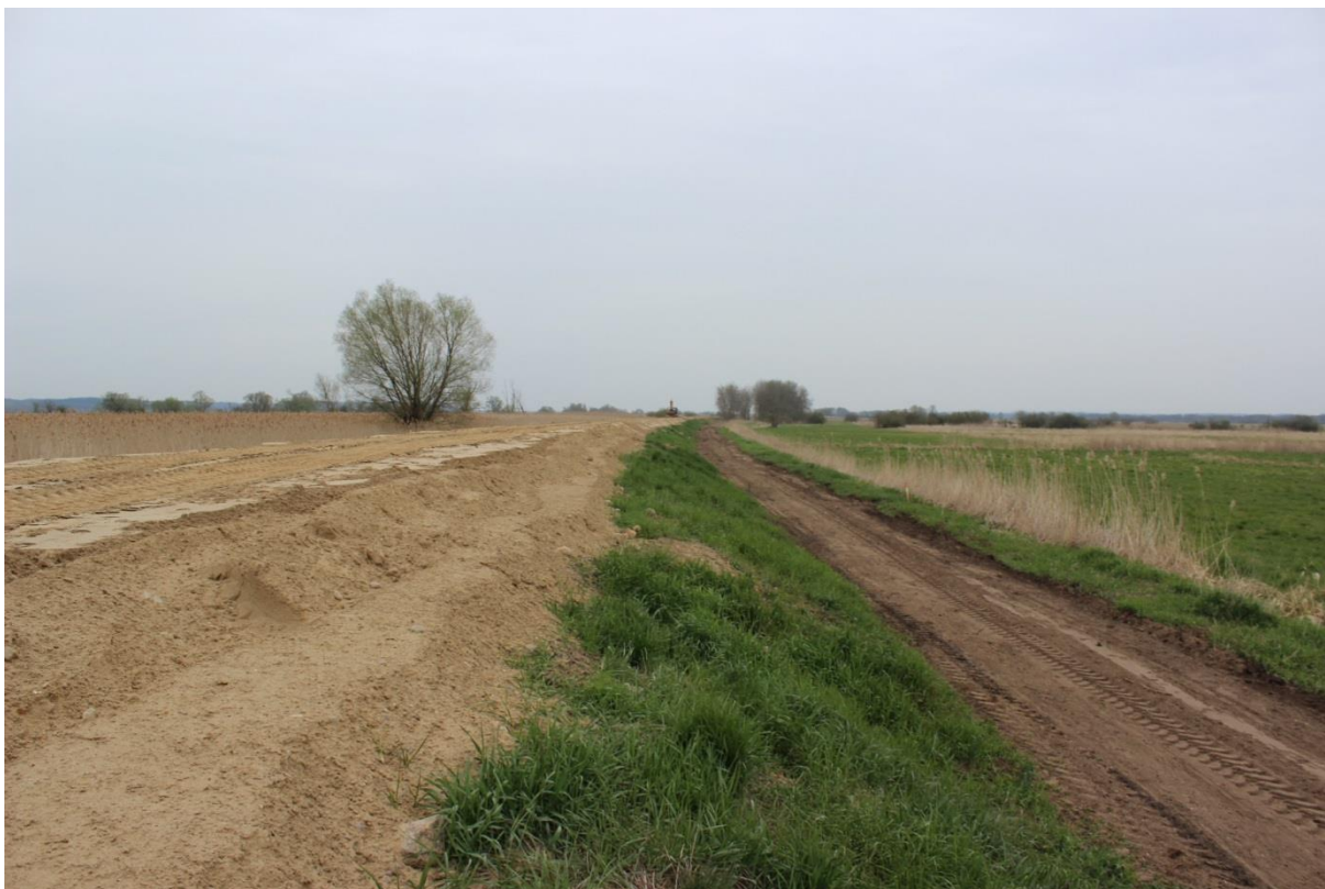
Kwiecień 2021, Marwice - Krajnik, podwyższanie korony wału
