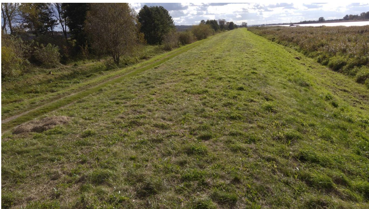
Wrzesień 2017, Marwice - Krajnik, stan wałów przed rozpoczęciem modernizacji
