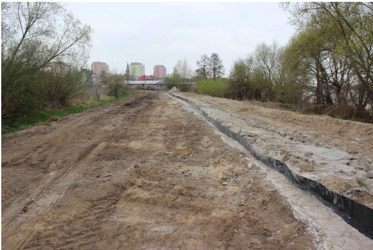
Kwiecień 2021, Gryfino-Mniszki, wykonana przesłona przeciwfiltracyjna
