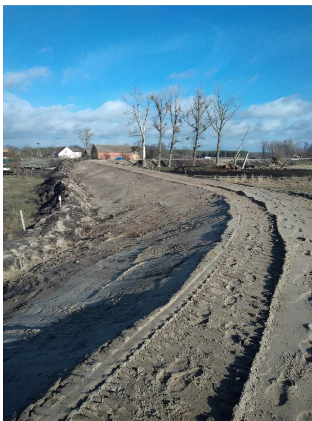
Styczeń 2019, Chlewice, wał przed rozpoczęciem humusowania
