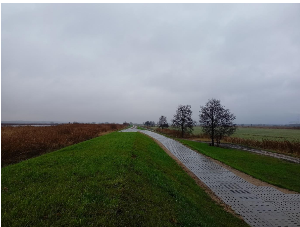
Listopad 2021, Marwice - Krajnik, porost traw na wale oraz zrekultywowany teren po zapleczu budowy (po prawej stronie drogi)
