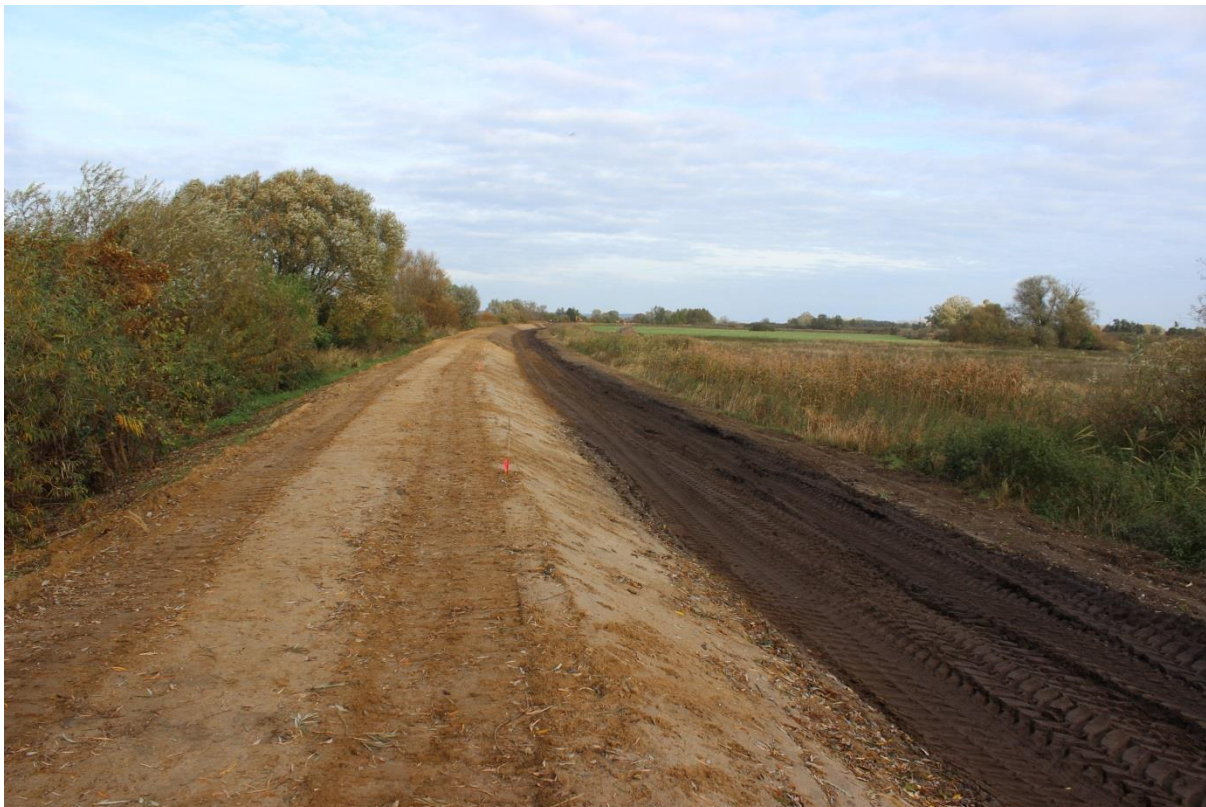
Październik 2021, Gryfino-Mniszki, konstrukcja wału przygotowana do humusowania
