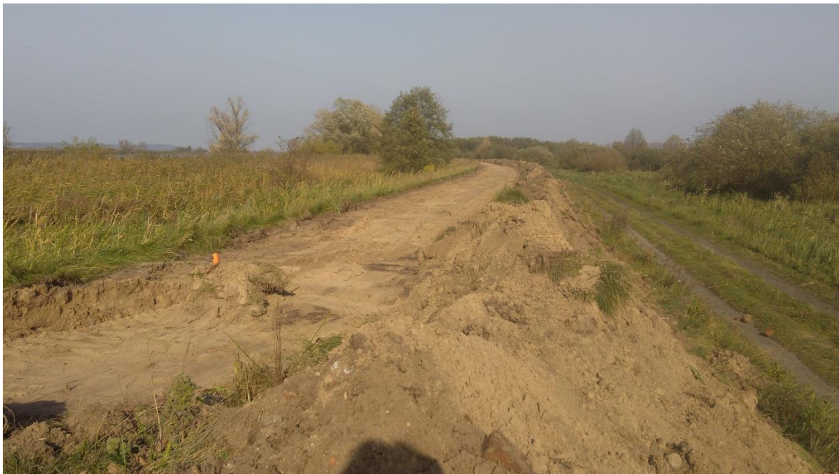
Październik 2017, Gryfino-Mniszki, inicjalny zakres robót
