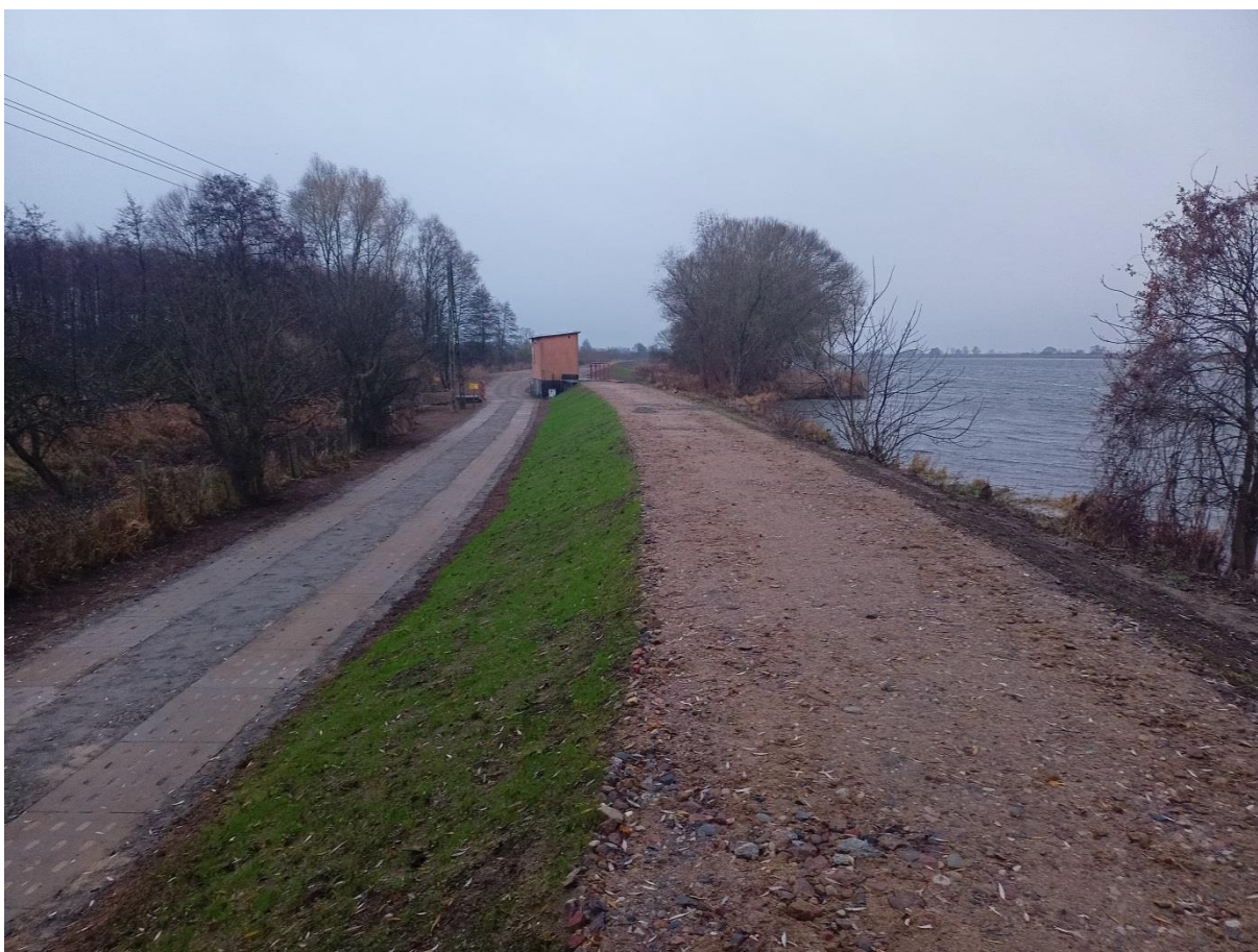
Listopad 2021, Gryfino-Mniszki, ukończony odcinek wału
