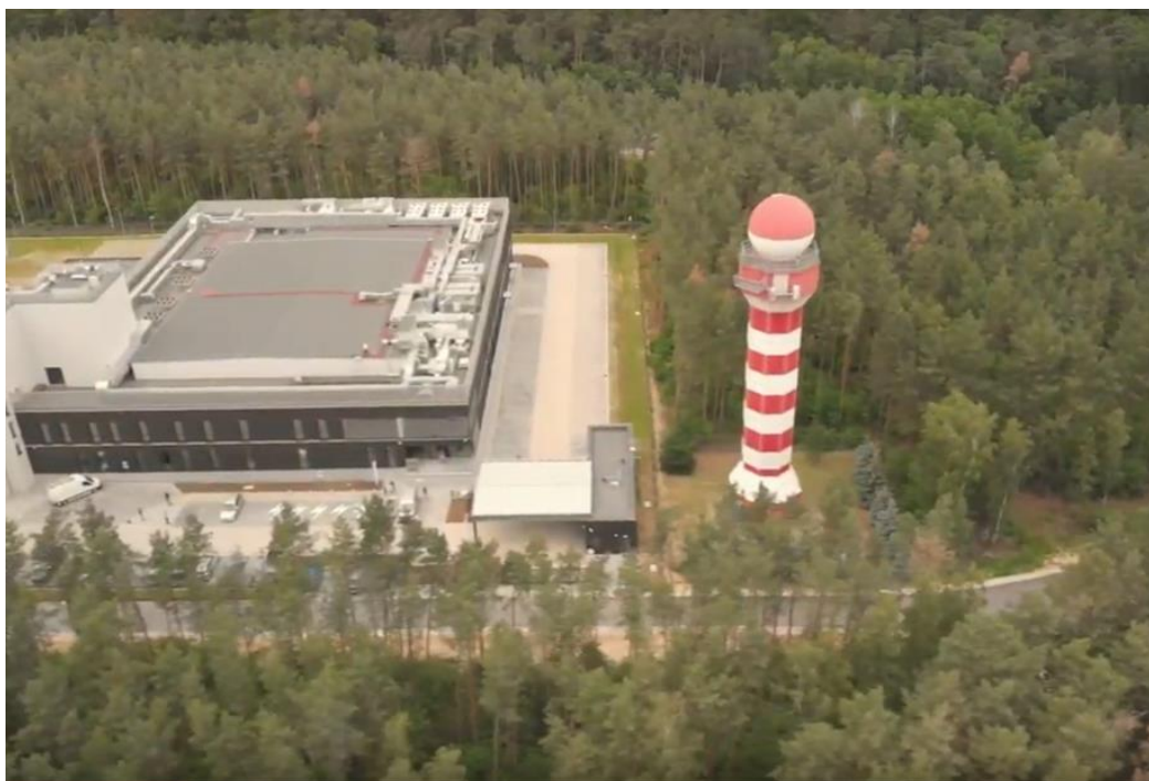
Fotografia 6 Lokalizacja stacji radarowej Poznań - widok ogólny
