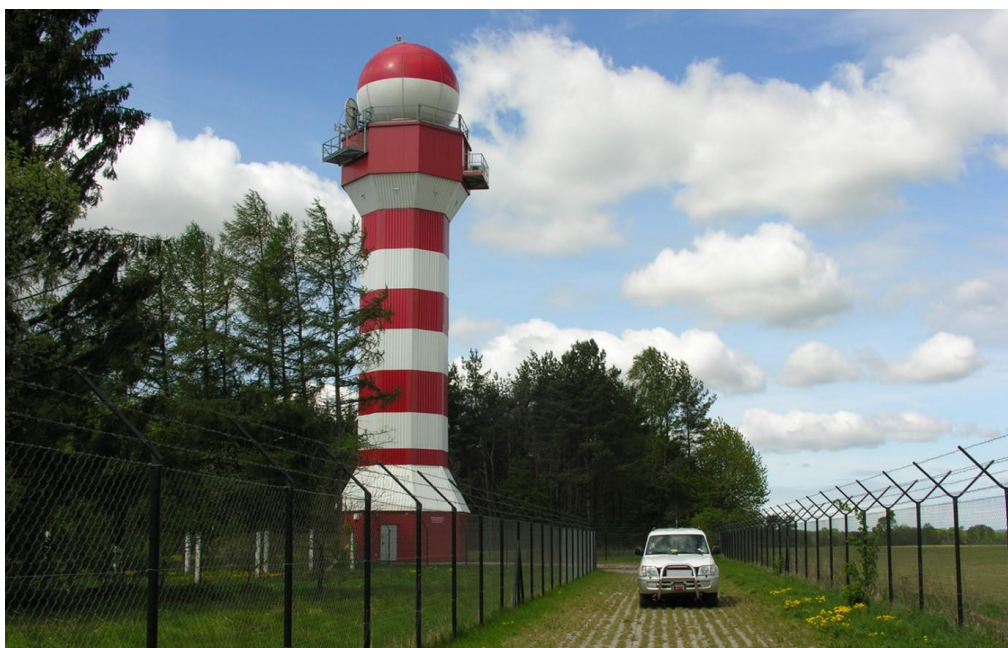
Fotografia 4 Lokalizacja stacji radarowej Świdwin - widok ogólny
