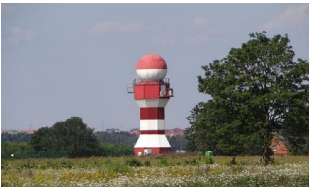
Fotografia 12 Lokalizacja stacji radarowej Gdańsk Rębichowo - widok ogólny
