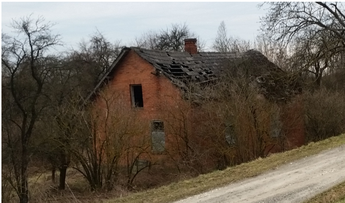
Fot. 4 Budynek do rozbiórki (dz. 975 obręb Wrzawy).
