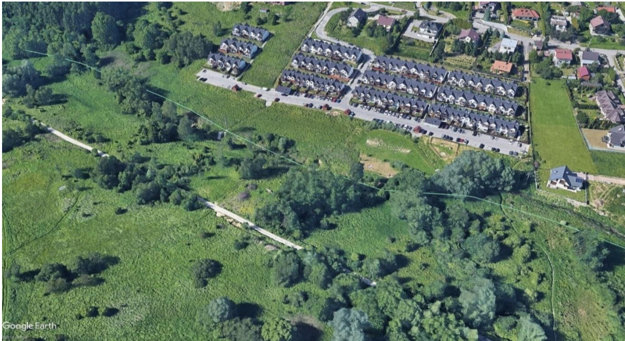
Rysunek 4. Stan istniejący – osiedle Secesja i teren, na którym będzie realizowana czasza zbiornika Malinówka 3
