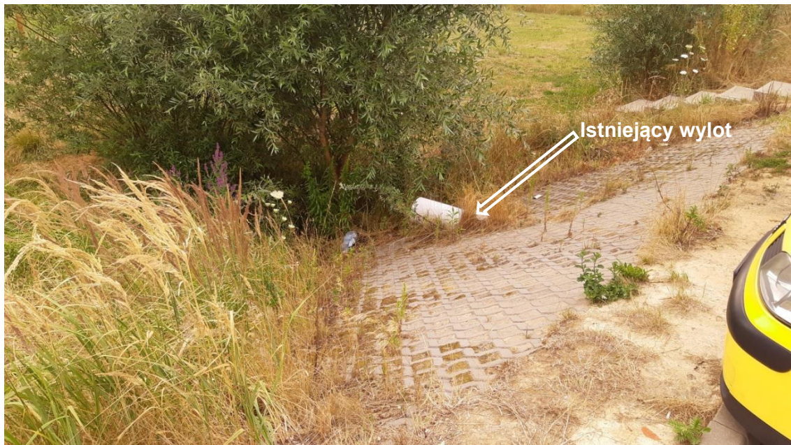
Zdjęcie 4. Istniejący wylot wód deszczowych z osiedla na teren nadrzeczny potoku Malinówka (wylot zostanie przebudowany a przepustowość kanalizacji deszczowej zwiększona).
