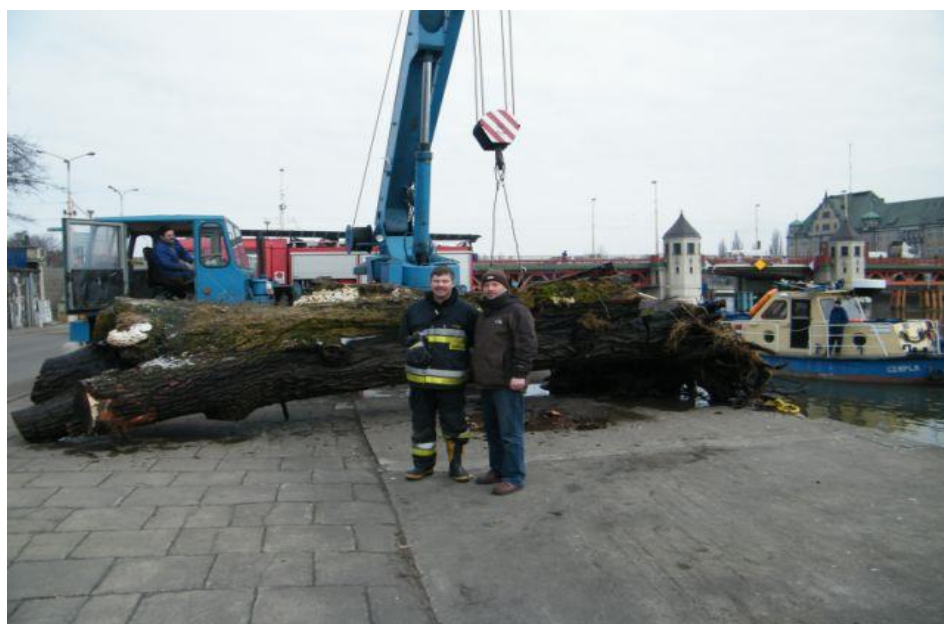
Zdjęcie 23 Usuwanie przeszkód nawigacyjnych z koryta rzeki po przejściu lodów
