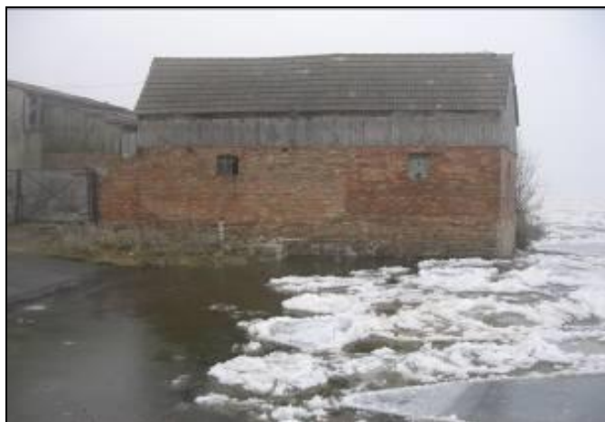
Zdjęcie 5 Przekroczony stan alarmowy w m. Bielinek
