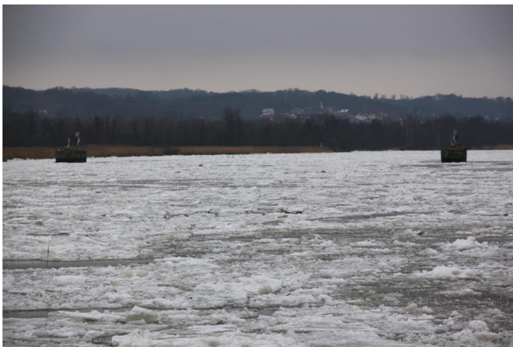
Zdjęcie 47 Stare filary po moście kolejowym na rzece Regalicy w Szczecinie, przyczyna częstego zatrzymywania spływającego lodu z góry rzeki.
