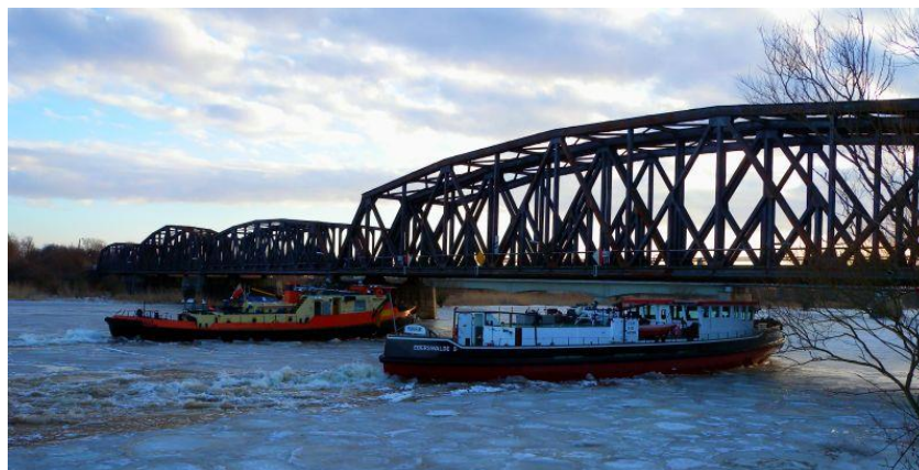
Rysunek 13 Lodołamacze przepływają pod mostem kolejowym w Kostrzynie nad Odrą (km 615,1 (źródło RZGW Szczecin)
