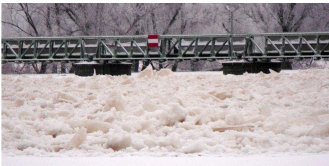
Zdjęcie 33 Struktura lodu zatorowego przy jazie w Widuchowej km 704,1
