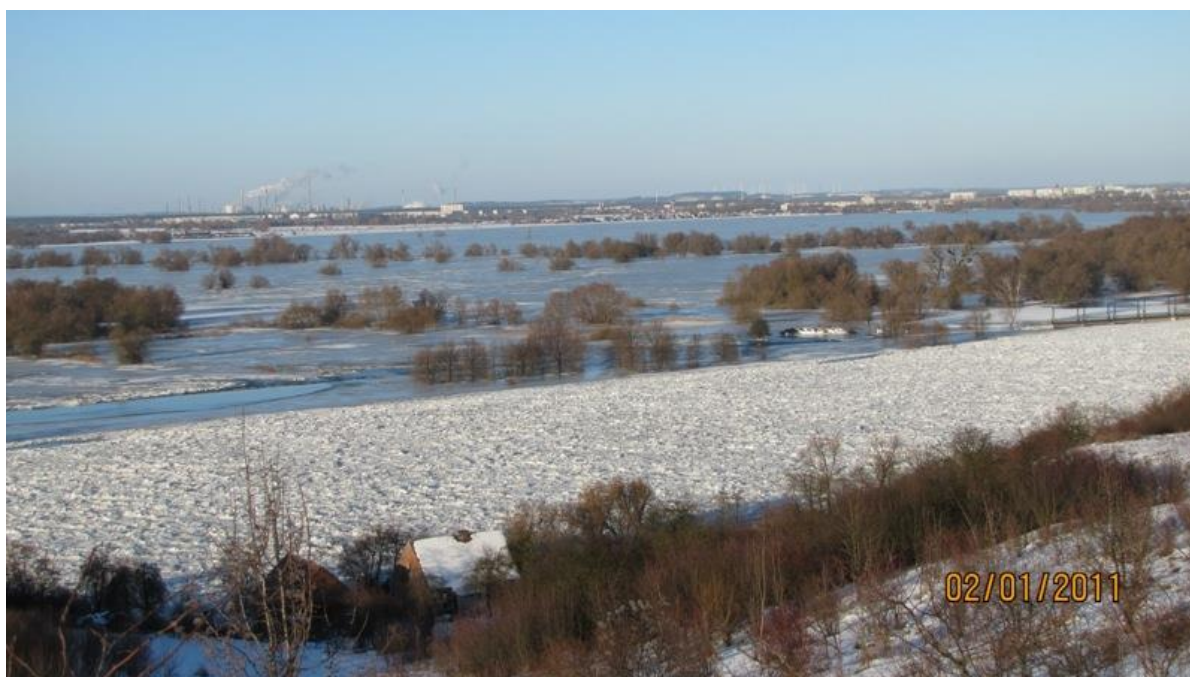
Zdjęcie 35 Przerwany wał letni na polder na wysokości Zatoni Dolnej
