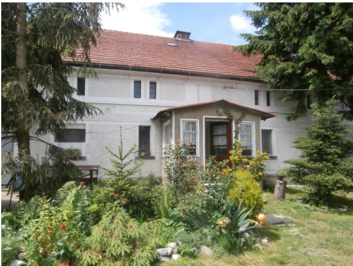
Rysunek 7 - Budynek mieszkalny do rozbiórki, Szalejów Dolny 71
