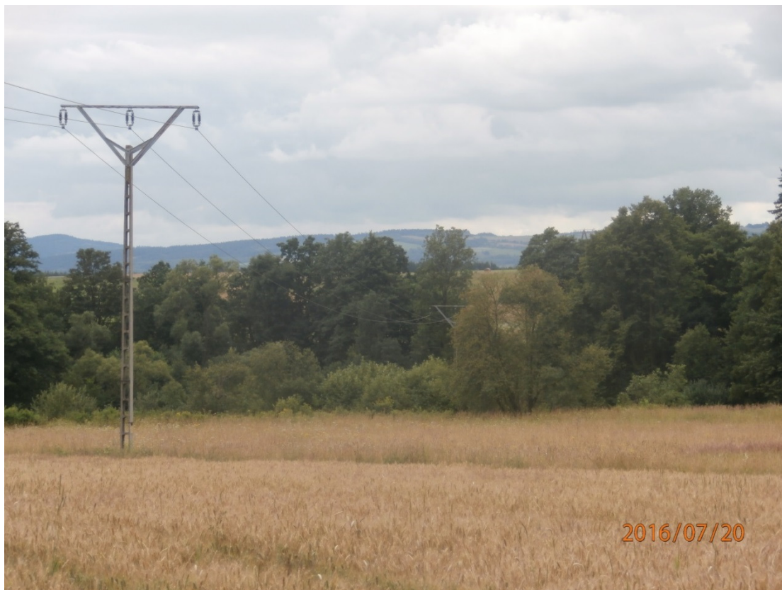
Rysunek 5 - Linia energetyczna SN przebiegająca w kierunku północ- południe na obszarze czasy zbiornika.
