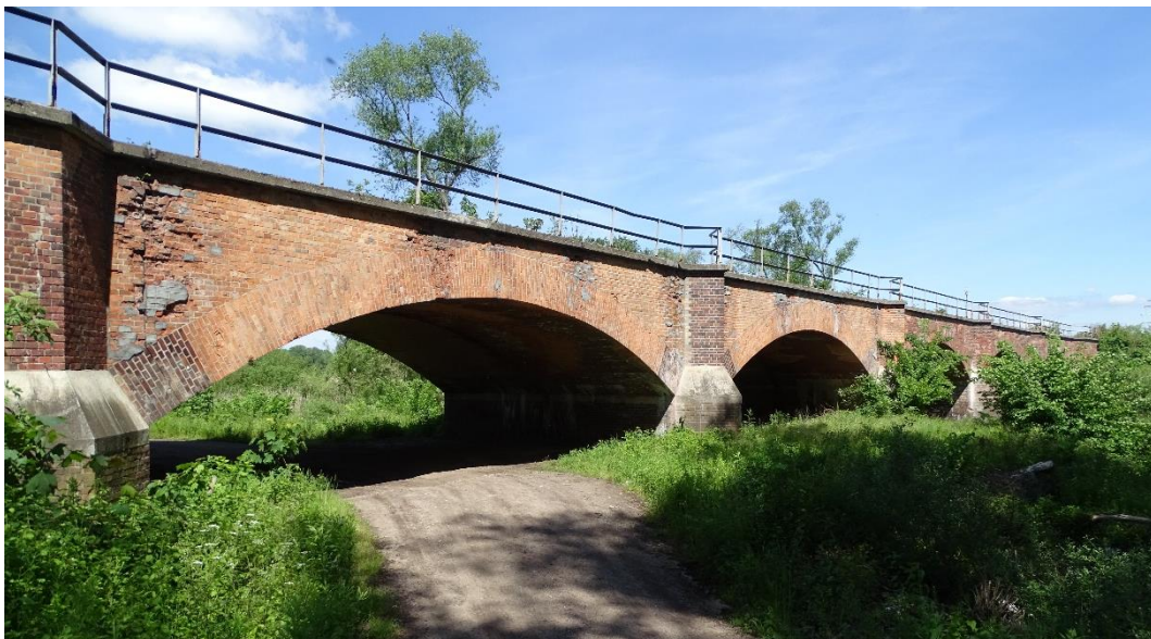
Fot. 1 Widok na fragment mostu nad Suchodołem w km 341,872 linii kolejowej nr 203
