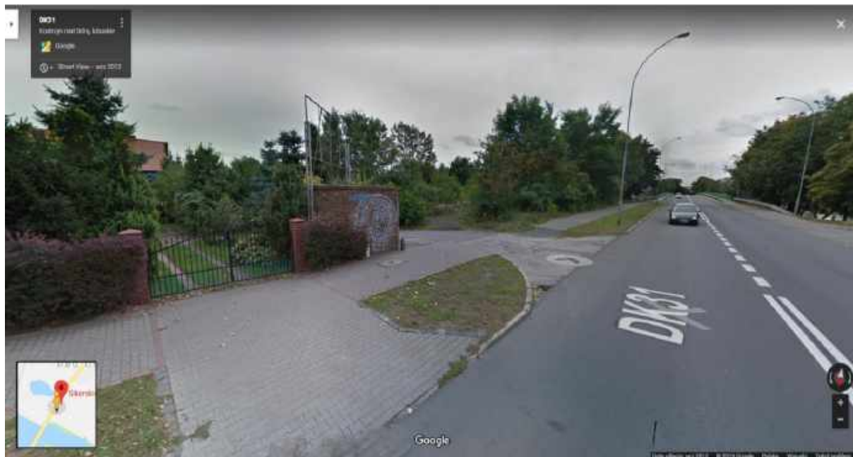
Widok na ulicę Sikorskiego, po lewej stronie nieruchomość podlegająca wykupowi na wniosek właścicieli – źródło: maps.google.com
