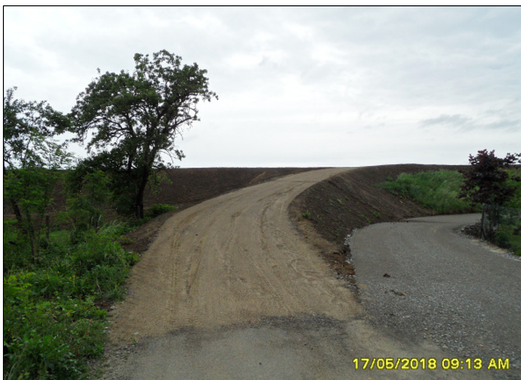
Fot. 24. Przejazd wałowy od strony odpowietrznej, ok. km 8+220 (maj 2018).
