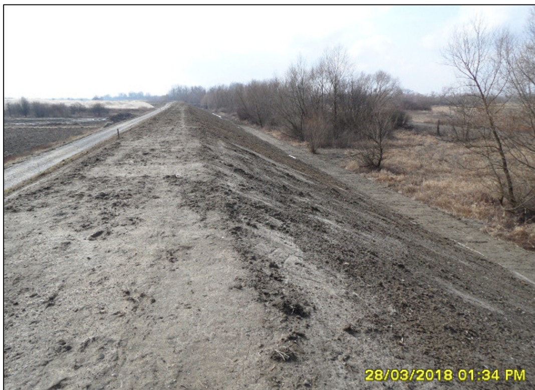
Fot. 13. Uformowana skarpa odwodna wału, ok. km 9+550 (marzec 2018).
