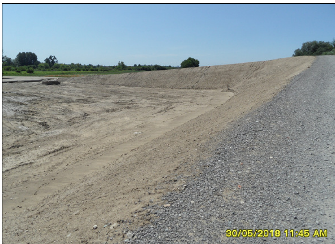
Fot. 31. Przejazd wałowy po zakończeniu robót budowlanych, ok. km 9+980 (maj 2018).
