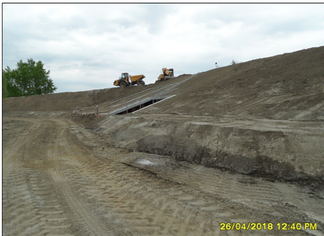
Fot. 19. Formowanie przejazdu wałowego, ok. km 12+860 (kwiecień 2018).
