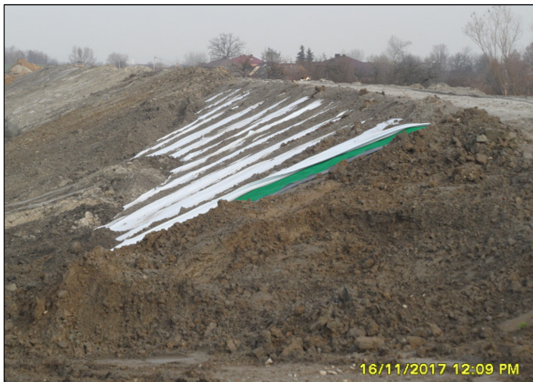
Fot. 1. Montaż przesłony przeciwfiltracyjnej w skarpie wału, ok. km 8+300 (listopad 2017).
