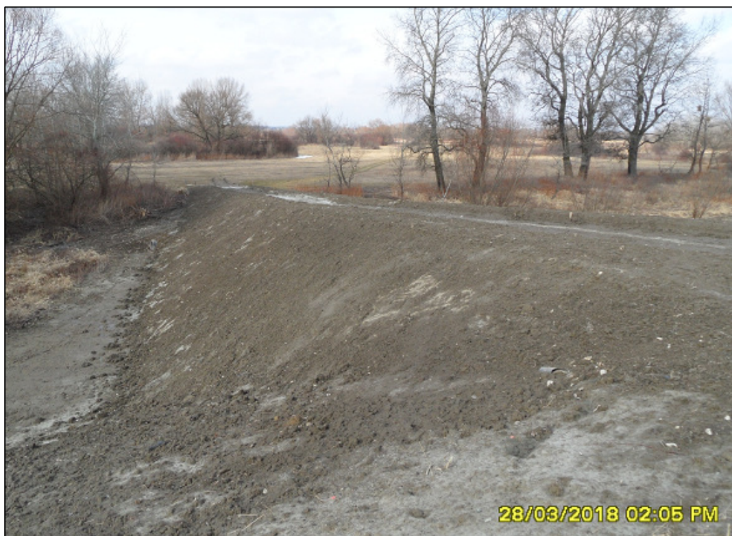
Fot. 14. Uformowana skarpa przejazdu wałowego, ok. km 10+960 (marzec 2018).
