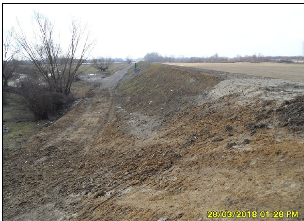
Fot. 12. Uformowana skarpa odpowietrzna wału, ok. km 8+250 (marzec 2018).
