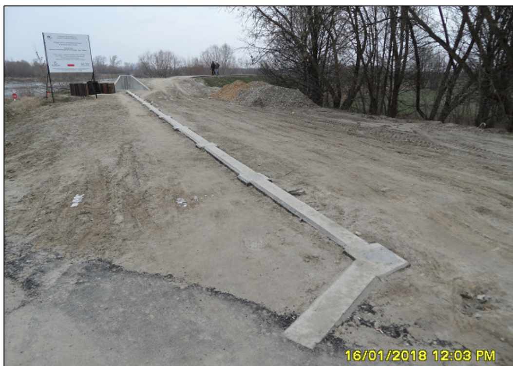
Fot. 4. Fundament pod zabezpieczenie mobilne, ok. km 15+700 (styczeń 2018).
