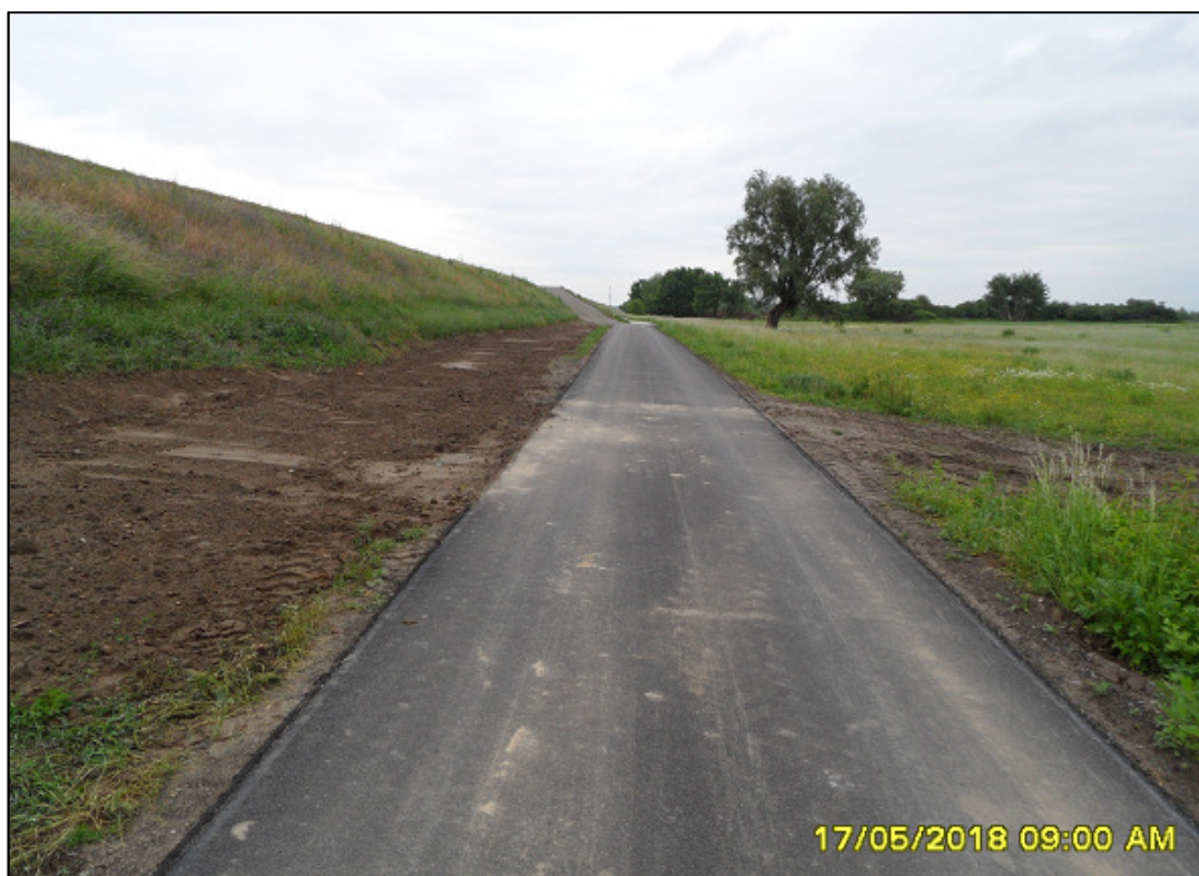
Fot. 22. Droga technologiczna asfaltowa po stronie odpowietrznej, ok. km 7+550 (maj 2018).
