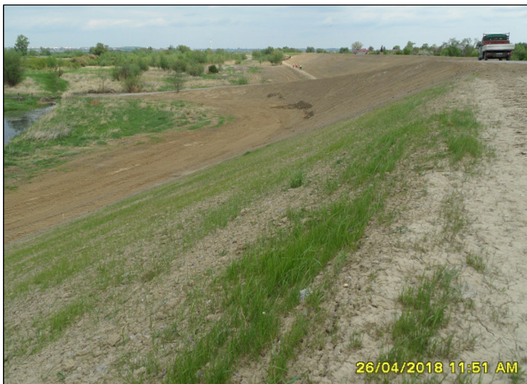
Fot. 15. Skarpa odwodna wału po obsiewie i przejazd wałowy, ok. km 8+250 (kwiecień 2018).
