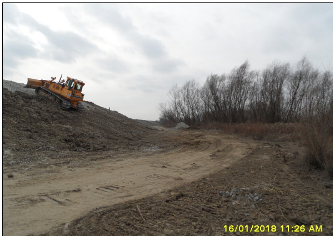
Fot. 7. Formowanie skarpy wału, ok. km 12+900 (styczeń 2018).
