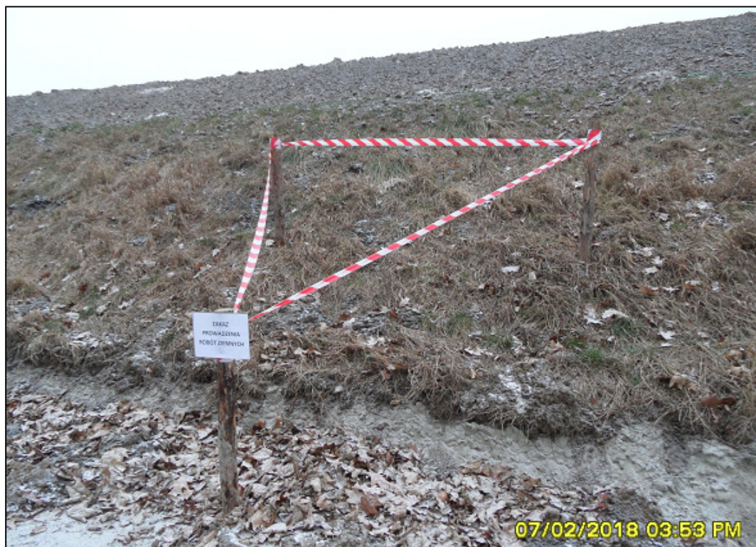
Fot. 8. Zabezpieczone i oznakowane miejsce zimowania płazów, ok. km 15+200 (luty 2018).
