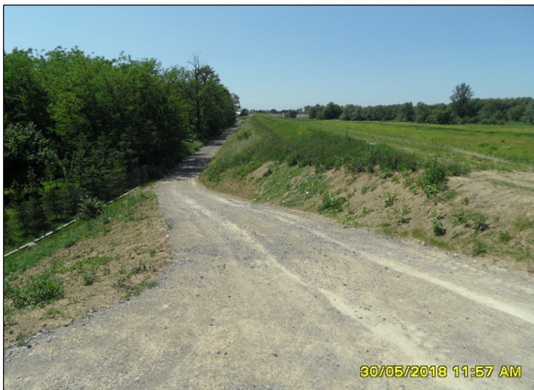
Fot. 33. Przejazd wałowy i fragment drogi technologicznej, ok. km 12+000 (maj 2018).
