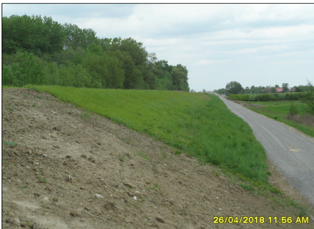
Fot. 16. Skarpa odpowietrzna wału i droga technologiczna, ok. km 9+550 (kwiecień 2018).
