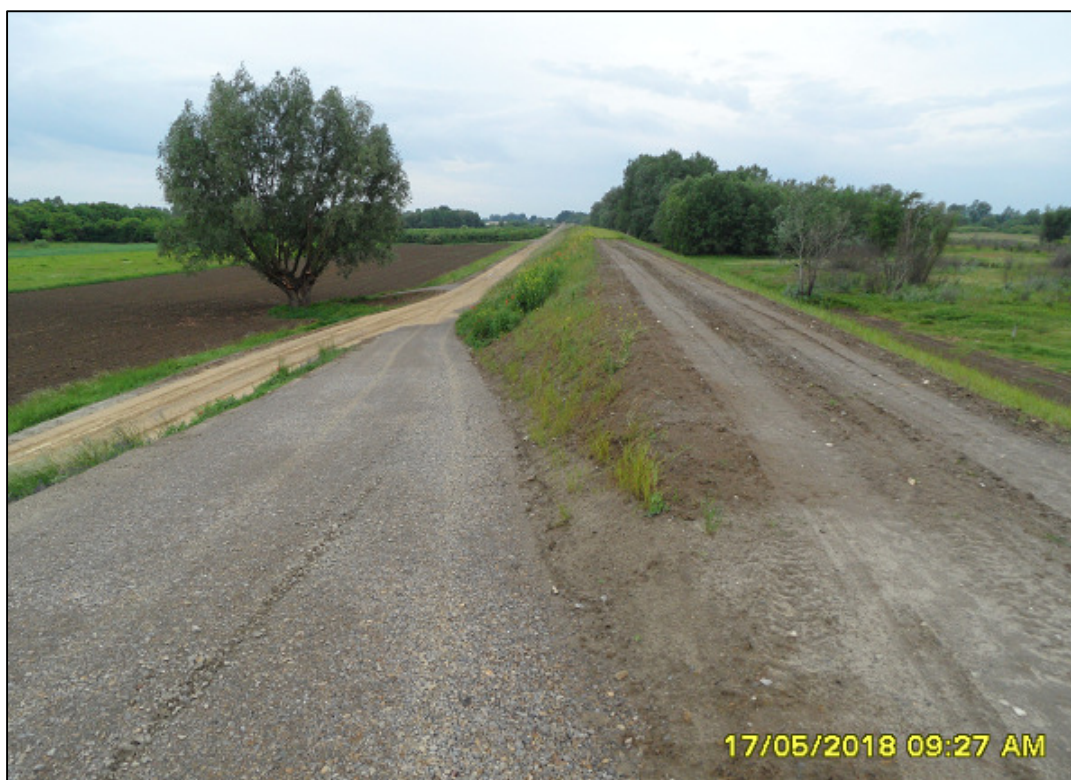
Fot. 25. Skarpa odpowietrzna wału i fragment przejazdu wałowego, ok. km 8+700 (maj 2018).
