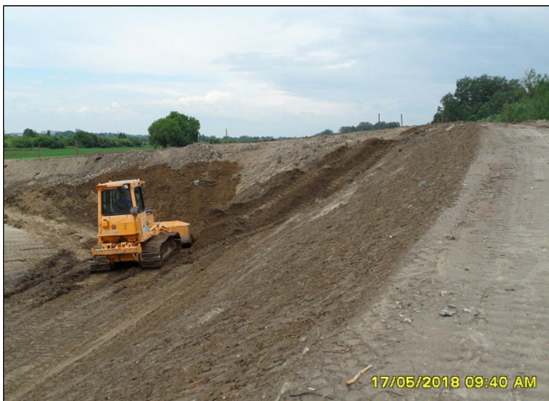
Fot. 21. Formowanie skarpy przejazdu wałowego, ok. km 9+980 (maj 2018).
