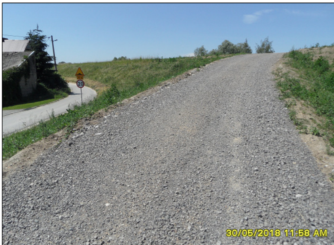
Fot. 34. Przejazd wałowy po zakończeniu robót budowlanych, ok. km 12+330 (maj 2018).
