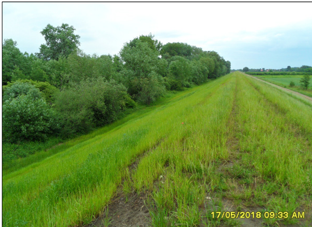
Fot. 26. Fragment korony i skarpy odwodnej wału, ok. km 9+500 (maj 2018).
