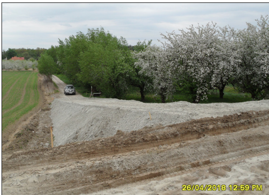
Fot. 20. Przejazd wałowy w trakcie przebudowy, ok. km 14+270 (kwiecień 2018).
