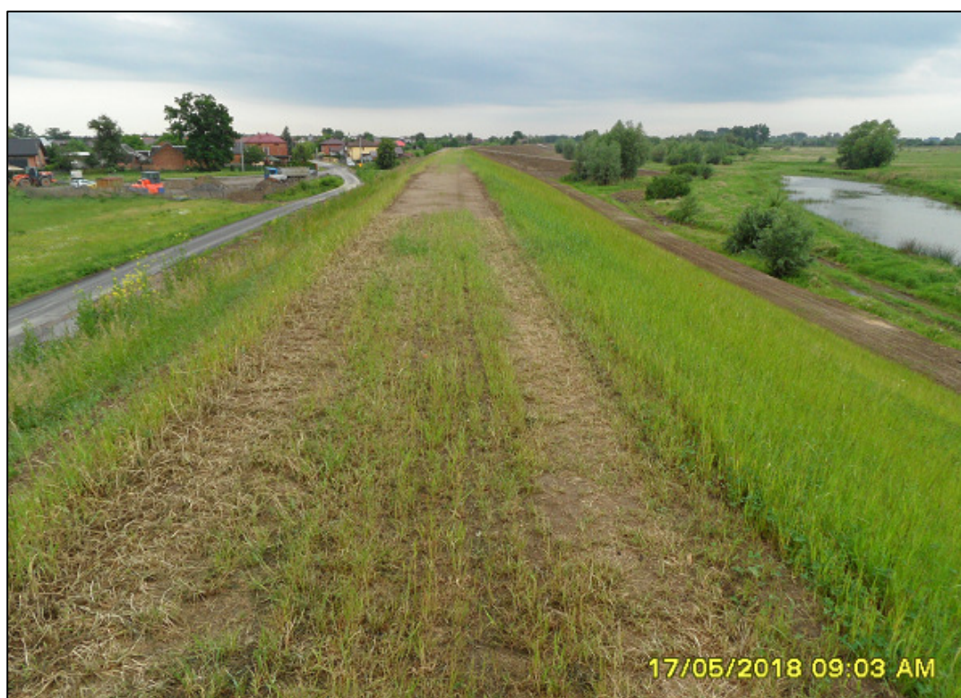
Fot. 28. Korona wału po modernizacji, ok. km 7+500 (maj 2018).
