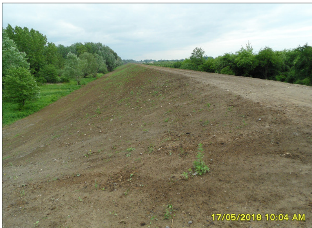
Fot. 29. Skarpa odwodna i fragment korony wału, ok. km 11+950 (maj 2018).
