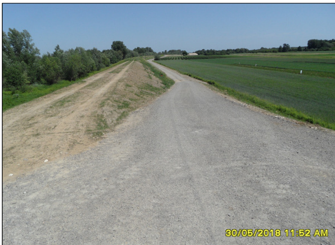
Fot. 32. Przejazd wałowy po zakończeniu robót budowlanych, ok. km 10+960 (maj 2018).
