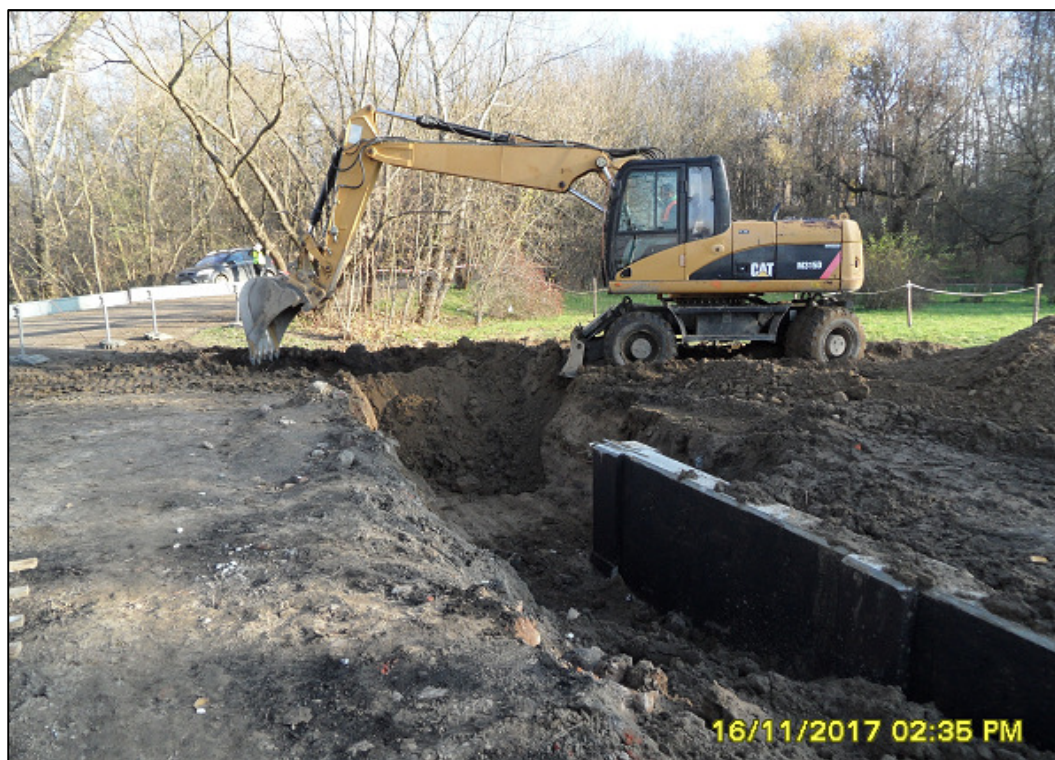
Fot. 2. Roboty ziemne przy budowie zabezpieczenia mobilnego, ok. km 15+750 (listopad 2017).
