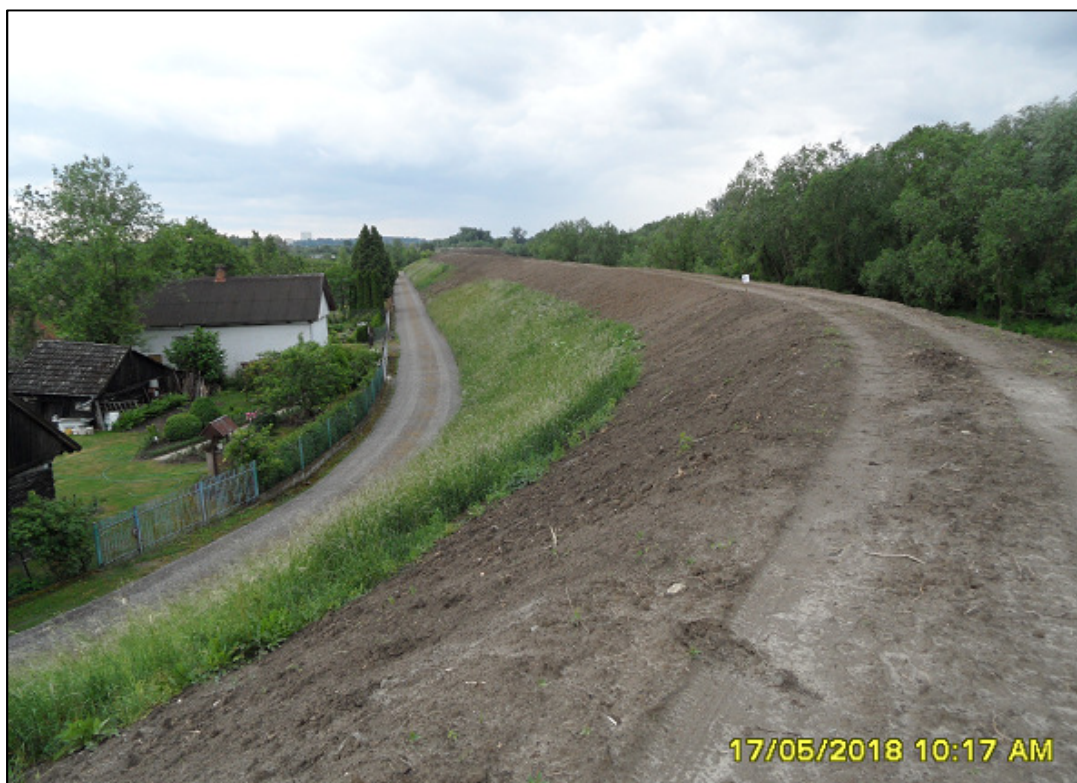
Fot. 30. Skarpa odpowietrzna i fragment korony wału, ok. km 12+900 (maj 2018).
