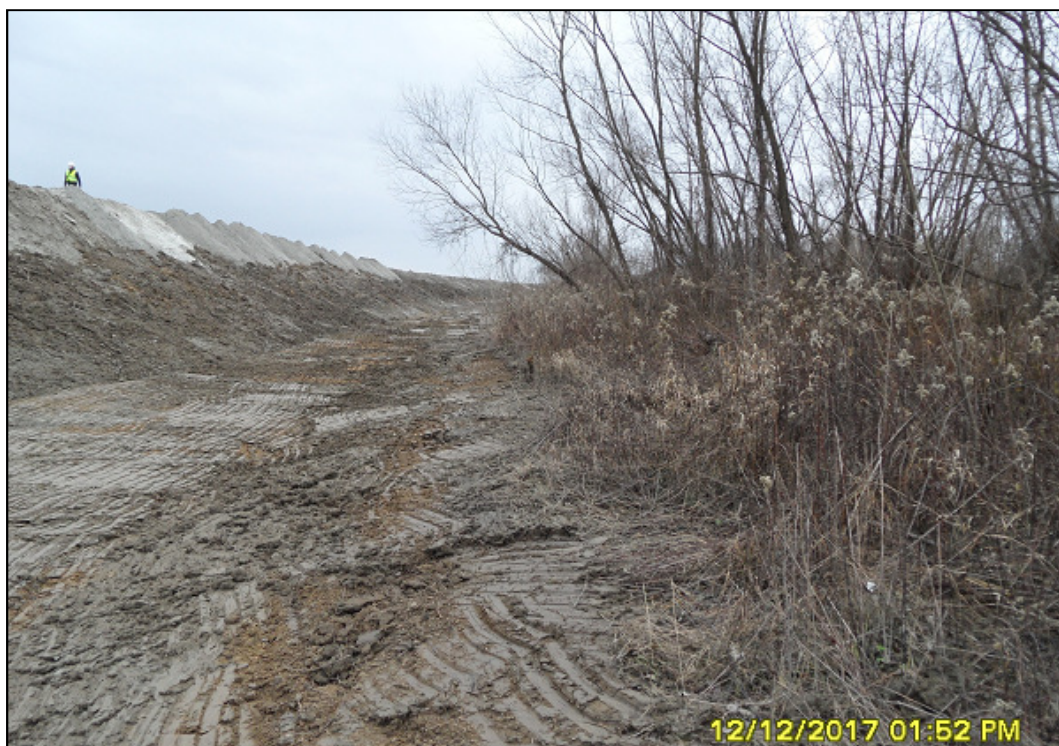
Fot. 9. Uformowana skarpa odwodna wału, ok. km 13+000 (grudzień 2017).
