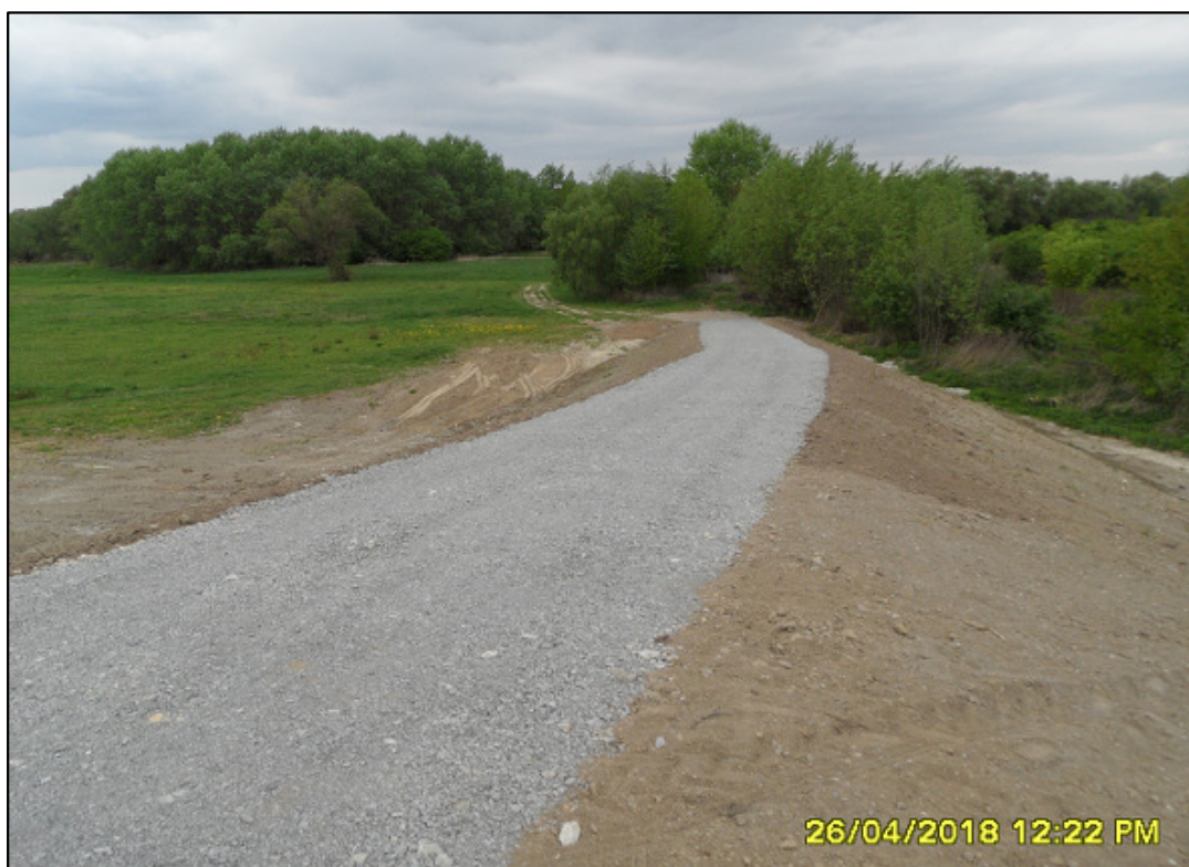
Fot. 18. Przejazd wałowy po stronie odwodnej wału, ok. km 10+960 (kwiecień 2018).
