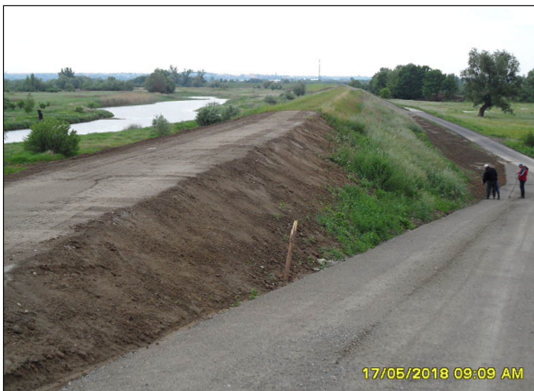
Fot. 23. Skarpa odpowietrzna wału i fragment przejazdu wałowego, ok. km 7+650 (maj 2018).
